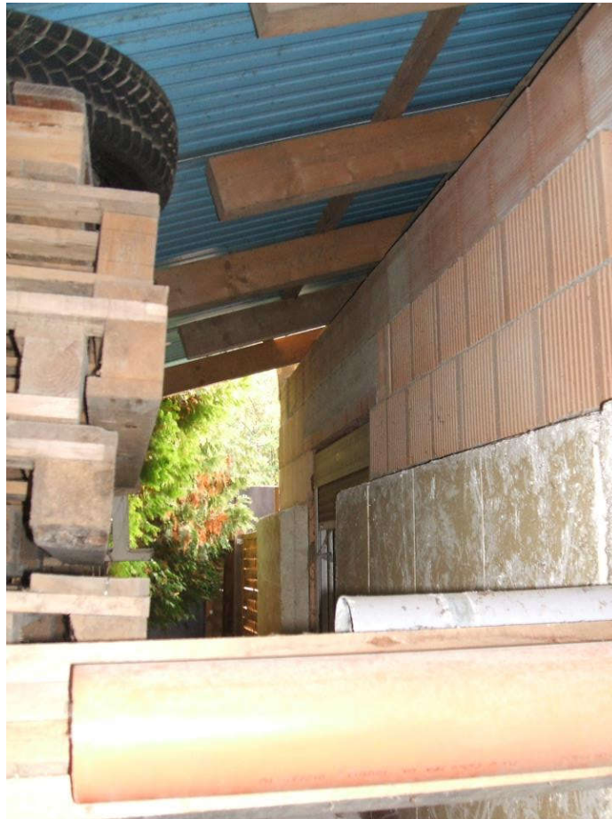
Foto 9: Hallenteil, Nordseite, Westansicht aufgenommen am 27.10.2022
