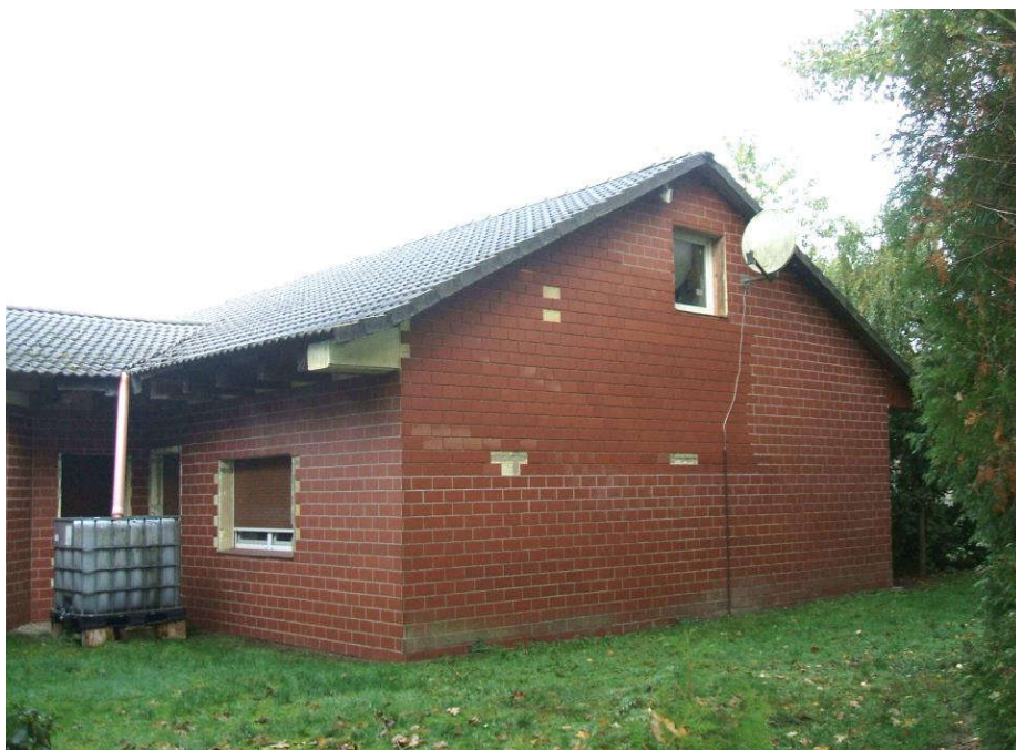
Foto 4: Einfamilienhaus, Südostansicht aufgenommen am 27.10.2022
