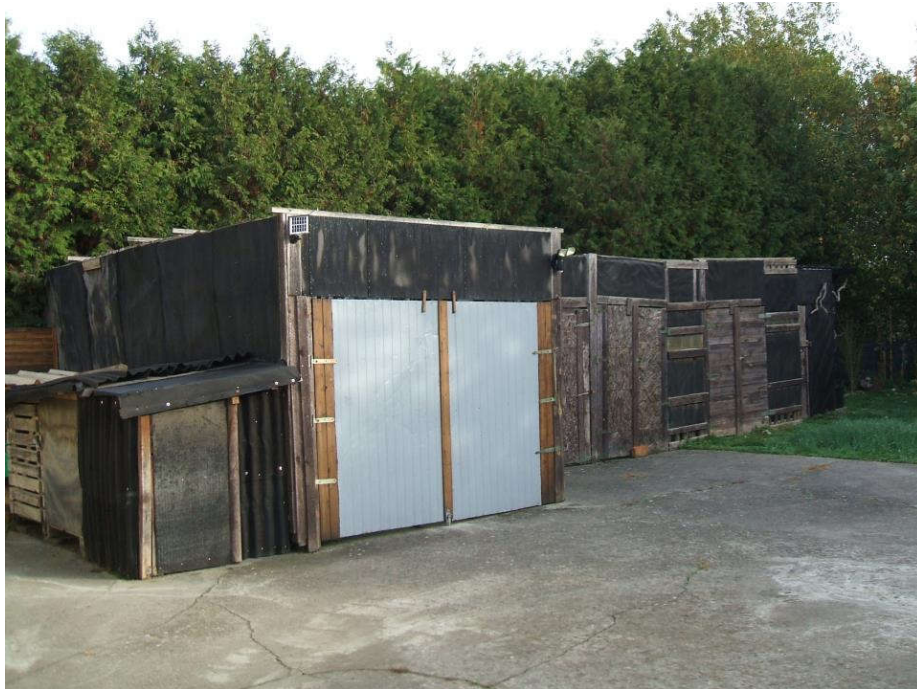
Foto 10: Schuppen/ Abtrennungen im nördlichen Grundstücksbereich, Südwestansicht aufgenommen am 27.10.2022
