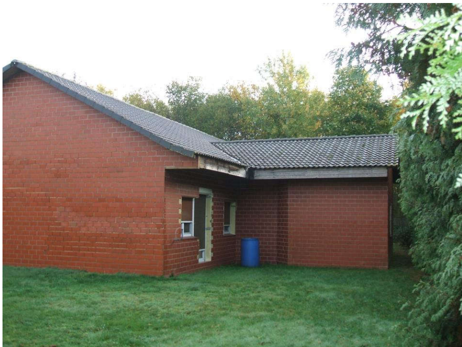
Foto 2: Einfamilienhaus, Südwestansicht aufgenommen am 27.10.2022
