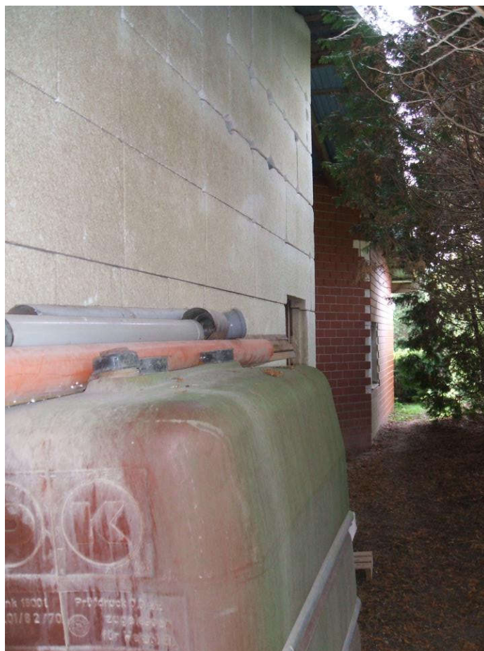
Foto 8: Hallenteil, Westseite, Nordansicht aufgenommen am 27.10.2022
