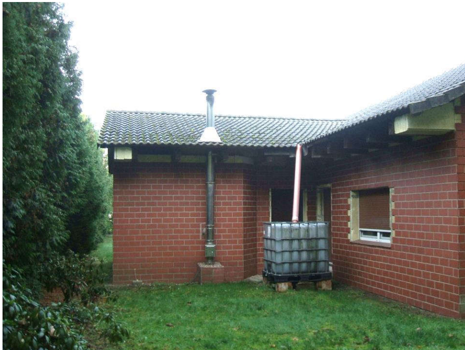
Foto 3: Einfamilienhaus, Südostansicht aufgenommen am 27.10.2022
