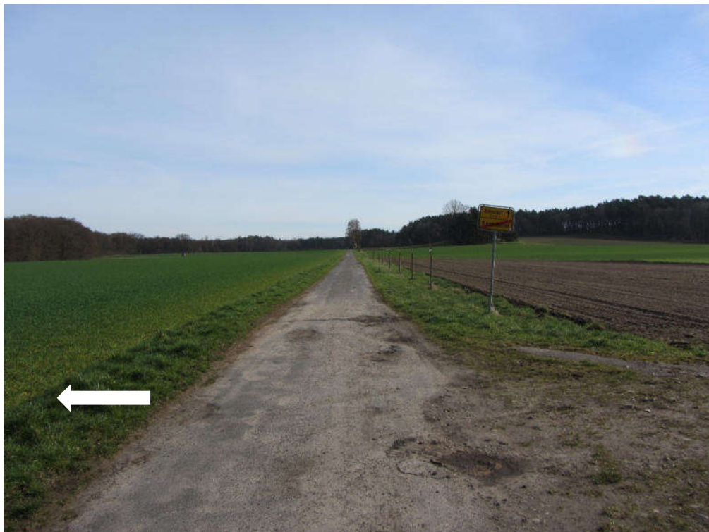
Abbildung 10: Gemeindestraße, Blickrichtung Osten
