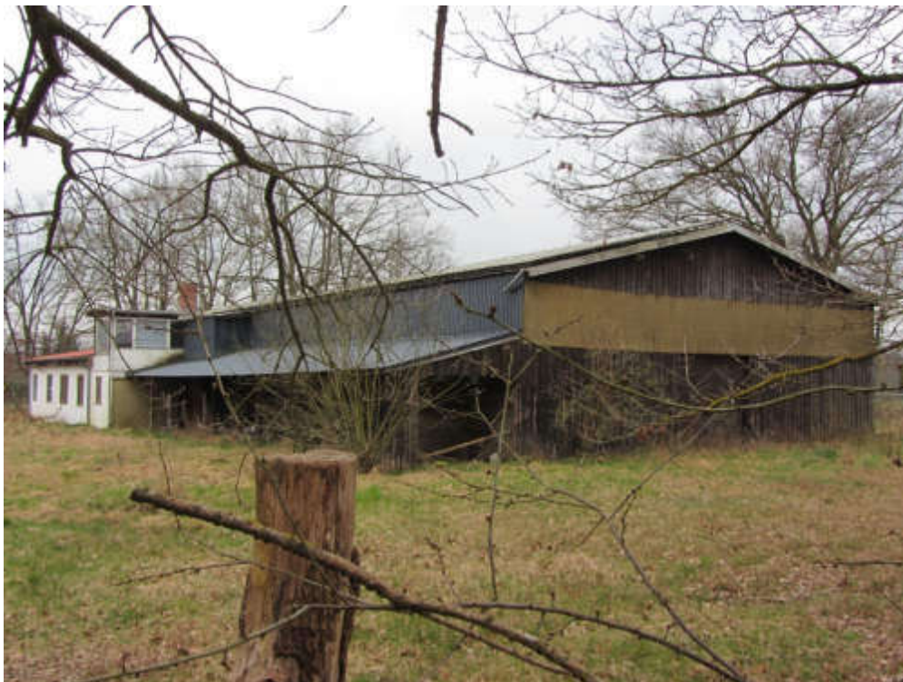
Abbildung 50: Reithalle, Ansicht aus Norden
