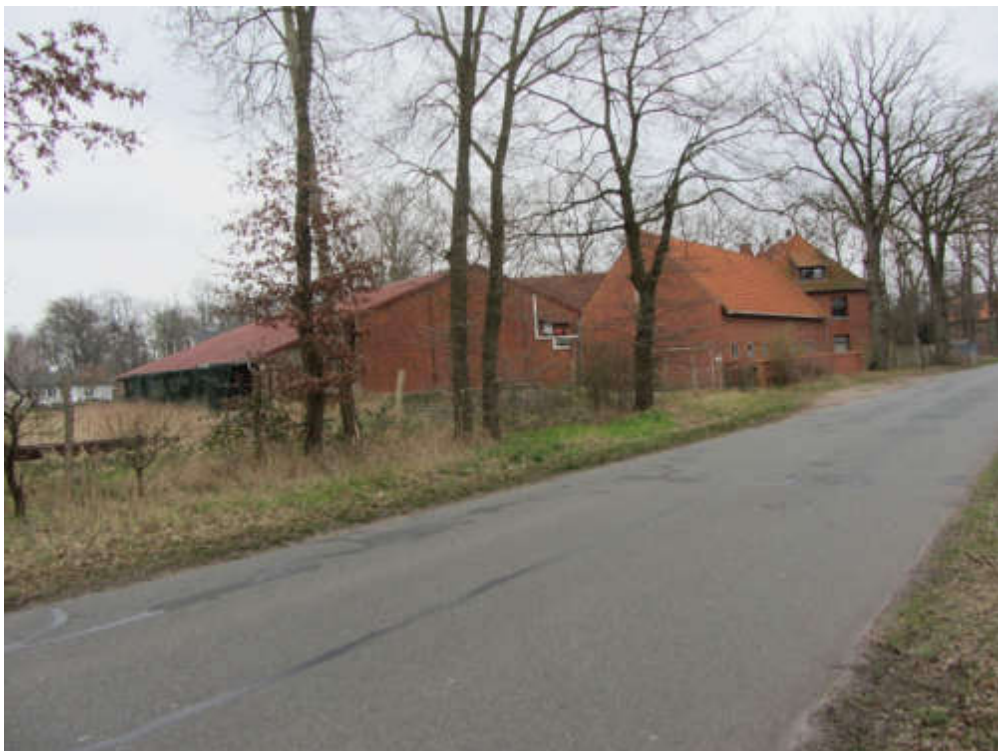
Abbildung 46: Ansicht aus Nordwesten
