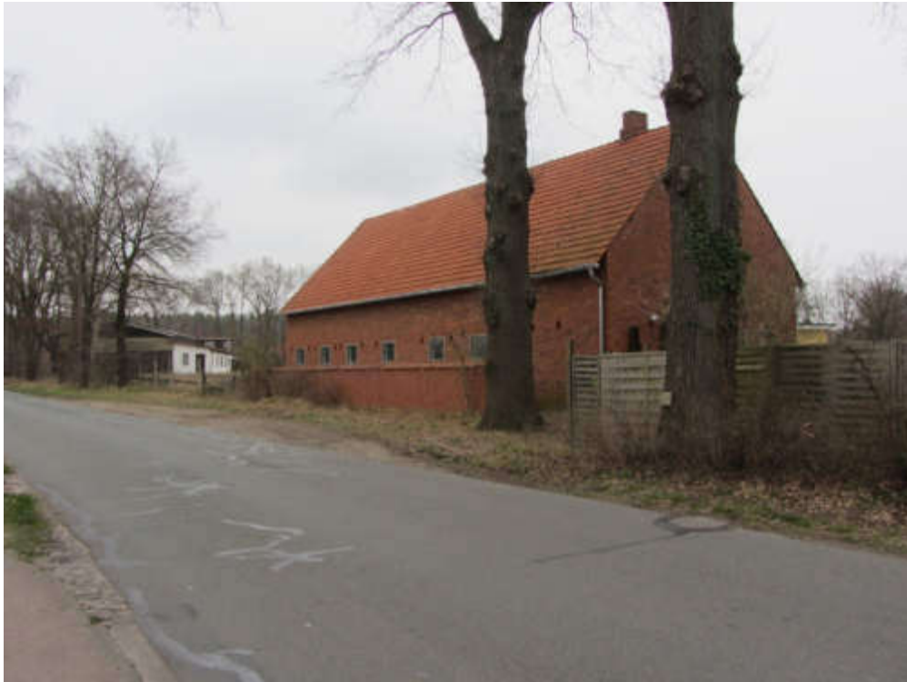
Abbildung 45: Pferdestall, Ansicht von der Straße „Seyerberg“ aus Süden
