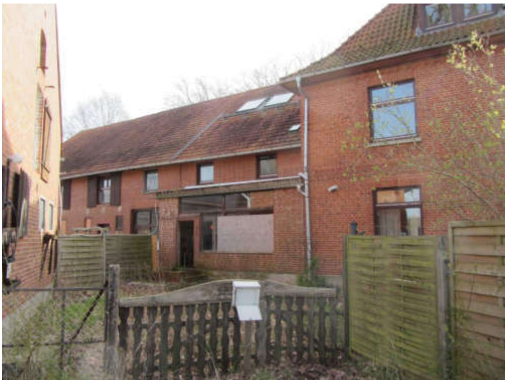
Abbildung 42: Wohnhaus, Ansicht aus Nordwesten
