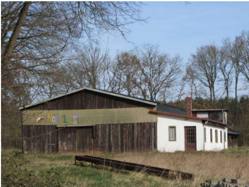
Abbildung 10: Reithalle (D), Ansicht von der Straße aus Süden
