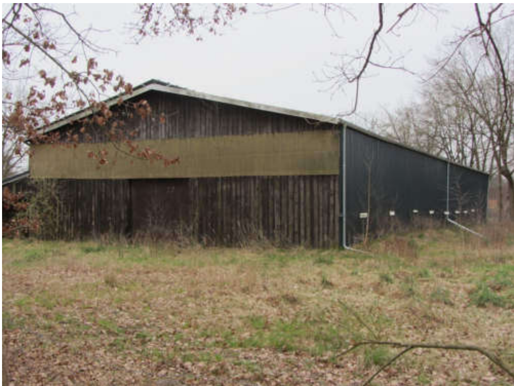
Abbildung 52: Ansicht aus Nordwesten
