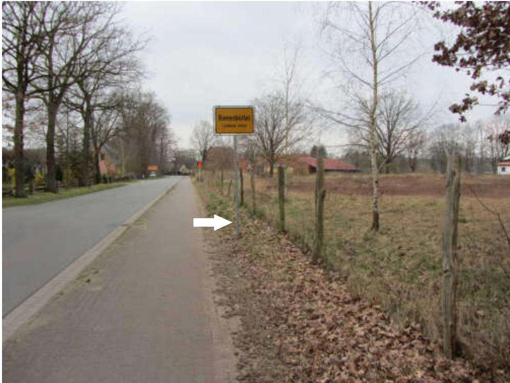
Abbildung 13: Kreisstraße „Niendorfer Straße“, Blickrichtung Südwesten
