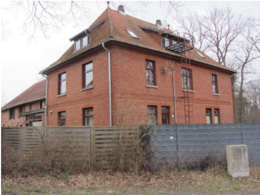
Abbildung 41: Wohnhaus, Ansicht aus Westen
