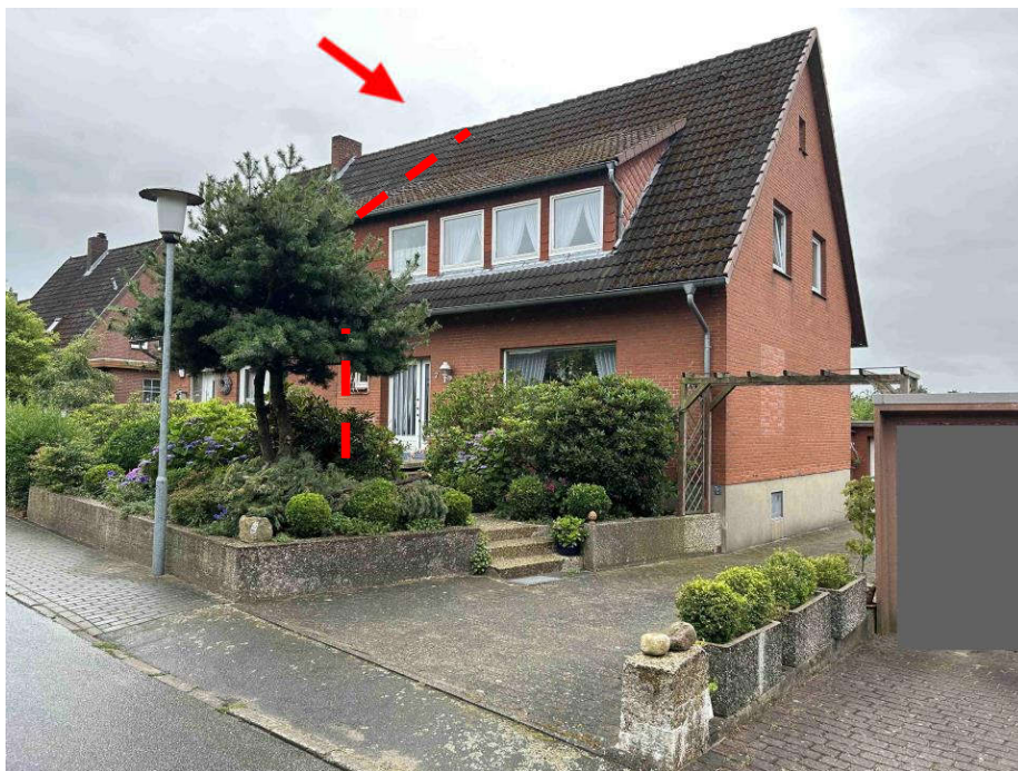
Foto 1: Teil eines Doppelhauses, Nordwestansicht aufgenommen am 04.07.2024
