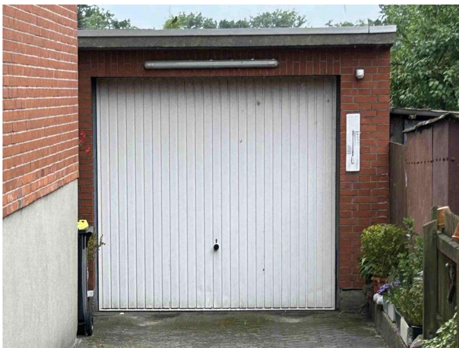
Foto 2: Garage, Nordansicht aufgenommen am 04.07.2024
