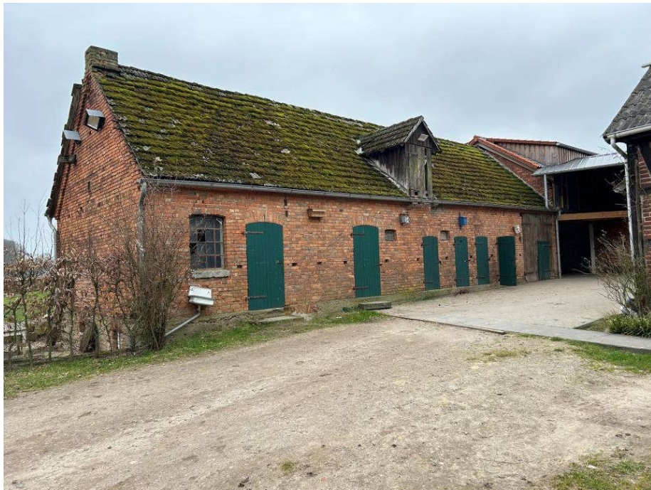
Foto 15: Stallgebäude, Nordostansicht aufgenommen am 07.03.2024
