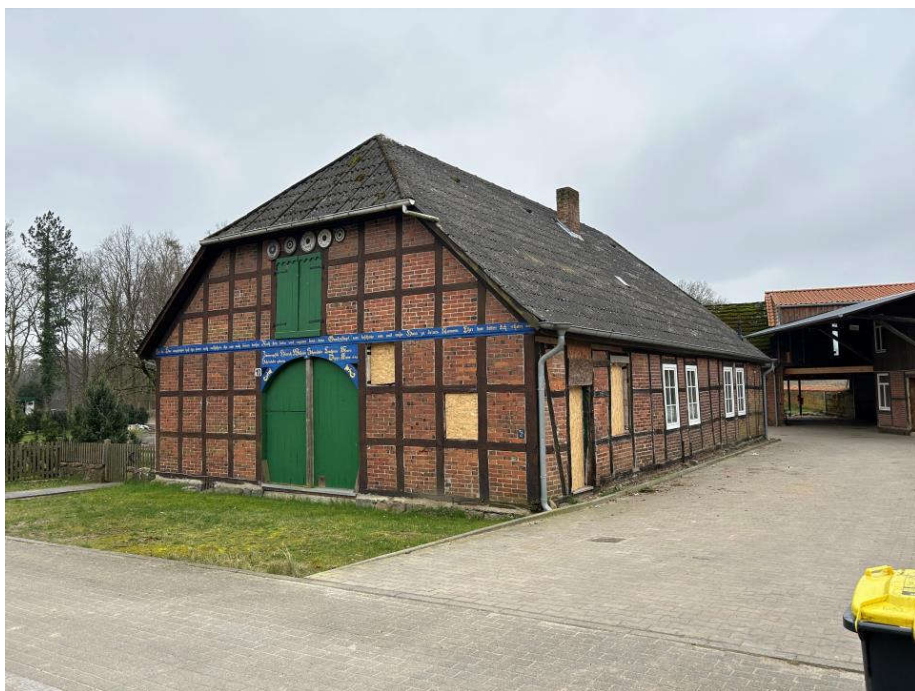
Foto 4: Wohnhaus, Nordostansicht aufgenommen am 07.03.2024
