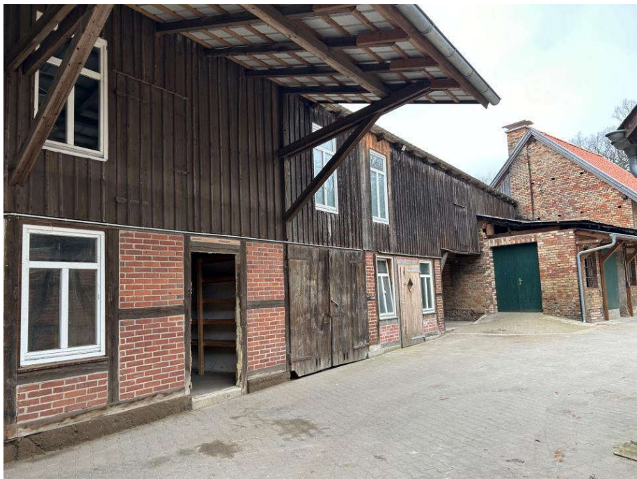
Foto 11: Werkstatt/ Lager, Südostansicht aufgenommen am 07.03.2024
