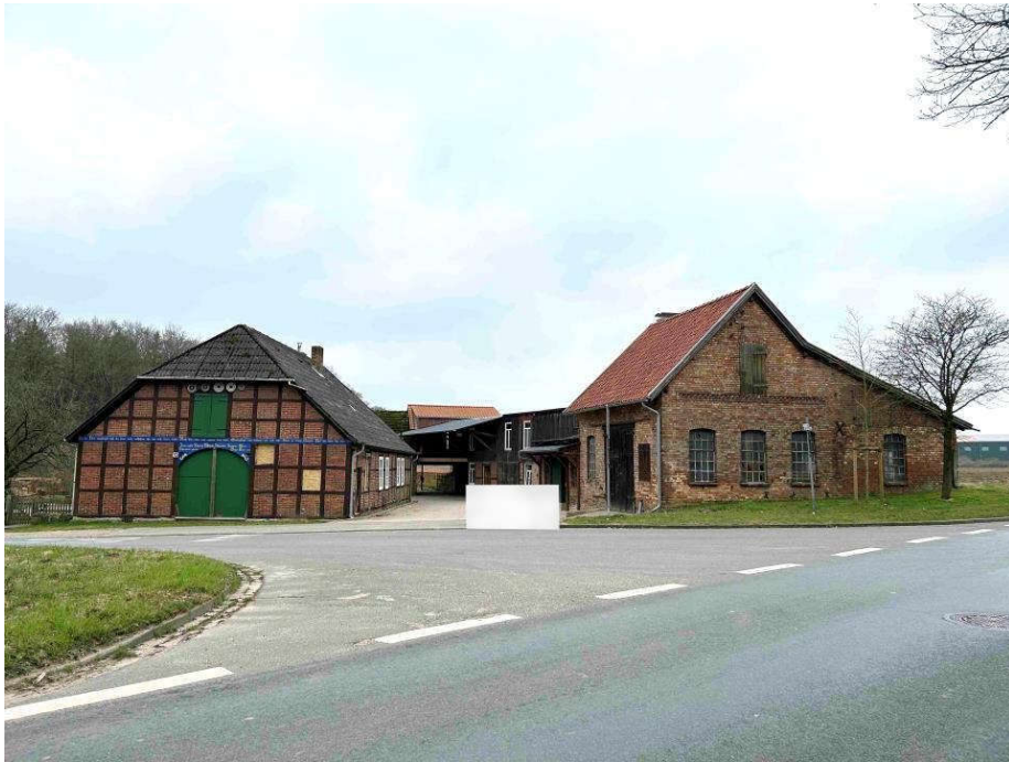
Foto 1: Westteil mit Wohnhaus und Werkstatt/Lager, Nordostansicht aufgenommen am 07.03.2024
