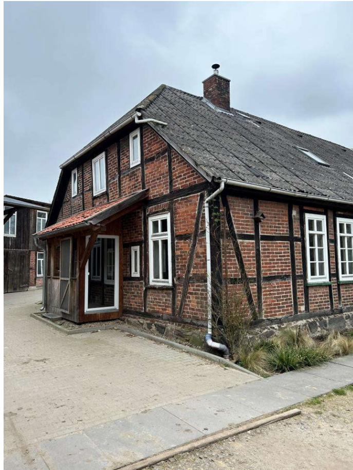
Foto 5: Wohnhaus, Südostansicht aufgenommen am 07.03.2024
