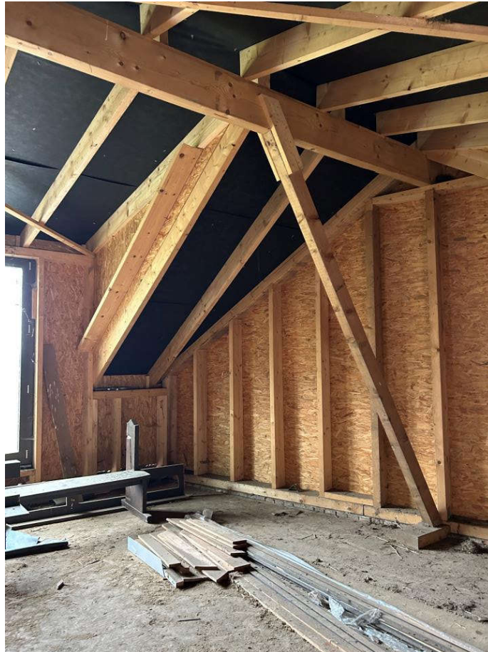
Foto 18: Stallgebäude, Innenaufnahme Dachraum über dem Offenstall aufgenommen am 07.03.2024
