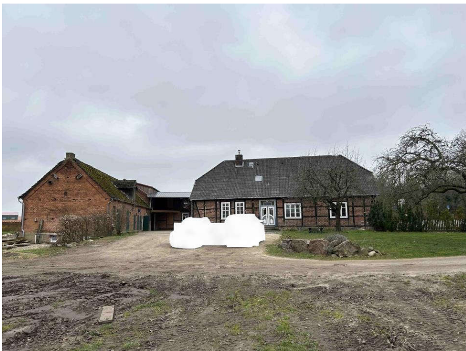
Foto 2: Westteil mit Wohnhaus und Stallgebäude, Südostansicht aufgenommen am 07.03.2024
