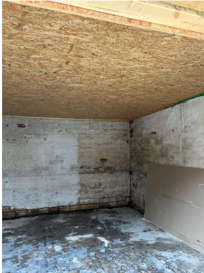
Foto 14: Werkstatt/ Lager, Innenaufnahme Lagerbereich aufgenommen am 07.03.2024
