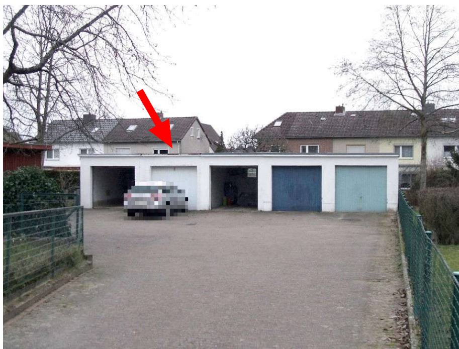
Foto 4: Garage (B), Westansicht aufgenommen am 29.01.2021
