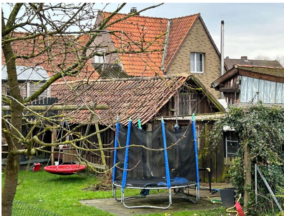
Foto 5: Wohnhaus, Nordostansicht mit Schuppen an östlicher Grenze des Flurstücks 43/10 zu Flurstück 43/55 aufgenommen am 14.03.2024
