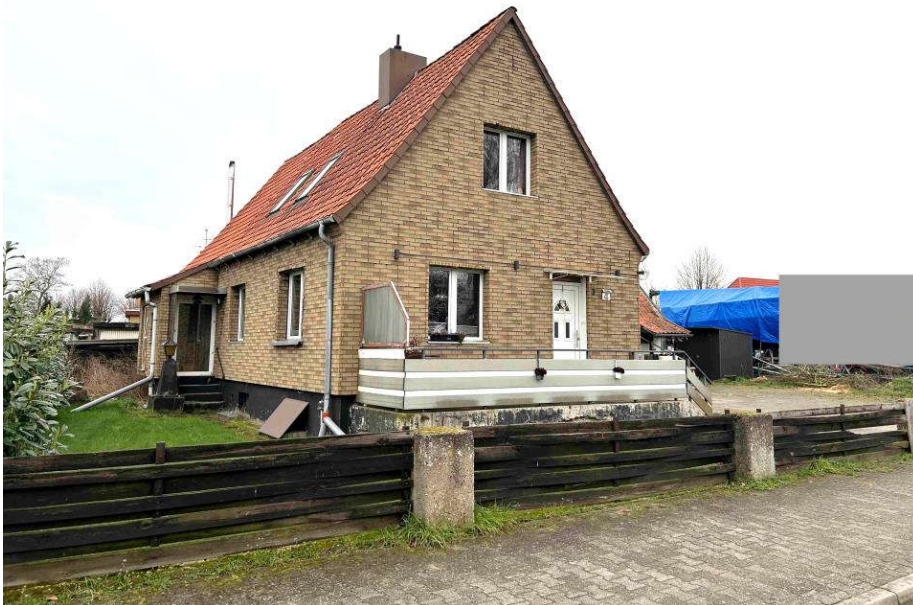
Foto 1: Wohnhaus, Südwestansicht aufgenommen am 14.03.2024
