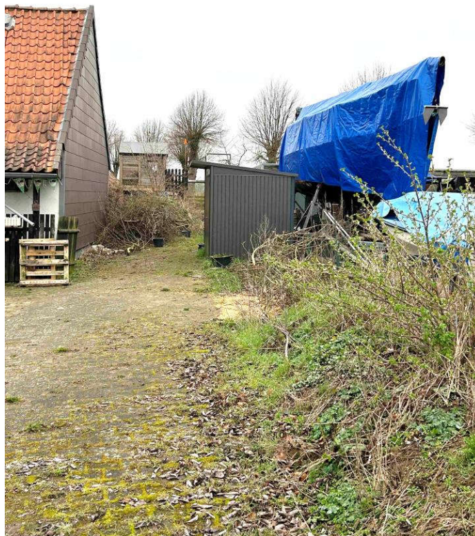
Foto 3: Flurstück 43/55, Südansicht aufgenommen am 14.03.2024
