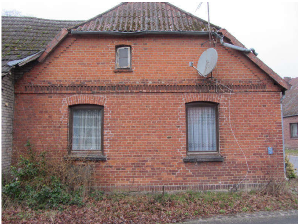
Abbildung 34: Westgiebel des ausgebauten Wohntraktes
