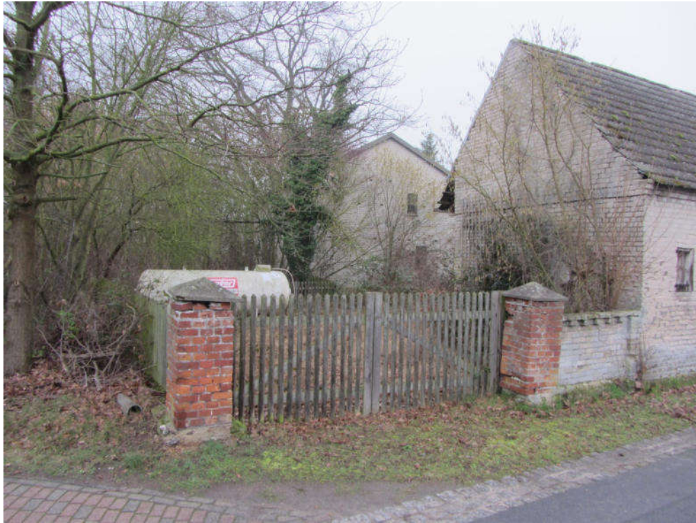
Abbildung 40: südöstlicher Grundstücksbereich mit Einfahrtstor
