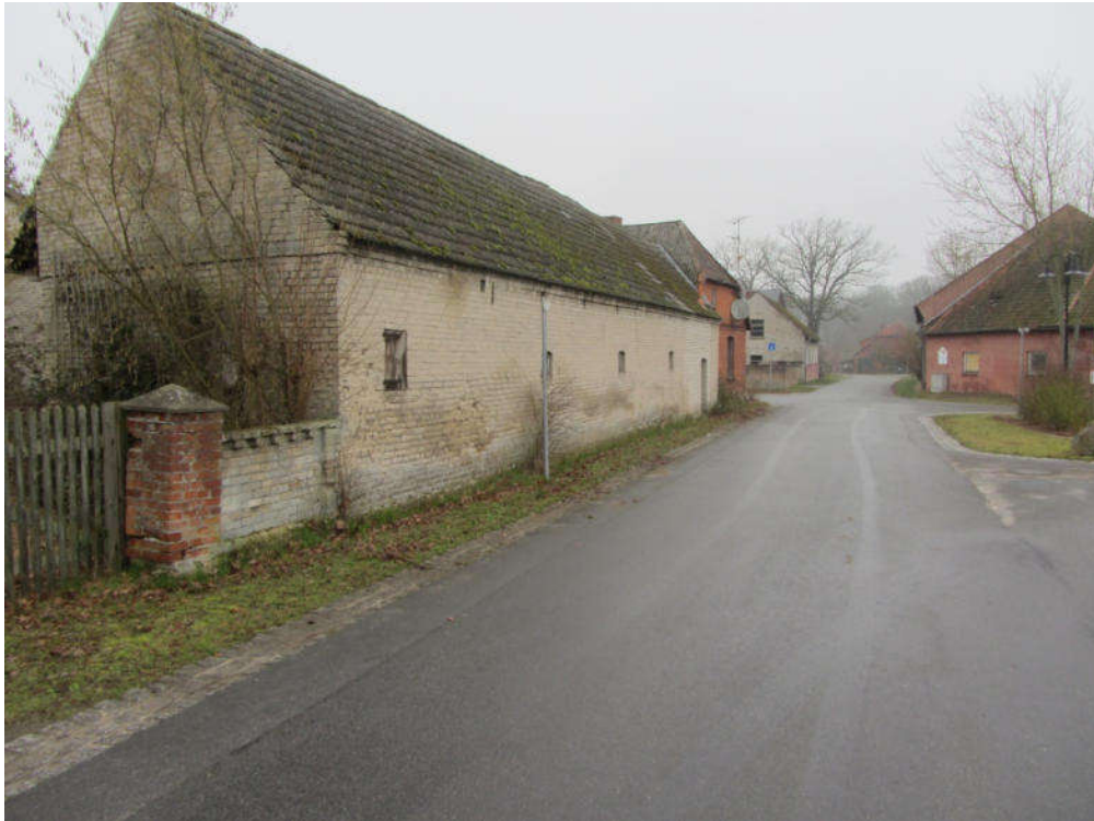
Abbildung 37: Stallgebäude (D) an der „Turmstraße“, Ansicht aus Süden
