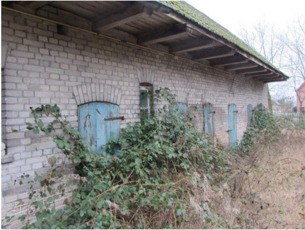
Abbildung 11: Stallgebäude (D), hofseitige Ansicht aus Norden
