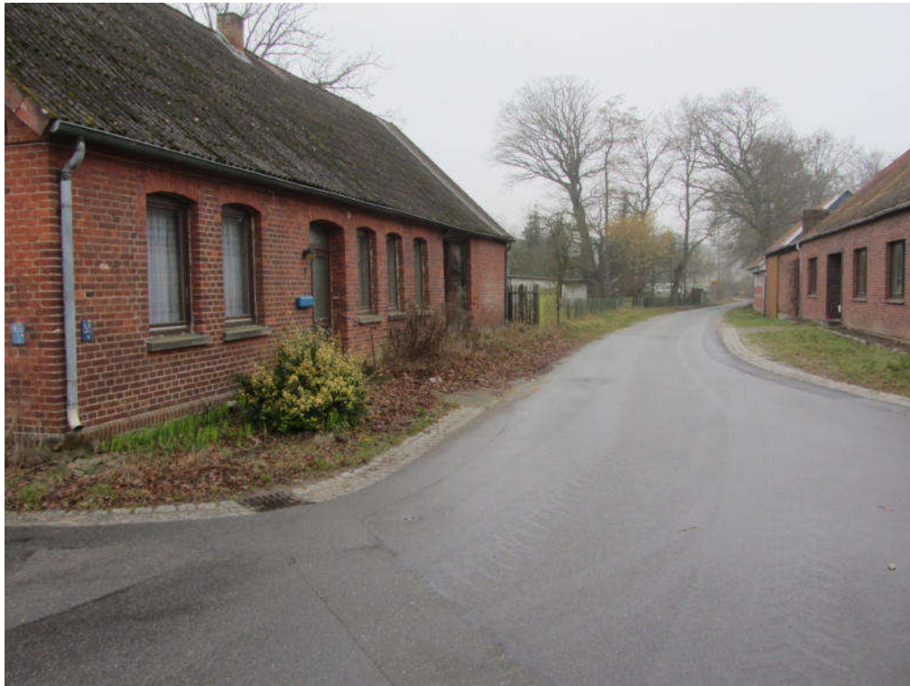
Abbildung 33: Wohnhaus, Ansicht von der „Ringstraße“ aus Nordosten
