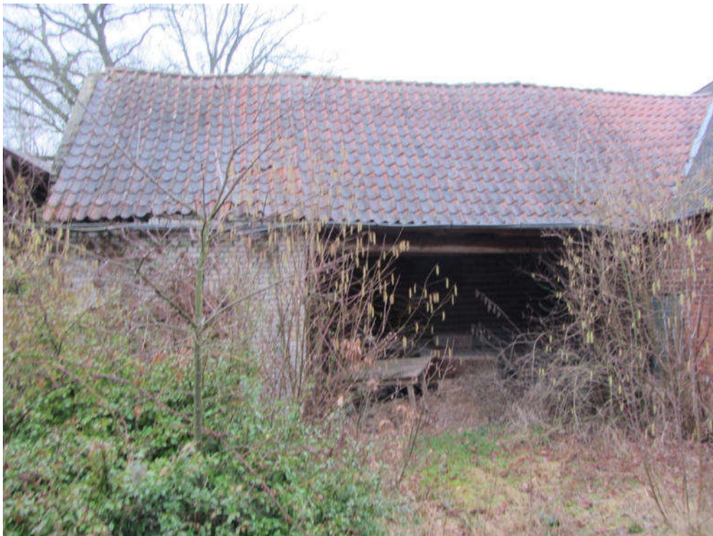
Abbildung 12: Stallanbau (C), hofseitige Ansicht aus Osten
