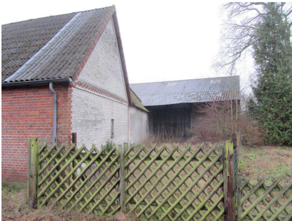
Abbildung 39: Grundstückszufahrt mit Tor und Zaun im Nordwesten
