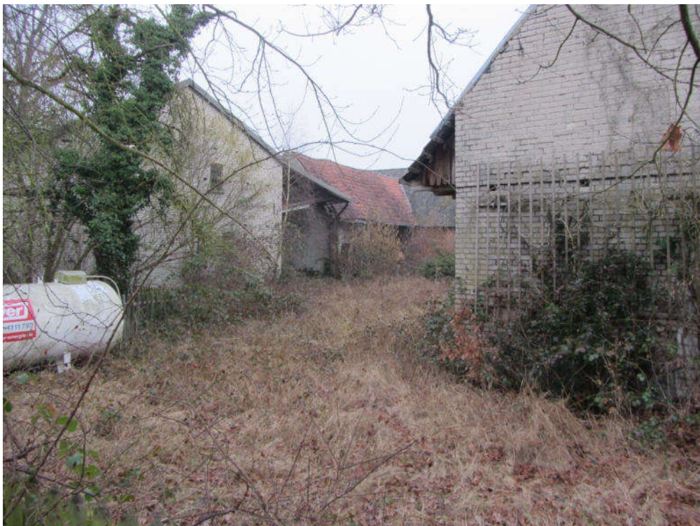
Abbildung 38: hofseitige Ansicht auf das Gebäudeensemble aus Südwesten
