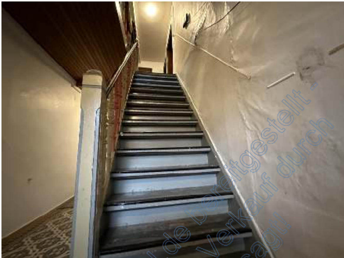
Bild 25: Ausschnitt – Treppe Richtung Flur im Obergeschoss ( Wohnhaus EG Richtung OG).
