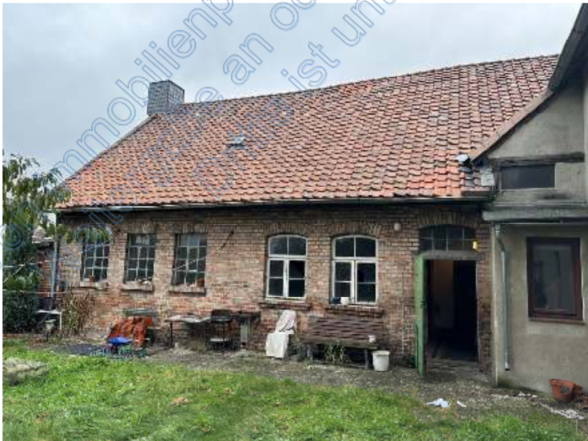
Bild 10: Blick auf die südliche Traufseite des Lagergebäudes.
