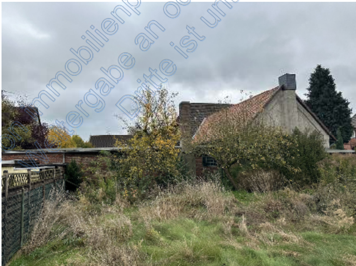
Bild 14: Blick über die nord-westliche Grundstücksfläche in Richtung der teilweise verdeckten Westseite des Werkstattgebäudes. Rechts ist das Lagergebäude (mit Schornstein) zu sehen.
