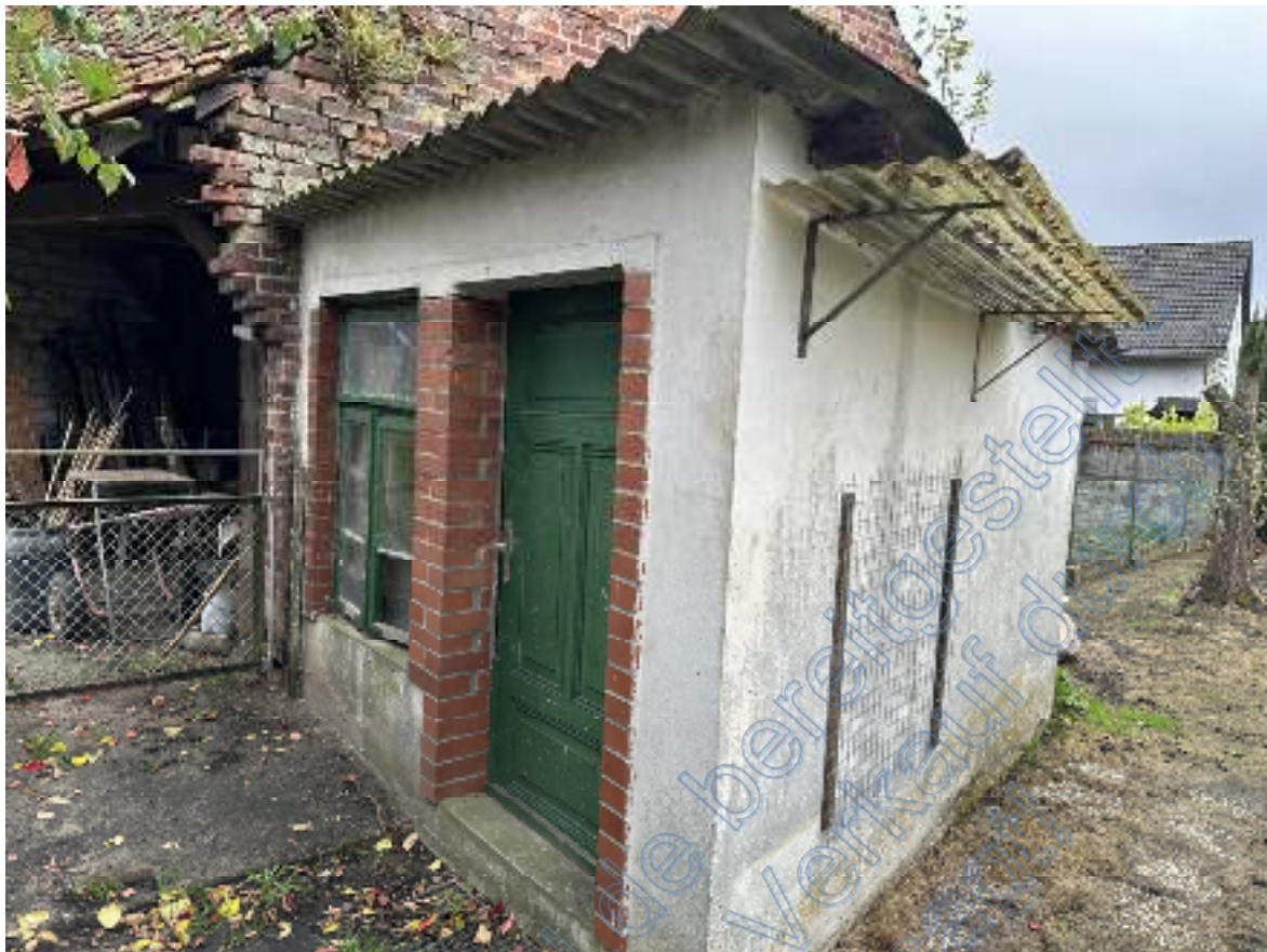
Bild 11: Blick auf das mittig an der südlichen Grundstücksgrenze gelegene Gerätehaus.
