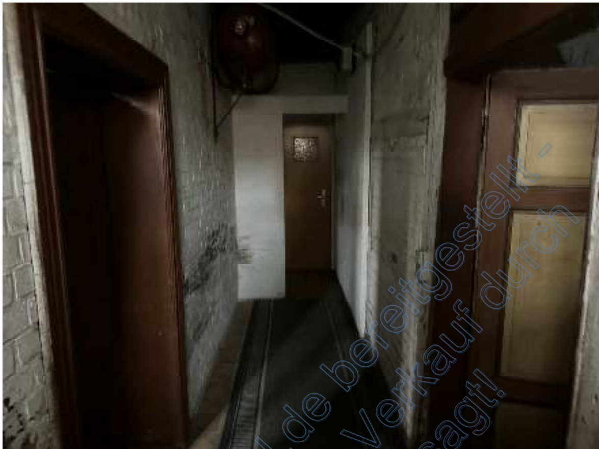
Bild 37: Ausschnitt – Durchgang Richtung geschlossener Tür zum Duschbad ( Wohnhaus EG ). Rechts ist die offene Tür zur „Remise“, links ist die Tür zur Lager- & Gerätehalle im Lagergebäude zu sehen.
