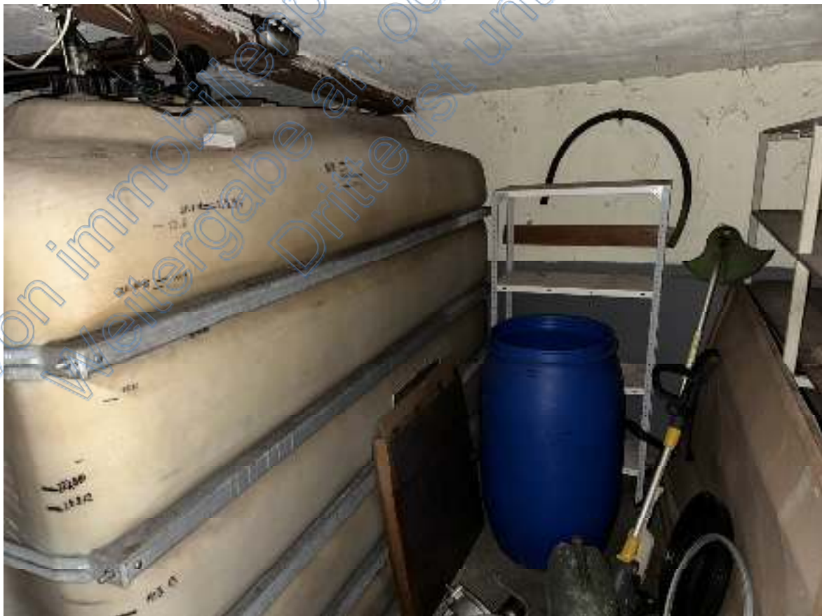
Bild 42: Ausschnitt – Öllager (Lagergebäude EG).
