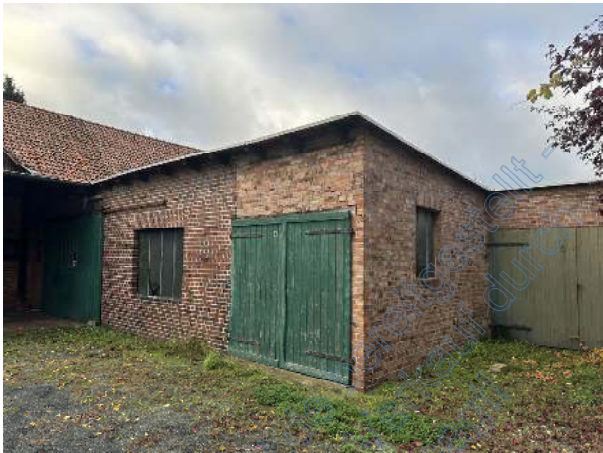
Bild 03: Blick vom Nachbarflurstück 55/4 auf die Ostseite und die sich rechts anschließende kurze Nordseite des Werkstattgebäudes.
