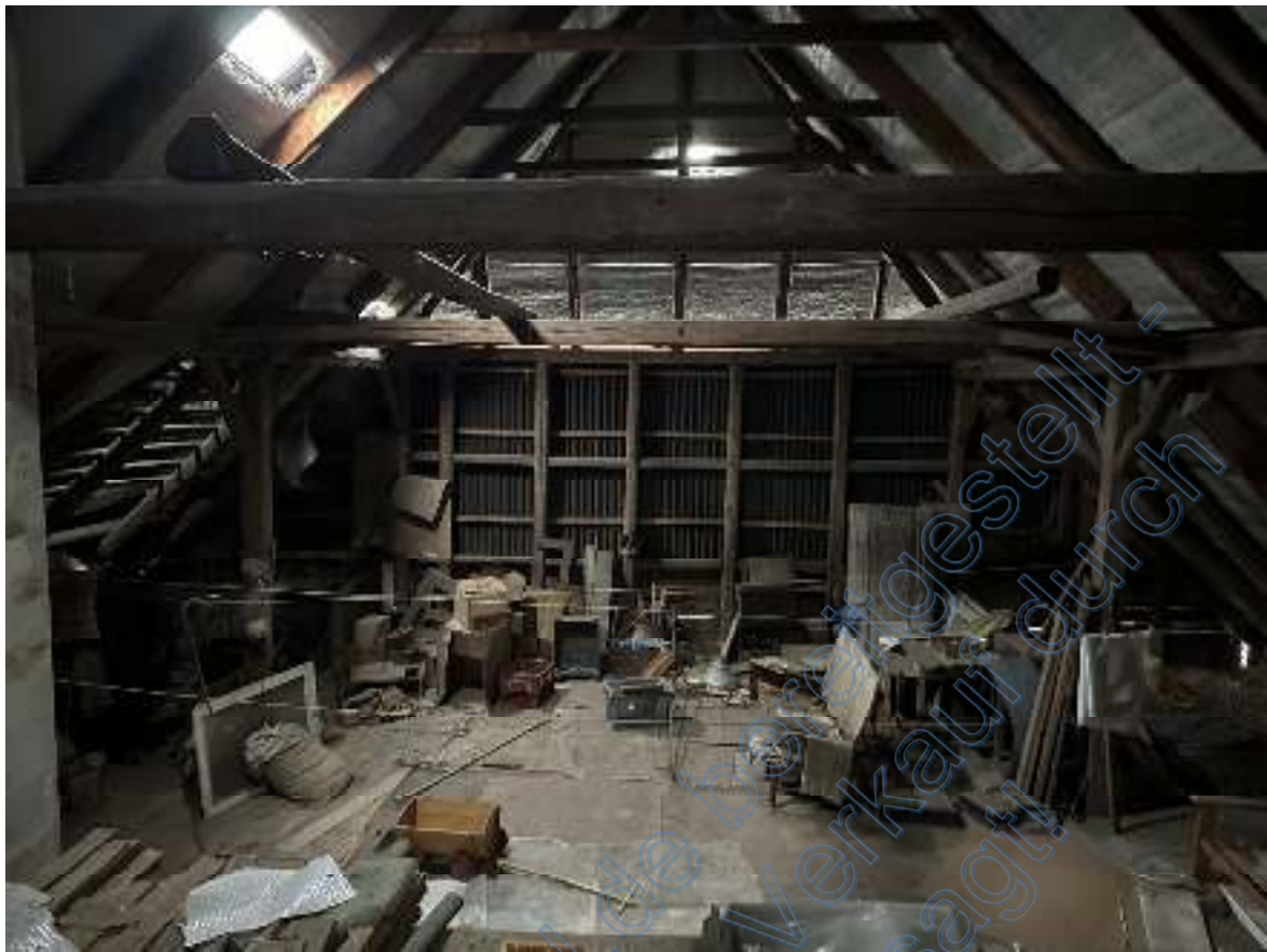
Bild 47: Ausschnitt – nördlicher Dachbodenraum (Wohnhaus DG).
