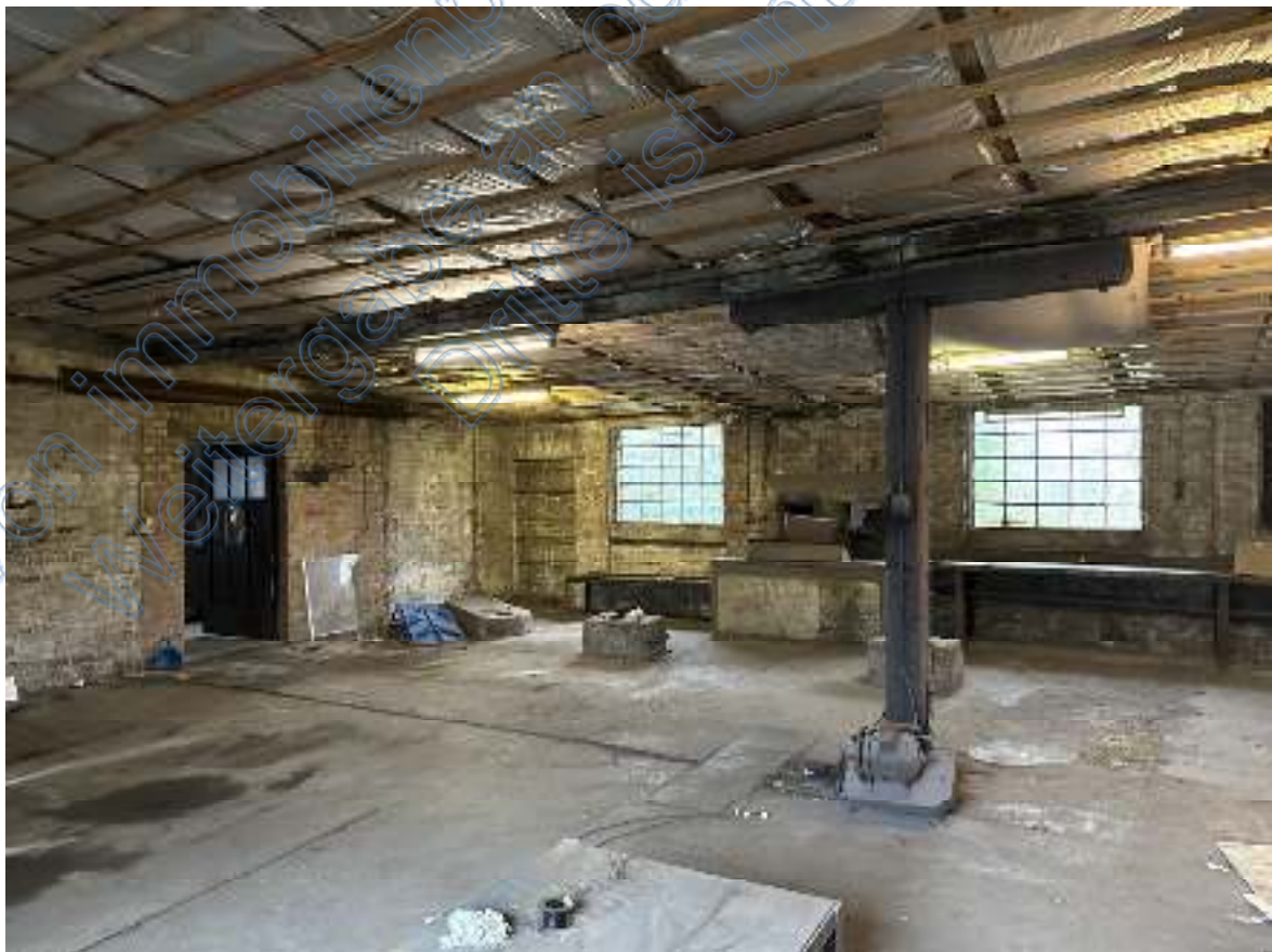
Bild 44: Ausschnitt – Werkstatthalle Richtung offener Tür zur Lager- & Gerätehalle im Lagergebäude (Werkstattgebäude EG).
