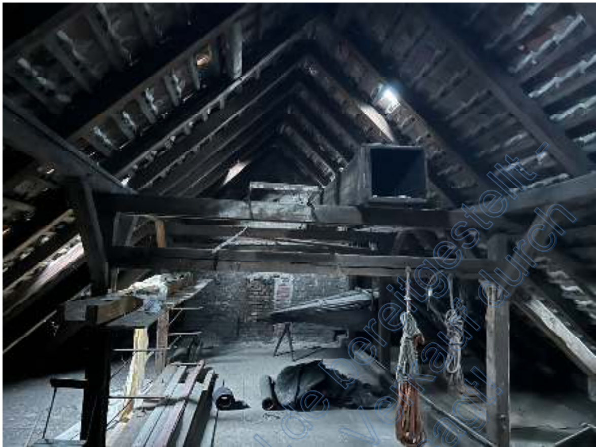
Bild 45: Ausschnitt – Dachbodenraum (Lagergebäude DG).
