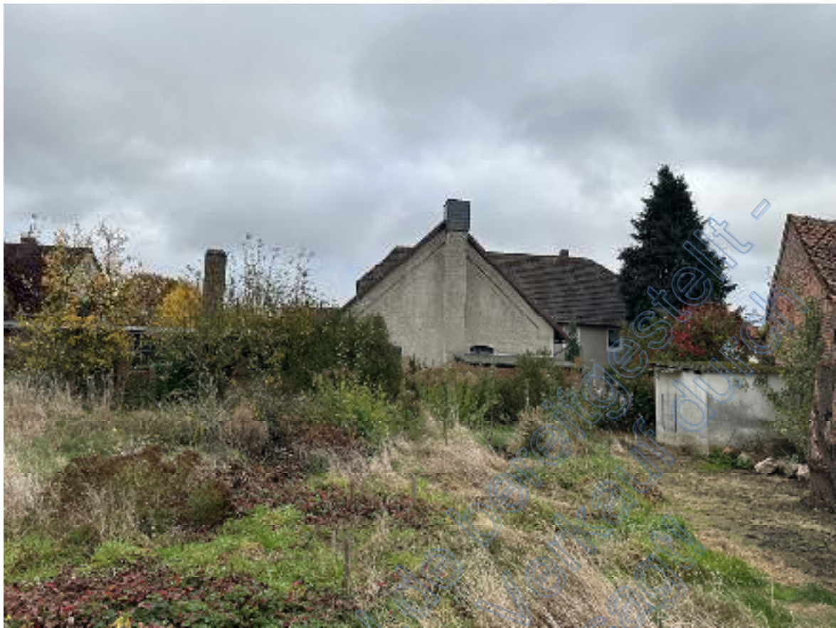
Bild 13: Blick zurück über die süd-westliche Grundstücksfläche in Richtung der westlichen Giebelseite (mit Schornstein) des Lagergebäudes. Ganz rechts ist das Gerätehaus zu sehen.
