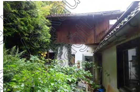
Ansicht von Westen (Seitenflügel)
