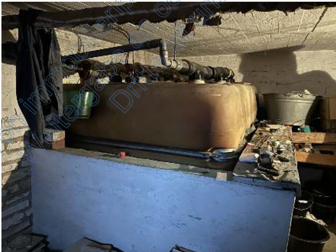
Bild 24: Ausschnitt – Öltanks im Heizungs- & Öllageraum ( Wohnhaus KG ).
