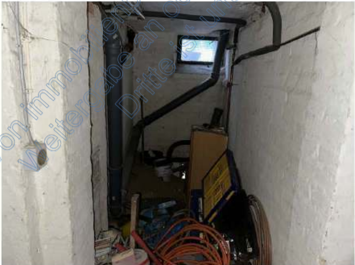
Bild 28: Ausschnitt – Kellerflur Richtung Lagernische (Wohnhaus KG).
