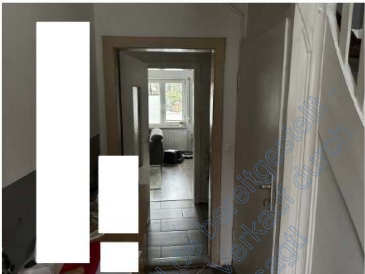
Bild 09: Ausschnitt – Eingangs- & Treppenflur Richtung offener Tür zum Flur (Wohnhaus EG).
