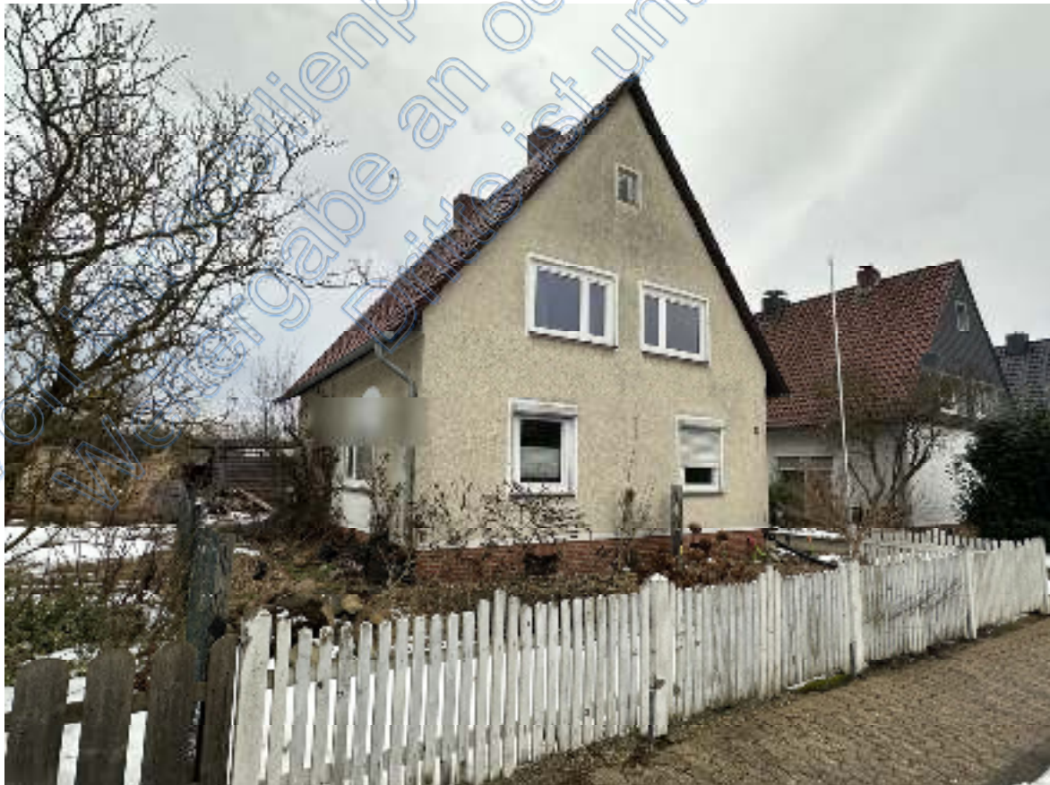
Bild 02: Blick über die Südostecke des Bewertungsflurstücks 81/35 ( links unten ) auf die östliche Giebelseite und die sich links anschließende südliche Traufseite des Wohnhauses des Bewertungsobjektes.
