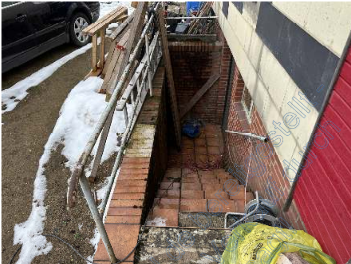
Bild 31: Blick entlang der Kellertreppe in Richtung geschlossener Fenstertür zum Kellerraum 4.
