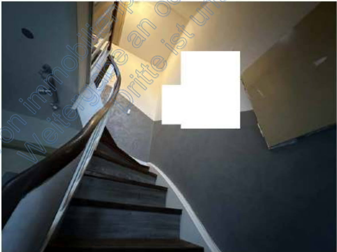
Bild 16: Ausschnitt – Treppe Richtung Flur im Dachgeschoss (Wohnhaus EG Richtung DG).
