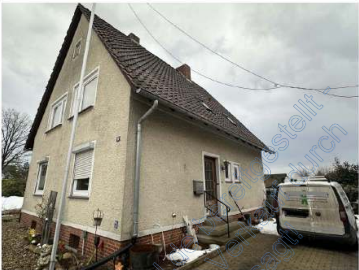
Bild 07: Blick auf die Eingangssituation mit Eingangsstufen und geschlossener Hauseingangstür zum Treppen- & Eingangsfloor in der nördlichen Traufseite des Wohnhauses.
