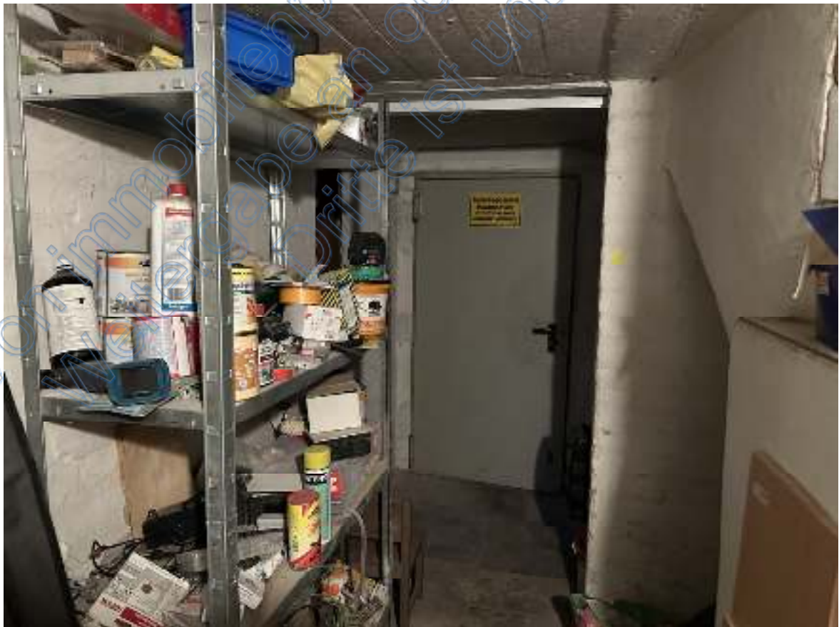
Bild 22: Ausschnitt – Kellerflur Richtung geschlossener Tür zum Kellerraum 2 / Heizungs- & Öllageraum (Wohnhaus KG).
