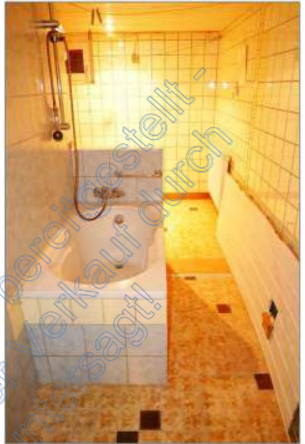
Foto 13 - Wohnhaus - Sanitärraum KG
