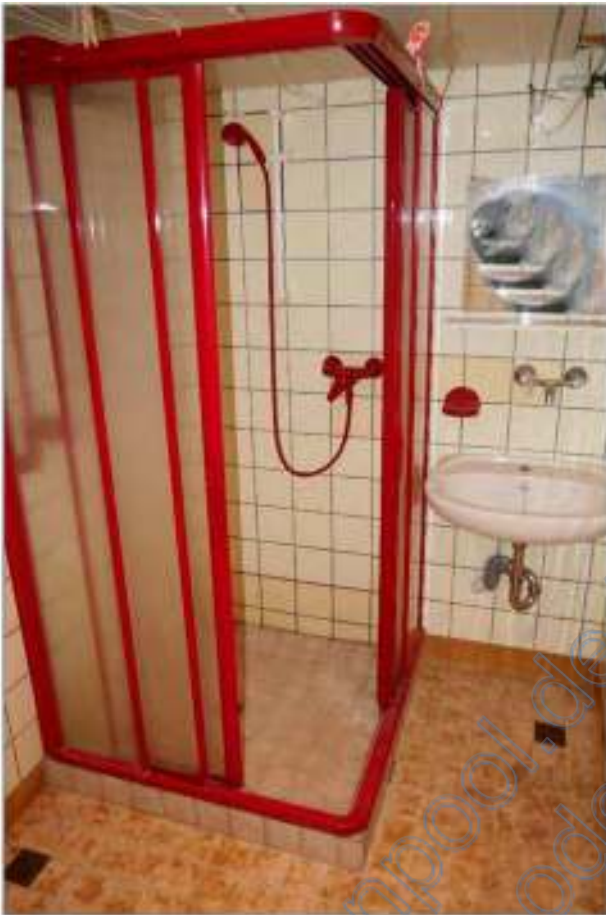
Foto 12 - Wohnhaus - Dusche KG
