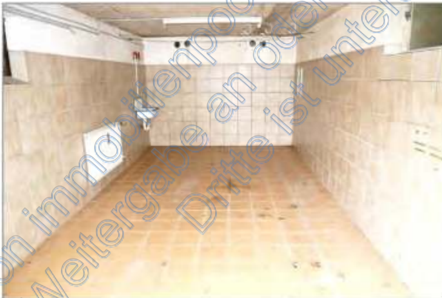
Foto 26 - Garagenanbau am Wohnhaus - Innenansicht
