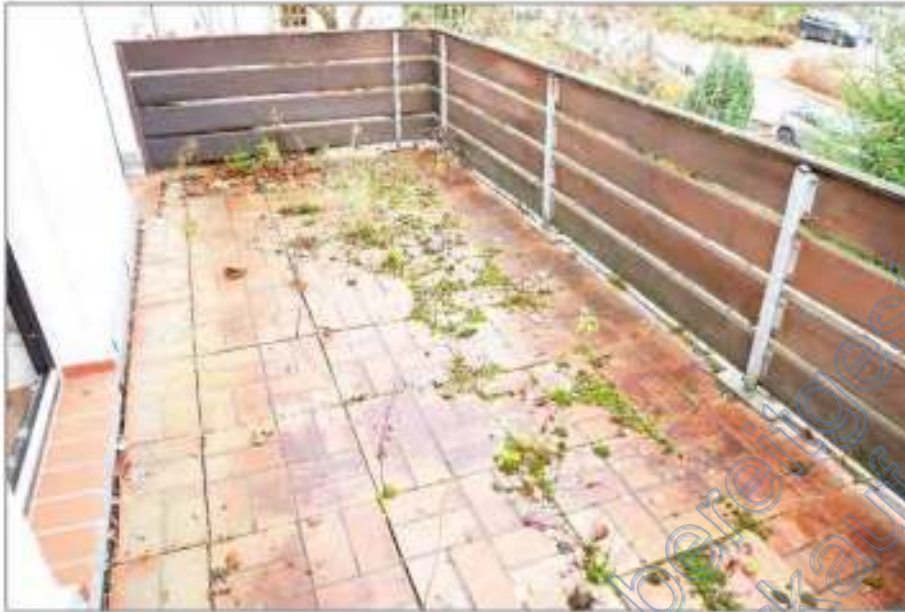
Foto 23 - Wohnhaus - Balkon OG
