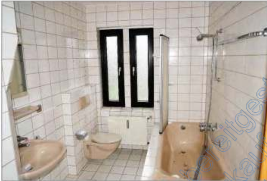
Foto 21 - Wohnhaus - Bad OG
