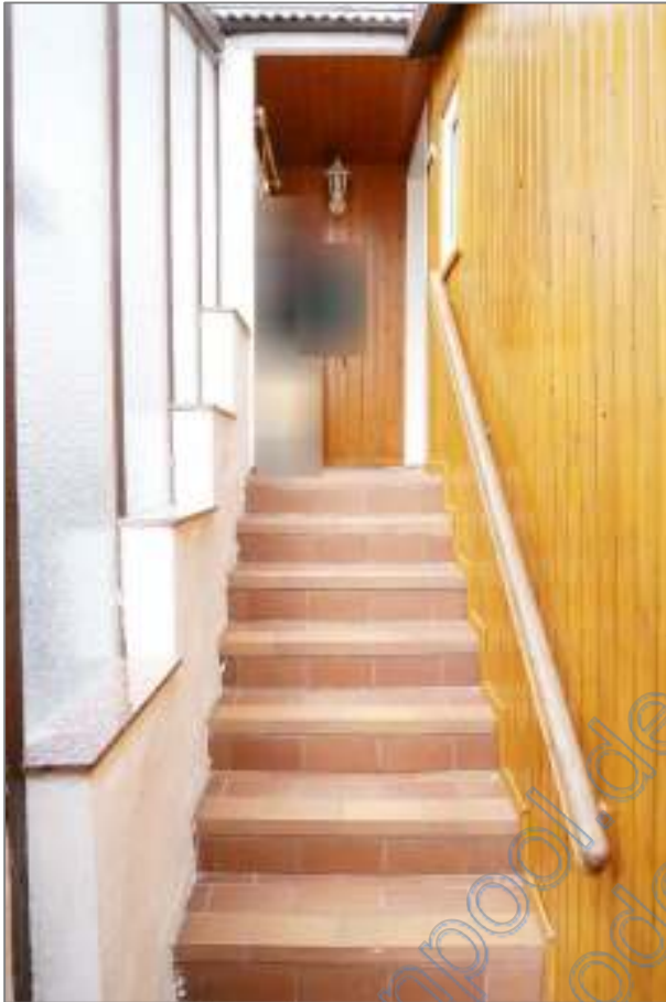
Foto 7 - Wohnhaus - Eingangsvorbau EG
