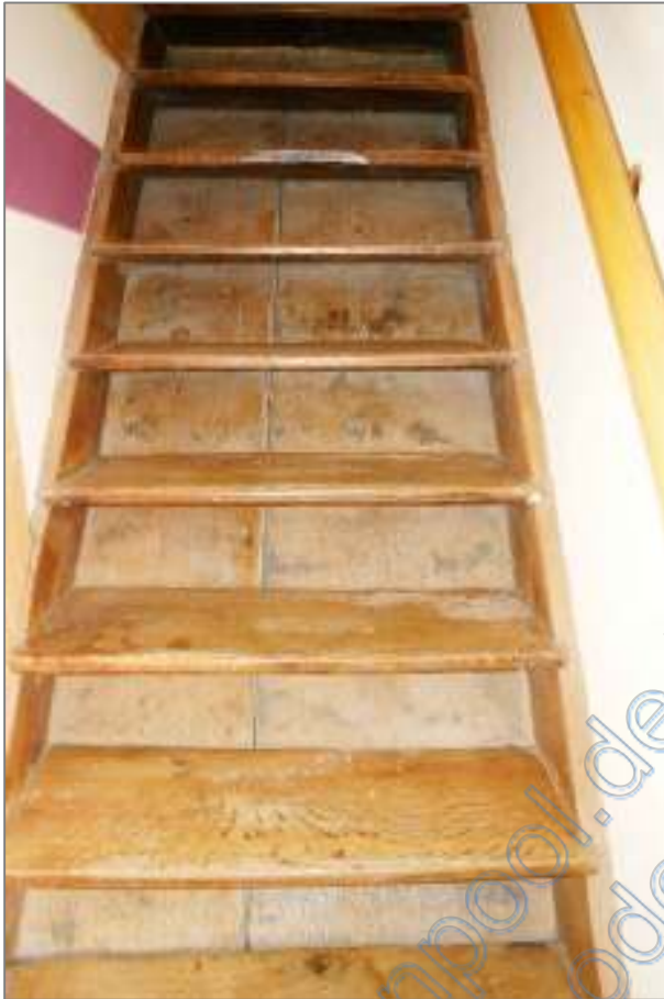
Foto 14 - Wohnhaus - einfache Treppe zum DG
