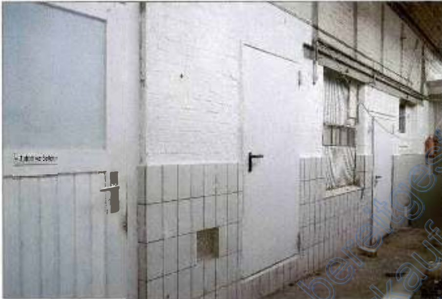
Foto 32 - Hinterhaus - Nordostansicht (Hofansicht)
