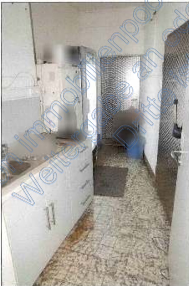
Foto 8 - Wohn-/Geschäftshaus - Teeküche / Lagerraum EG
