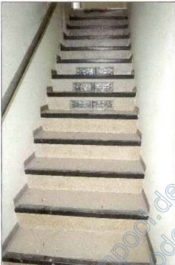
Foto 18 - Wohn-/Geschäftshaus - Anbau - Treppe zum OG
