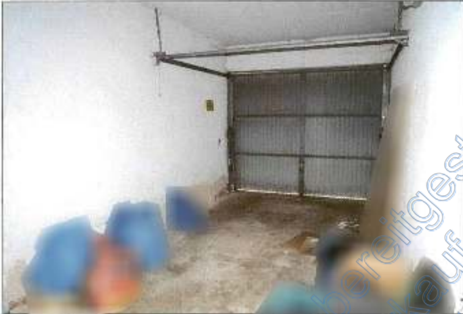
Foto 40 - Garagengebäude - Garage EG
