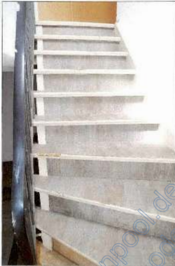
Foto 26 - Wohn-/Geschäftshaus - Treppe zum DG
