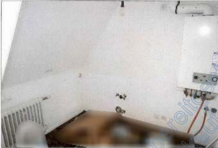
Foto 30 - Wohn-/Geschäftshaus - Wohnung DG - Küche
