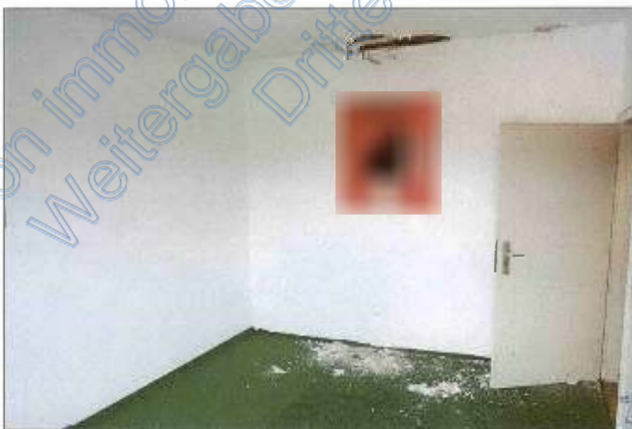
Foto 19 - Wohn-/Geschäftshaus - Anbau - Nebenraum OG
