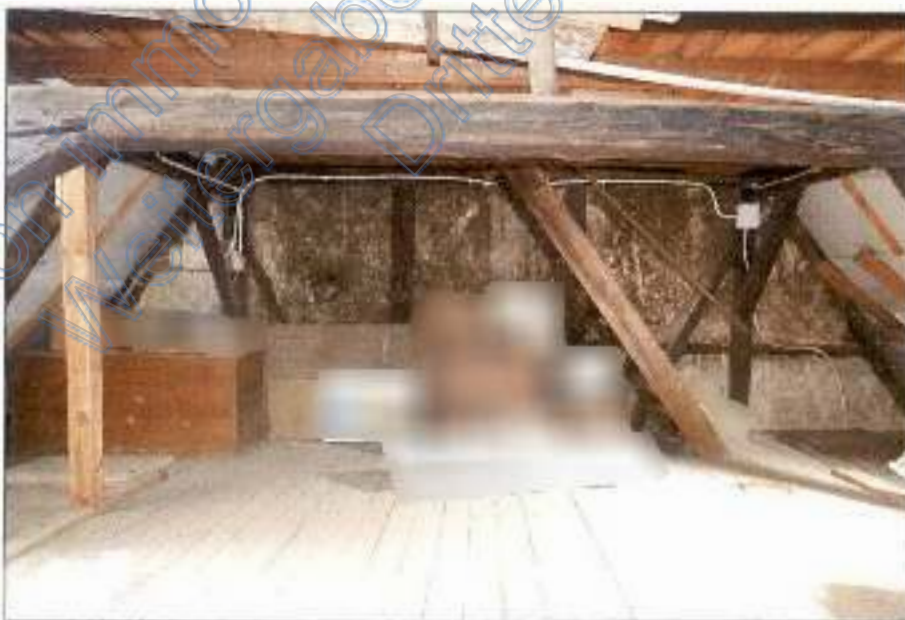
Foto 27 - Wohn-/Geschäftshaus - nicht ausgebauter Dachboden (östlicher Teil)
