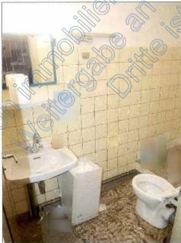
Foto 17 - Wohn-/Geschäftshaus - Toilette EG
