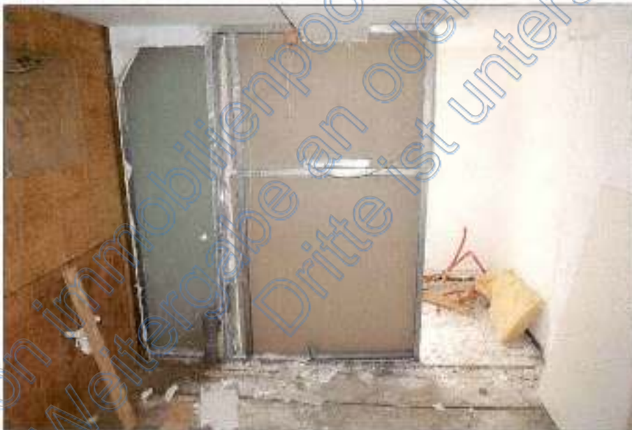
Foto 21 - Wohn-/Geschäftshaus - Wohnung OG links - Bad (Rohbauzustand)
