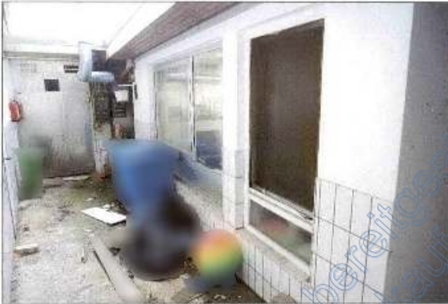
Foto 3 - Wohn-/Geschäftshaus - rückseitiger Anbau EG - Südostansicht
