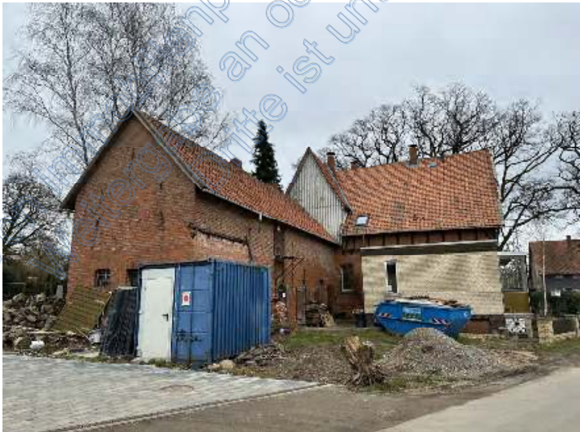
Bild 06: Blick über die Südostecke des Nachbarflurstücks 73/33 (unten links) auf die westliche Giebel- und die südliche Traufseite des Lagergebäudes. Rechts ist der Flachdachanbau (an der westlichen Seite) zu sehen.
