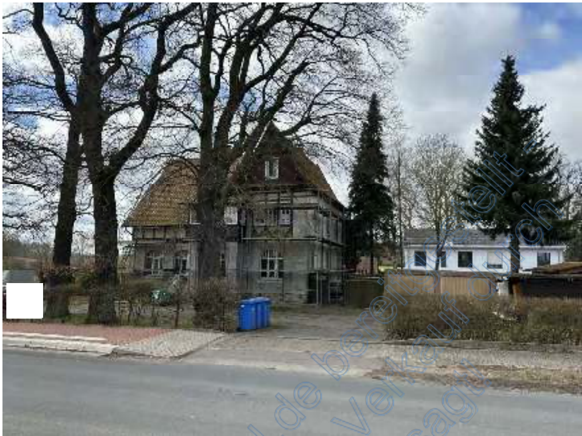
Bild 03: Blick über die Calberlaher Straße durch die östliche Grundstückszufahrt des Bewertungsflurstücks 73/34 auf das z.Zt. als Bürogebäude genutzte Wohnhaus sowie die Doppelgarage des Bewertungsobjektes.
