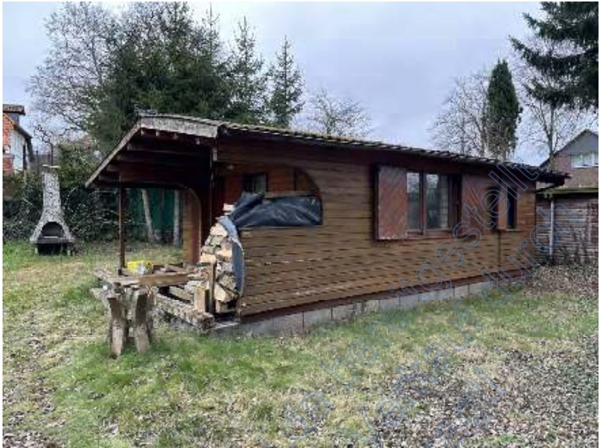
Bild 41: Blick auf das Gartenhaus.
