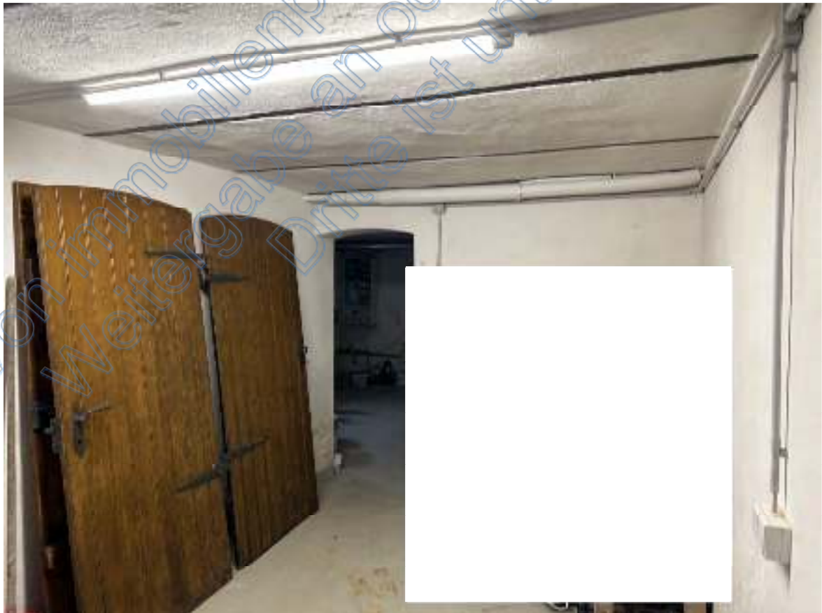
Bild 24: Ausschnitt – Kellerraum 1 Richtung Durchgang zum Kellerraum 3 (Wohnhaus KG).
