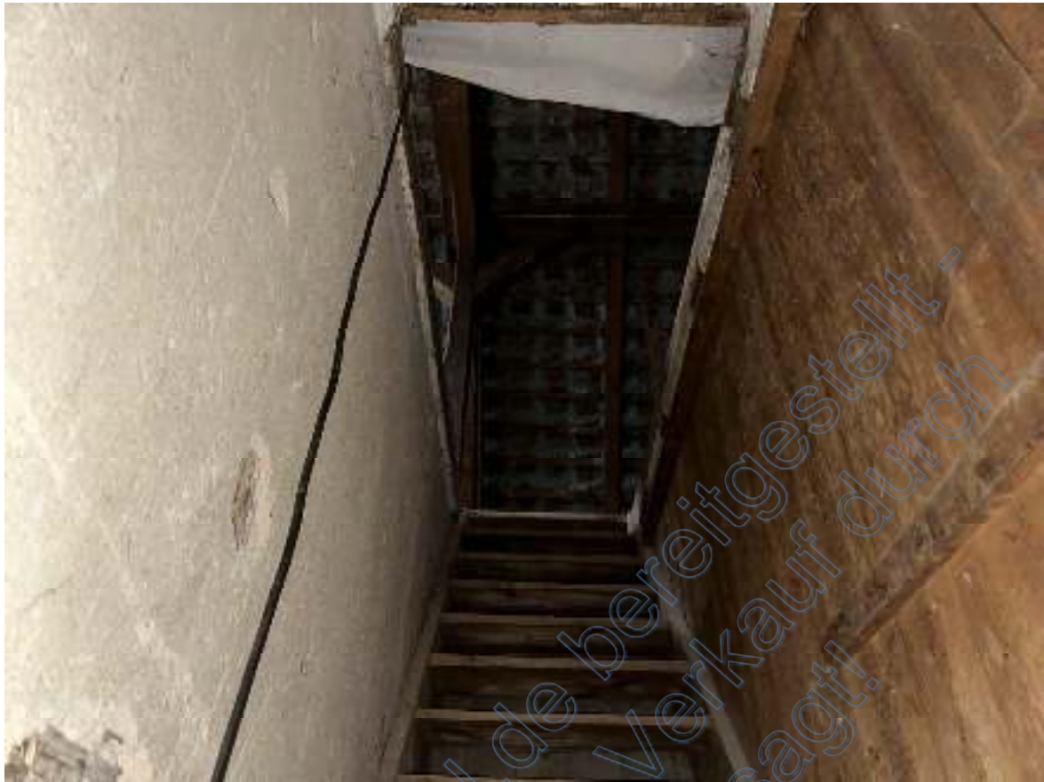
Bild 39: Ausschnitt – Treppenstiege Richtung Dachgeschoss (Wohnhaus OG Richtung DG).
