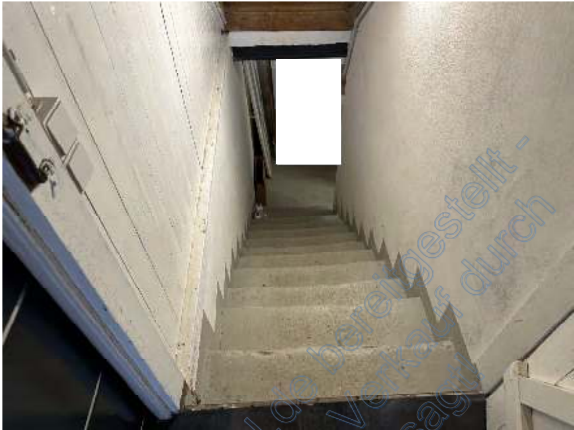
Bild 23: Ausschnitt – Treppe Richtung Kellerraum 1 (Wohnhaus EG Richtung KG).
