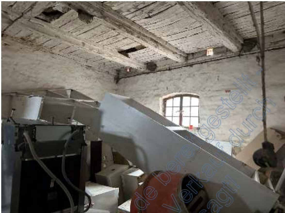
Bild 21: Ausschnitt – Stallung I (Lagergebäude EG).
