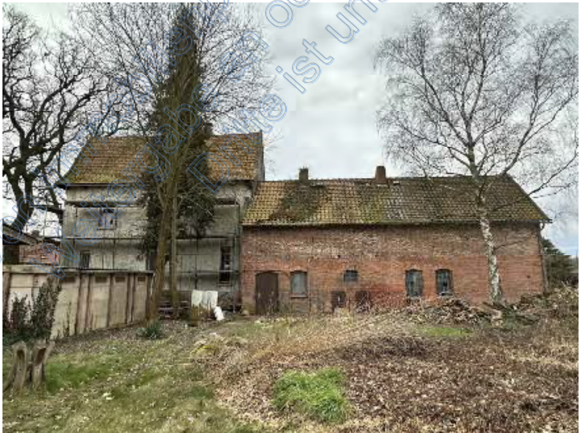
Bild 08: Blick über die nordwestliche Grundstücksfläche auf die nördliche Traufseite des Lagergebäudes und die sich links anschließende nördliche Traufseite des z.Zt. als Bürogebäude genutzten Wohnhauses .
