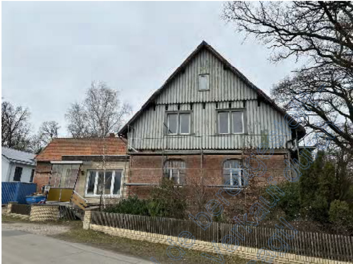
Bild 05: Blick von der Straße „An der Badeanstalt“ auf die südliche Giebelseite des z.Zt. als Bürogebäude genutzten Wohnhauses . Links (mit Eingangstreppe und -vorbau) ist der Flachdachanbau zu sehen.
