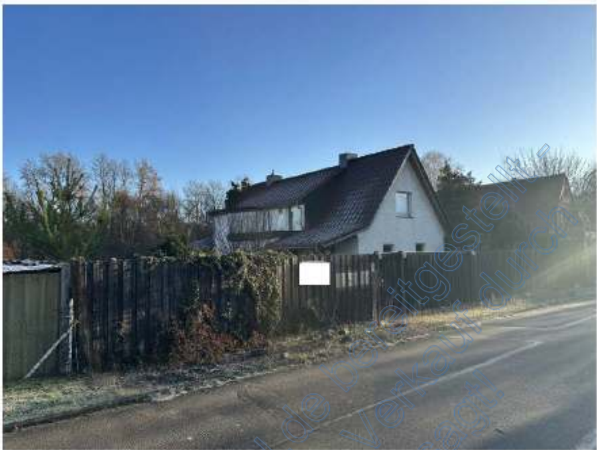
Bild 03: Blick vom Drosselstieg auf und über die Nordwestecke (ganz links) der straßenseitigen, westlichen Grundstückseinfriedung auf die nördliche Dachfläche und einen Teil der westlichen Giebelseite des Wohnhauses.
