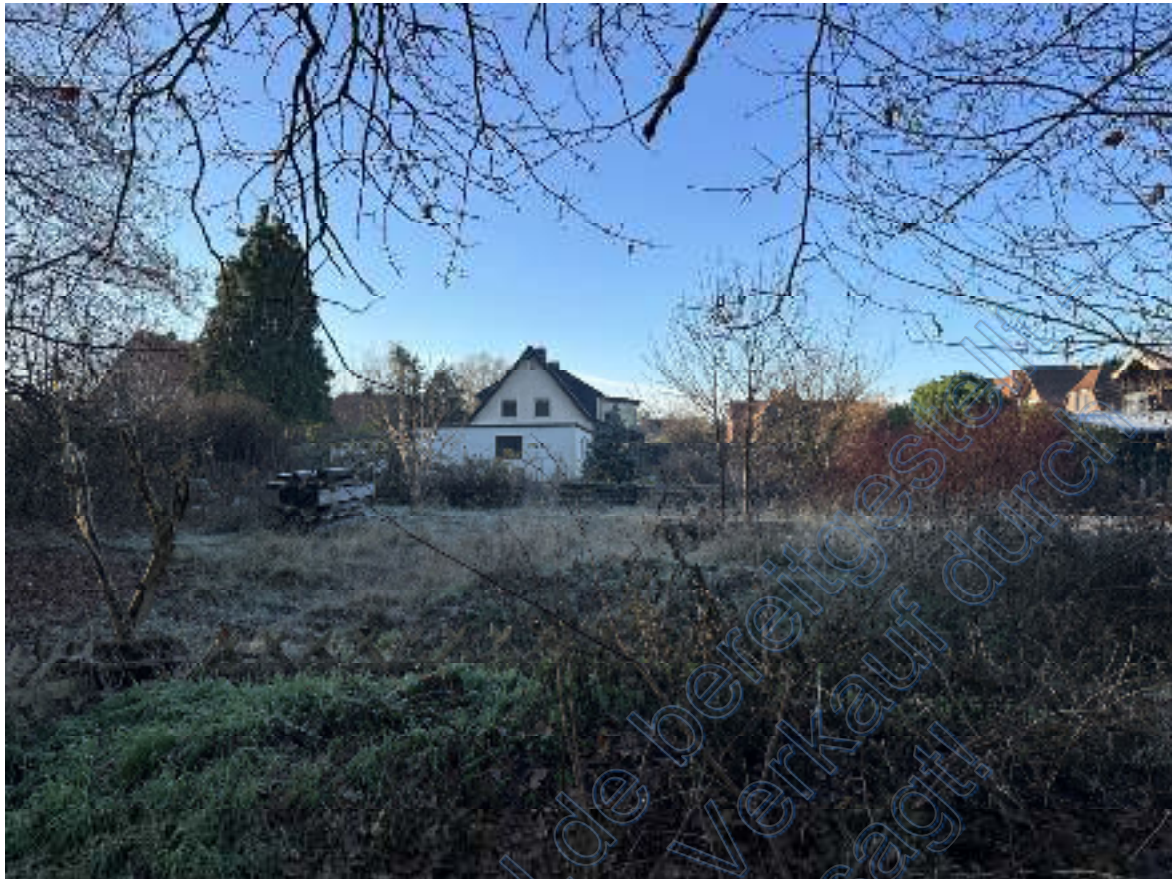
Bild 07: Blick vom östlich verlaufenden Waldweg über die östliche, unbebaute Grundstücksfläche auf die Ostseite des östlichen Flachdachanbaus. Dahinter ist der obere Teil der östlichen Giebelseite des Wohnhauses zu sehen.
