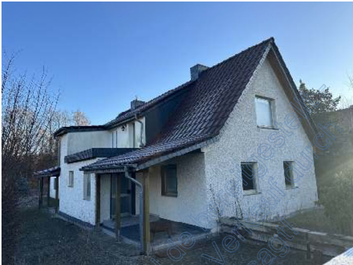
Bild 05: Blick über die straßenseitige, westliche Grundstückseinfriedung auf die westliche Giebelseite und die sich links anschließende nördliche Traufseite des Wohnhauses .
