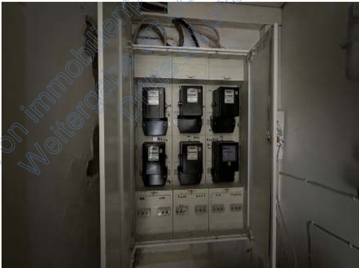
Bild 24: Ausschnitt – Stromzählerkasten im Heizungs- & Technikraum ( Mehrfamilienhaus mit vier Wohneinheiten EG).
