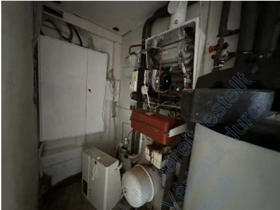
Bild 23: Ausschnitt – Therme im Heizungs- & Technikraum ( Mehrfamilienhaus mit vier Wohneinheiten EG).
