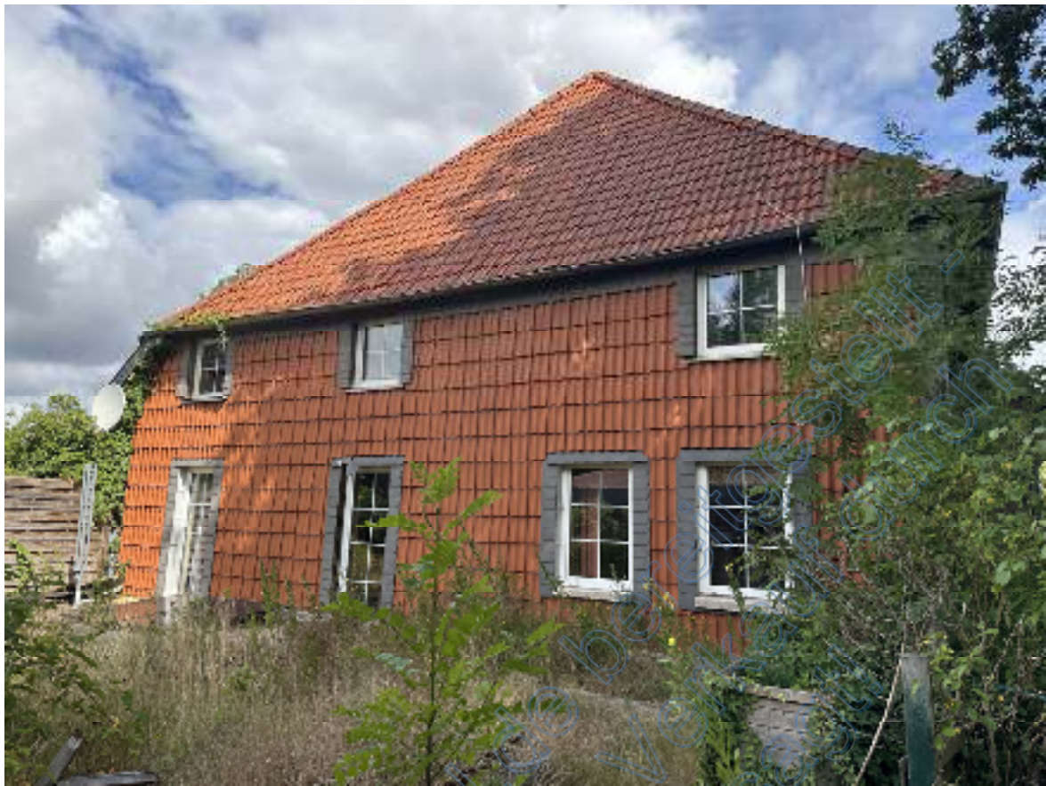
Bild 13: Blick auf die Südseite des Wohnhauses I mit drei Wohneinheiten .
