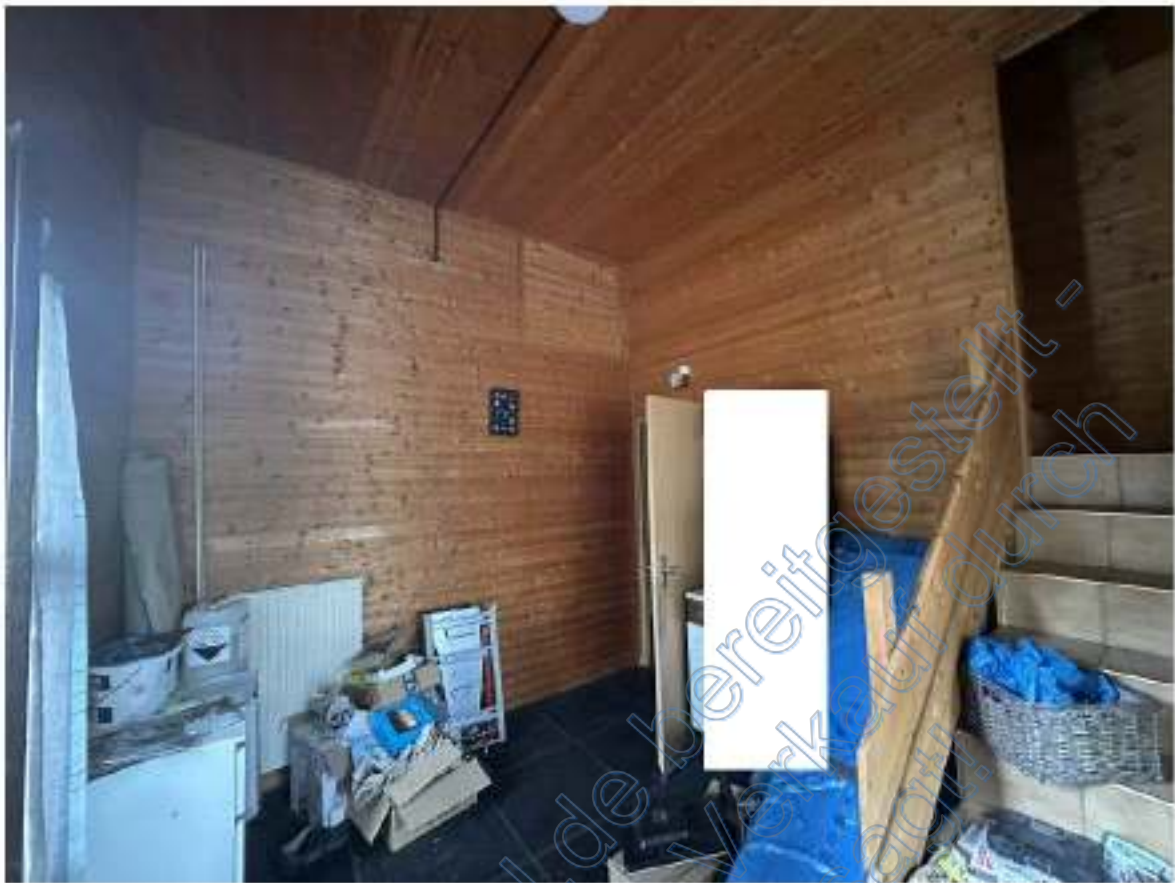
Bild 53: Ausschnitt – Eingangsseite Richtung offener Wohnungseingangstür zum Flur der Wohnung 4 (Wohnhaus II mit zwei Wohneinheiten EG).
