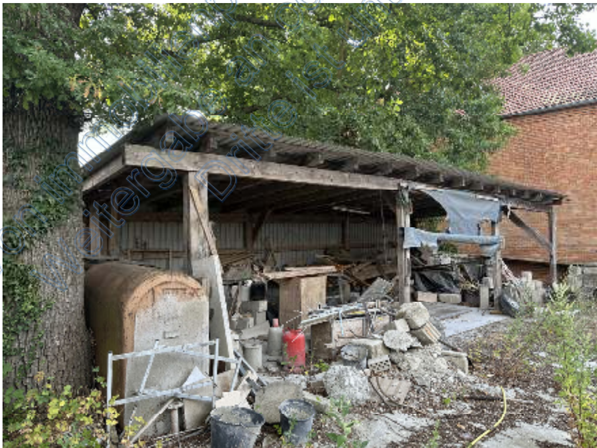
Bild 08: Blick auf und in die „große“ Lagerüberdachung.
