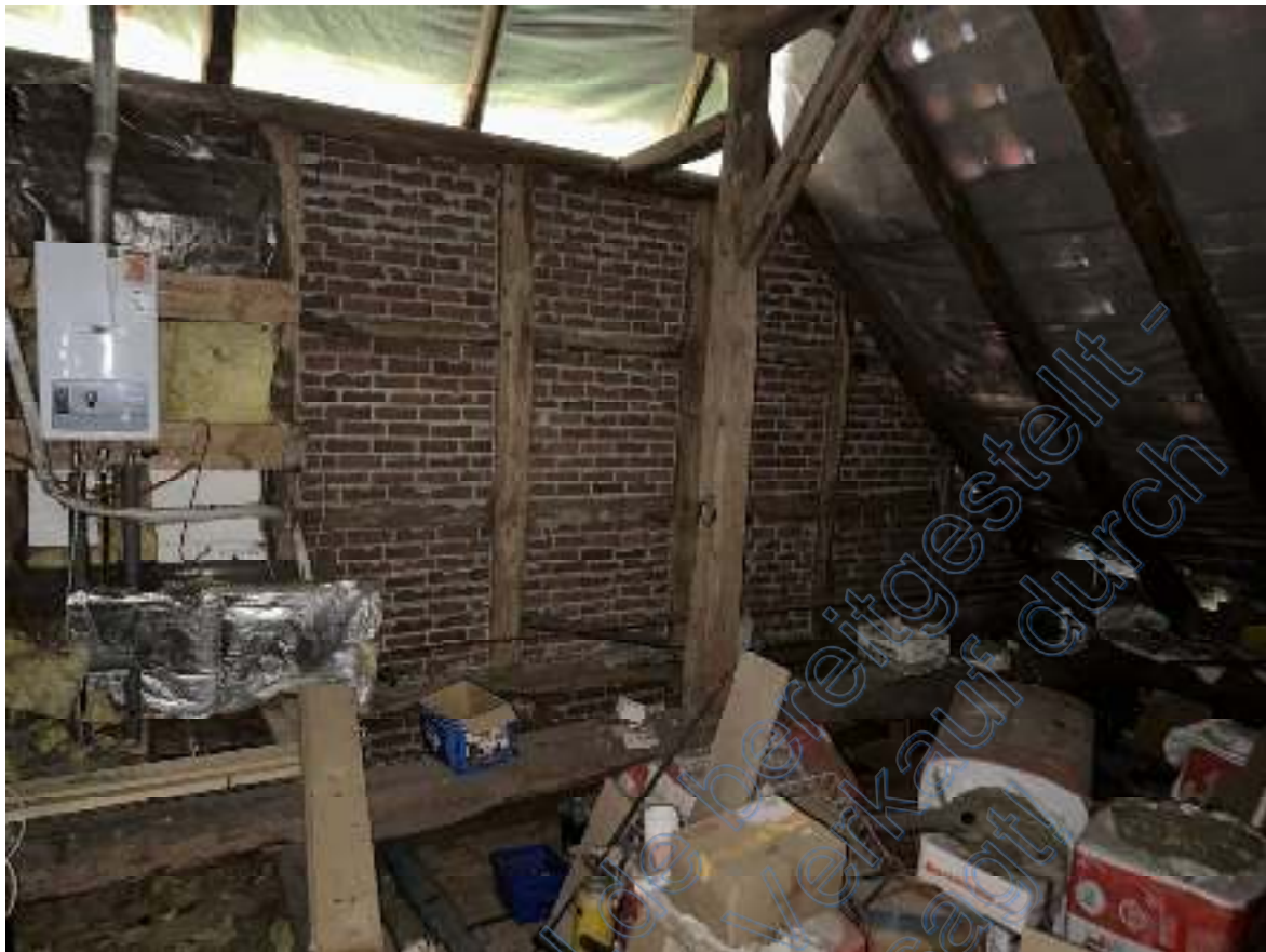
Bild 47: Ausschnitt – nordöstlicher Dachbodenbereich mit Therme (Wohnhaus I mit drei Wohneinheiten DG).
