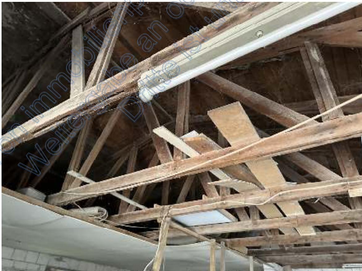
Bild 12: Ausschnitt – Dachkonstruktion über Innenraum (Lager- & Gerätehalle).
