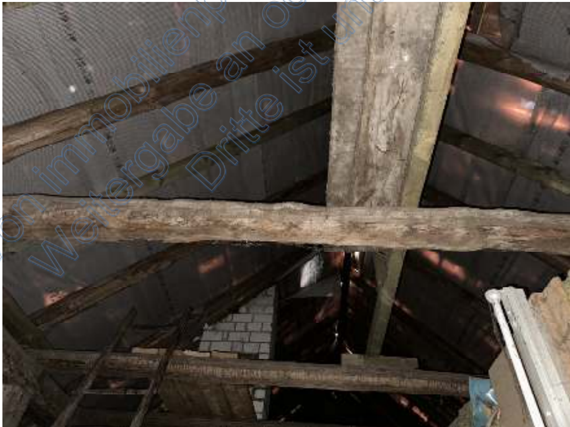
Bild 50: Ausschnitt – „oberer“ südöstlicher Dachbodenbereich (Wohnhaus I mit drei Wohneinheiten DG).
