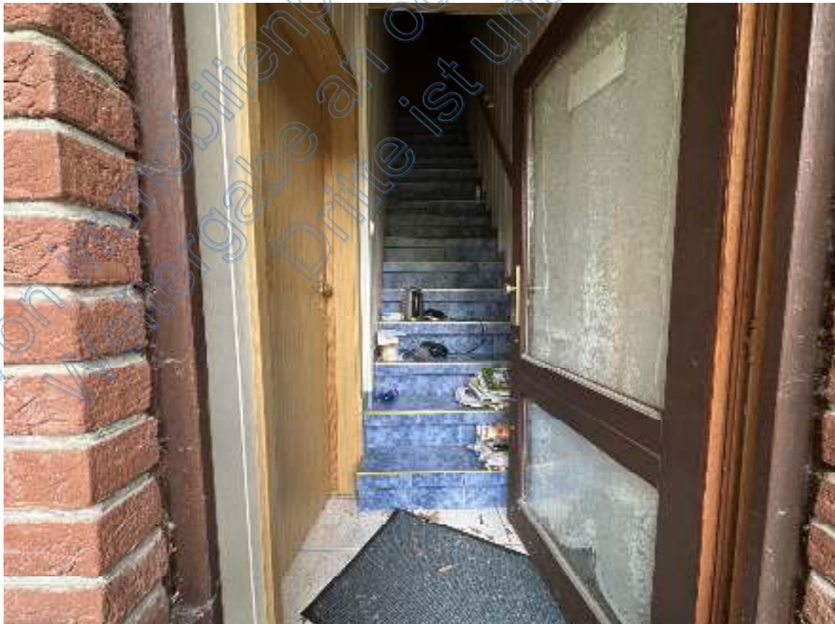
Bild 30: Ausschnitt – Eingangs- & Treppenflur mit Treppe zur Wohnung Nr. 3 im Dachgeschoss ( Wohnhaus I mit drei Wohneinheiten EG).
