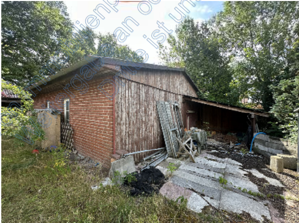
Bild 10: Blick auf die Nordseite und die sich rechts anschließende Westseite der Lager- & Gerätehalle.
