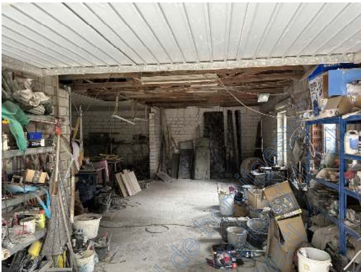
Bild 11: Ausschnitt – Innenraum (Lager- & Gerätehalle).
