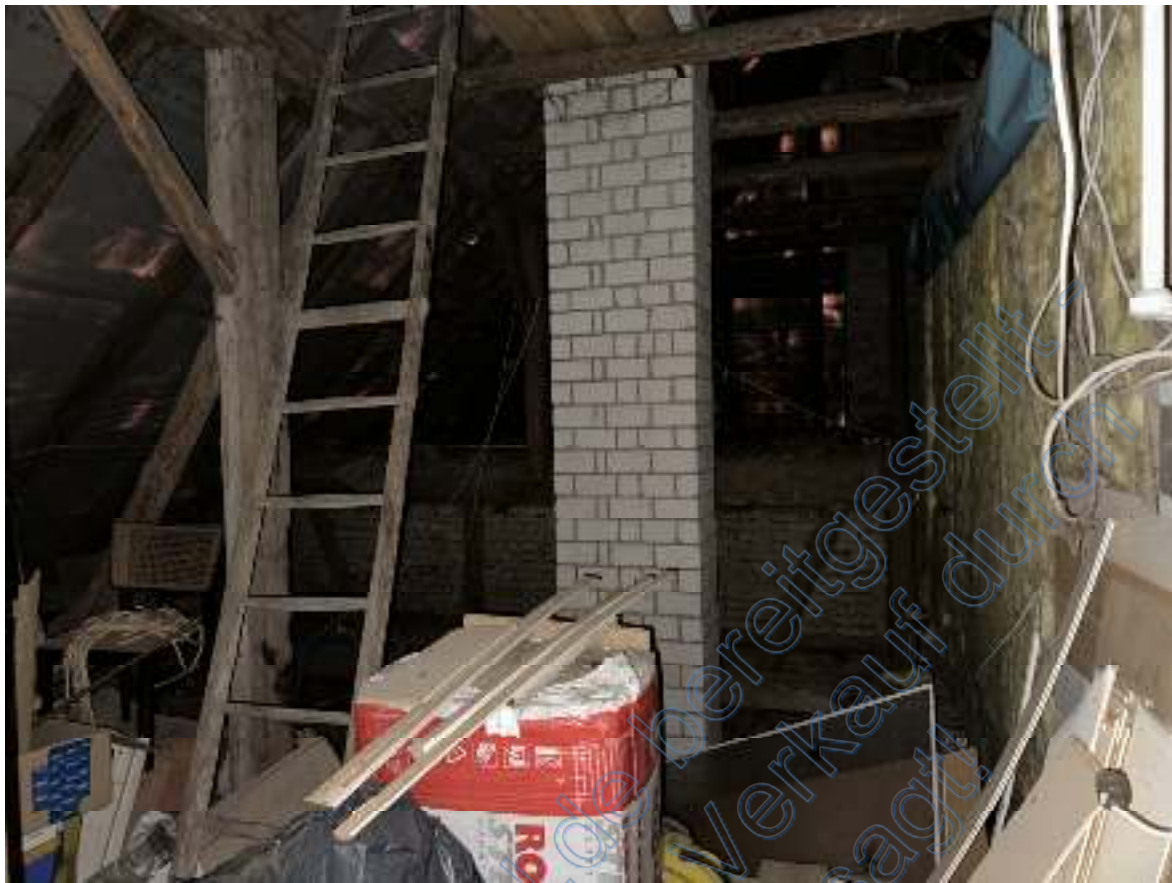
Bild 49: Ausschnitt – südöstlicher Dachbodenbereich (Wohnhaus I mit drei Wohneinheiten DG).
