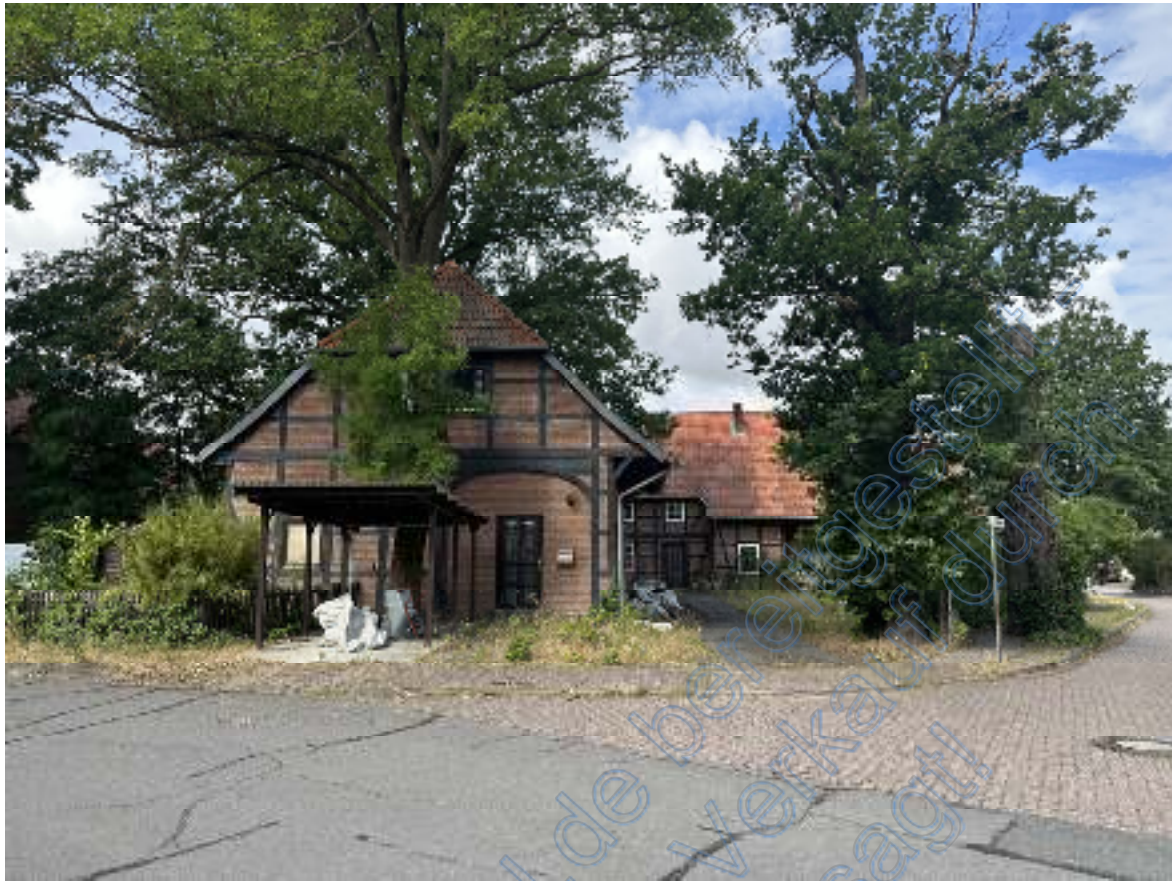
Bild 03: Blick über die Wasbütteler Straße und die Einmündung der Straße „Im Winkel“ (von rechts) auf die Ostseite (Eingangsseite) des Wohnhauses II mit zwei Wohneinheiten (Wasbütteler Str. 4A) sowie durch die Grundstückszufahrt auf die Ostseite des Wohnhauses I mit drei Wohneinheiten .
