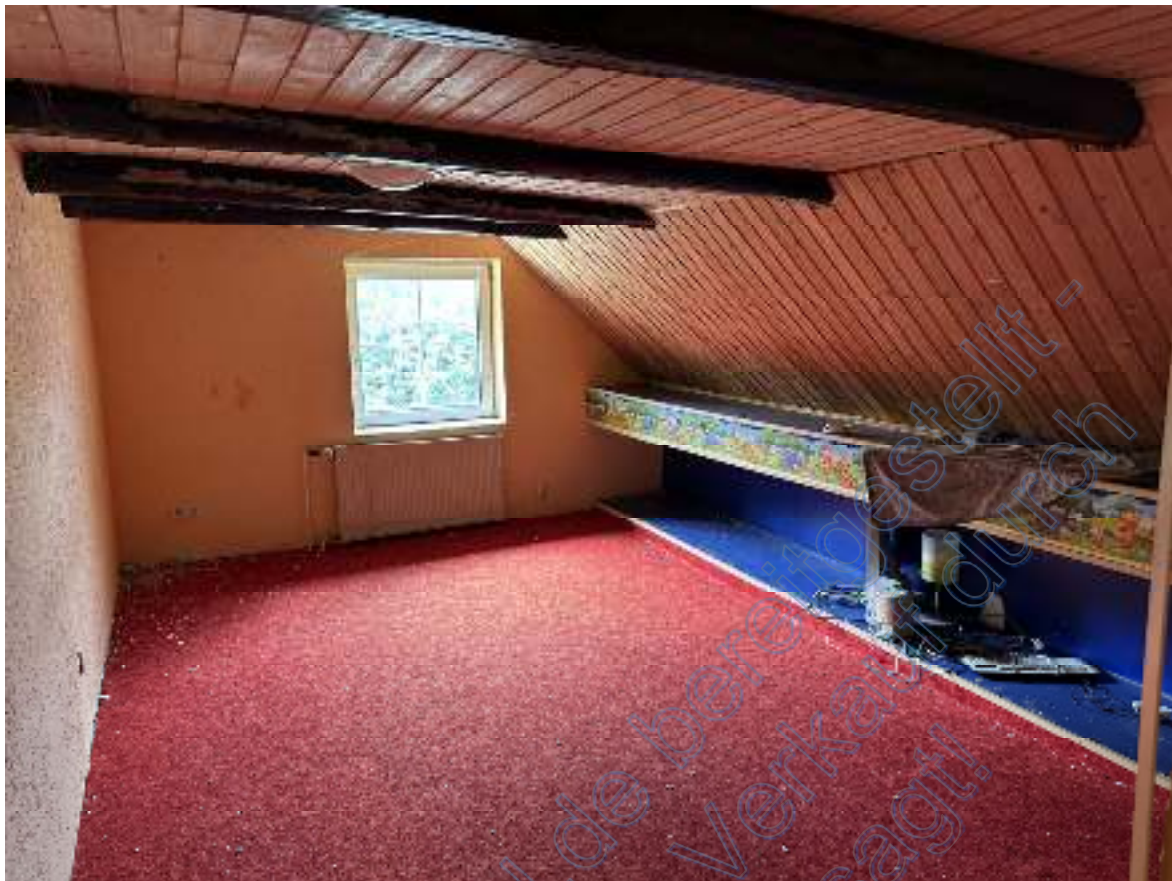
Bild 25: Ausschnitt – Zimmer 2 (Wohnhaus I mit drei Wohneinheiten Wohnung 1 DG).
