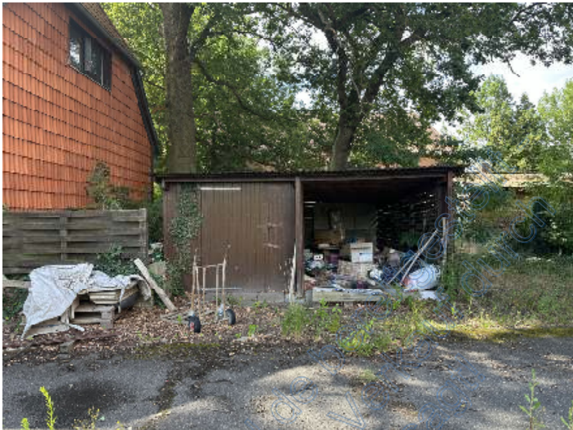
Bild 07: Blick auf und in die „kleine“ Lagerüberdachung. Links ist die Westseite des Wohnhauses II mit zwei Wohneinheiten zu sehen.
