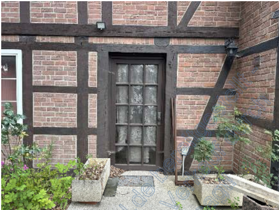
Bild 15: Blick auf die geschlossene Eingangstür zur Wohnung 1 im Wohnhaus I mit drei Wohneinheiten .
