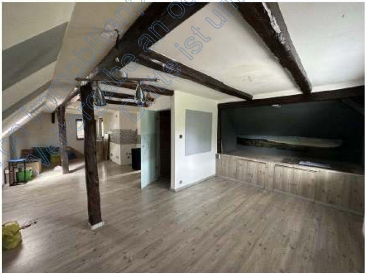
Bild 62: Ausschnitt – Studio mit offener Tür zur Treppe zur Eingangstüre im Erdgeschoss (Wohnhaus II mit zwei Wohneinheiten Wohnung 5 DG).
