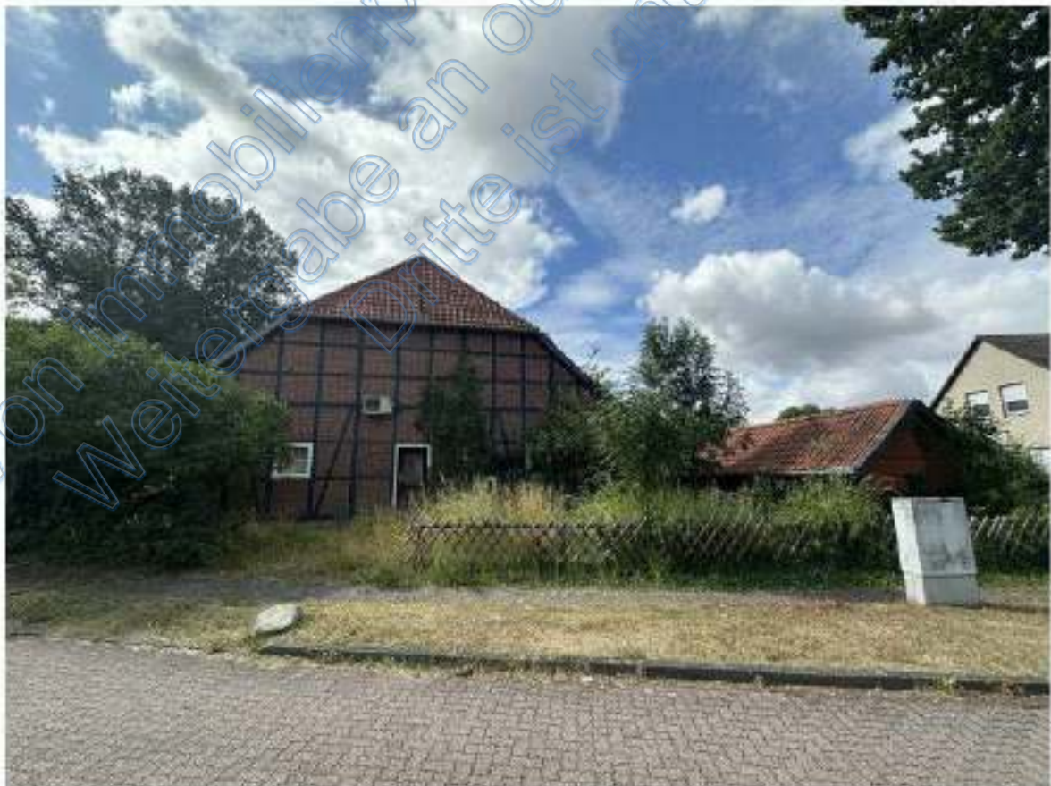
Bild 02: Blick von und über die Straße „Im Winkel“ auf die Nordseite (mit 2. Eingangstür zur Wohnung 2) des Wohnhauses I mit drei Wohneinheiten sowie auf die östliche Dachfläche des Lagergebäudes.
