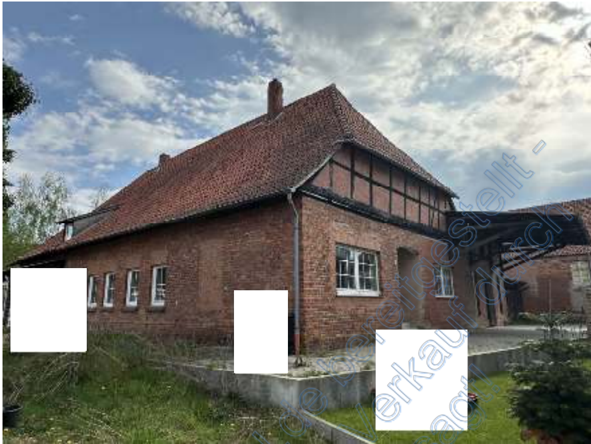
Bild 68: Blick auf die östliche Traufseite ( links ) und die nördliche Giebelseite des Wohn- & Bürogebäudes . Rechts schließt sich die Nordseite ( mit Überdachung ) des Lageranbaus an.
