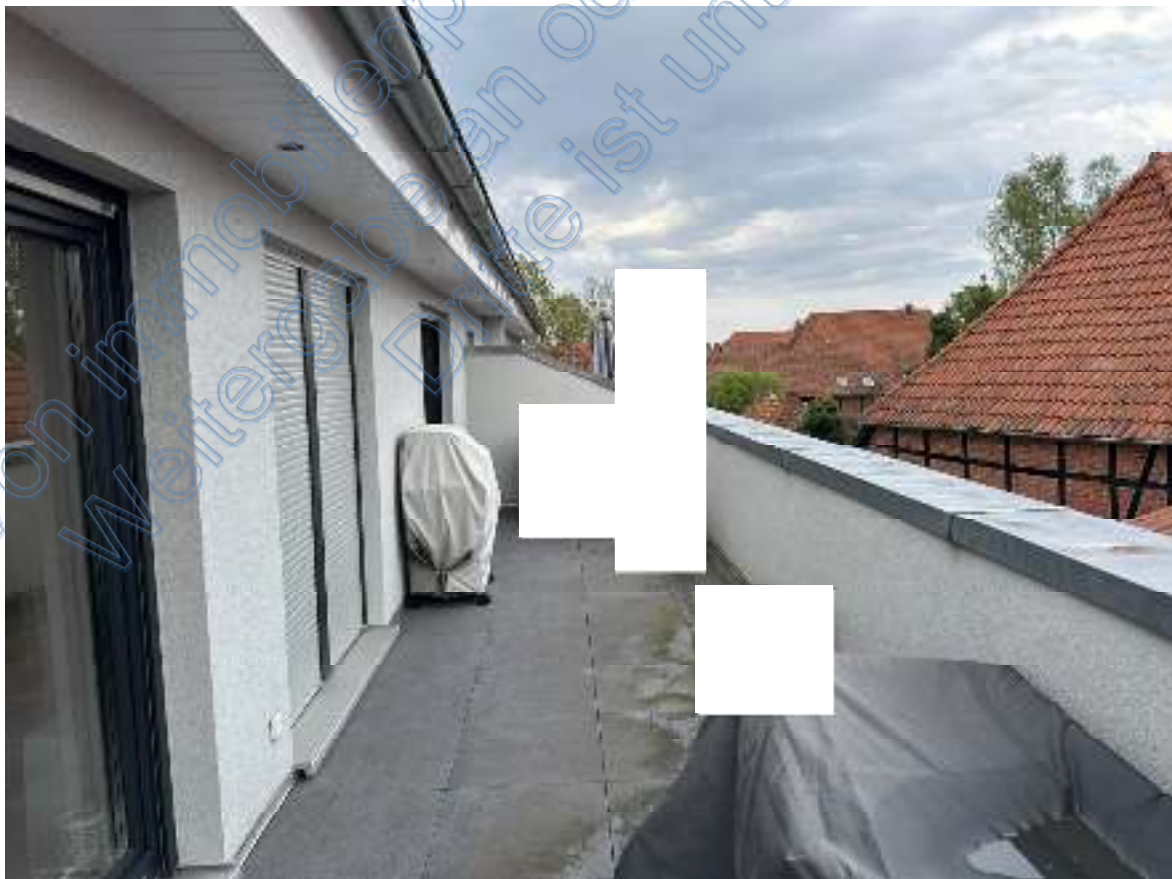
Bild 59: Ausschnitt – Dachterrasse ( Mehrfamilienhaus mit sechs Wohneinheiten Wohnung 06 DG).
