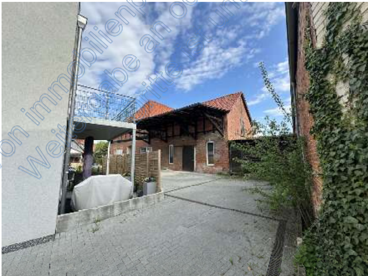
Bild 04: Blick durch den „Durchgang“ auf den Lageranbau am Wohn- & Bürogebäude . Ganz links ist die Südwestecke des Mehrfamilienhauses mit sechs Wohneinheiten zu sehen.
