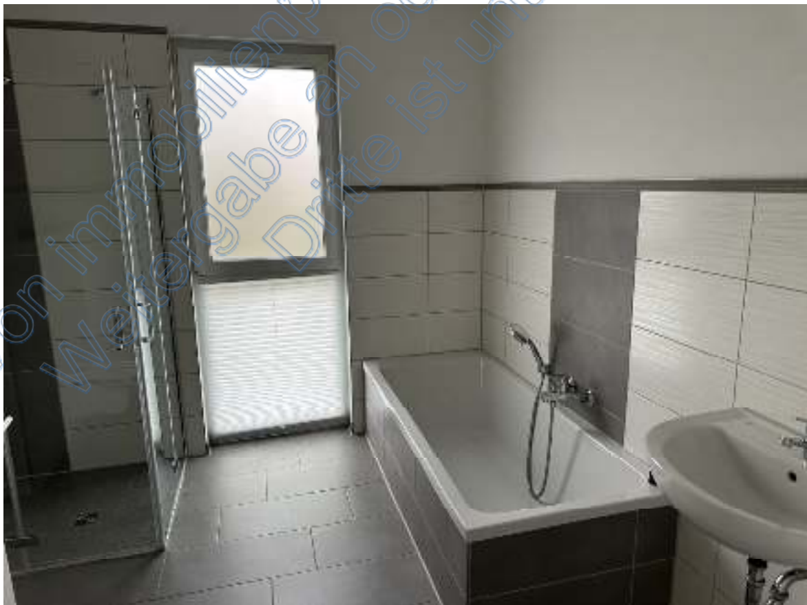
Bild 35: Ausschnitt – Bad ( Mehrfamilienhaus mit sechs Wohneinheiten Wohnung 04 OG).
