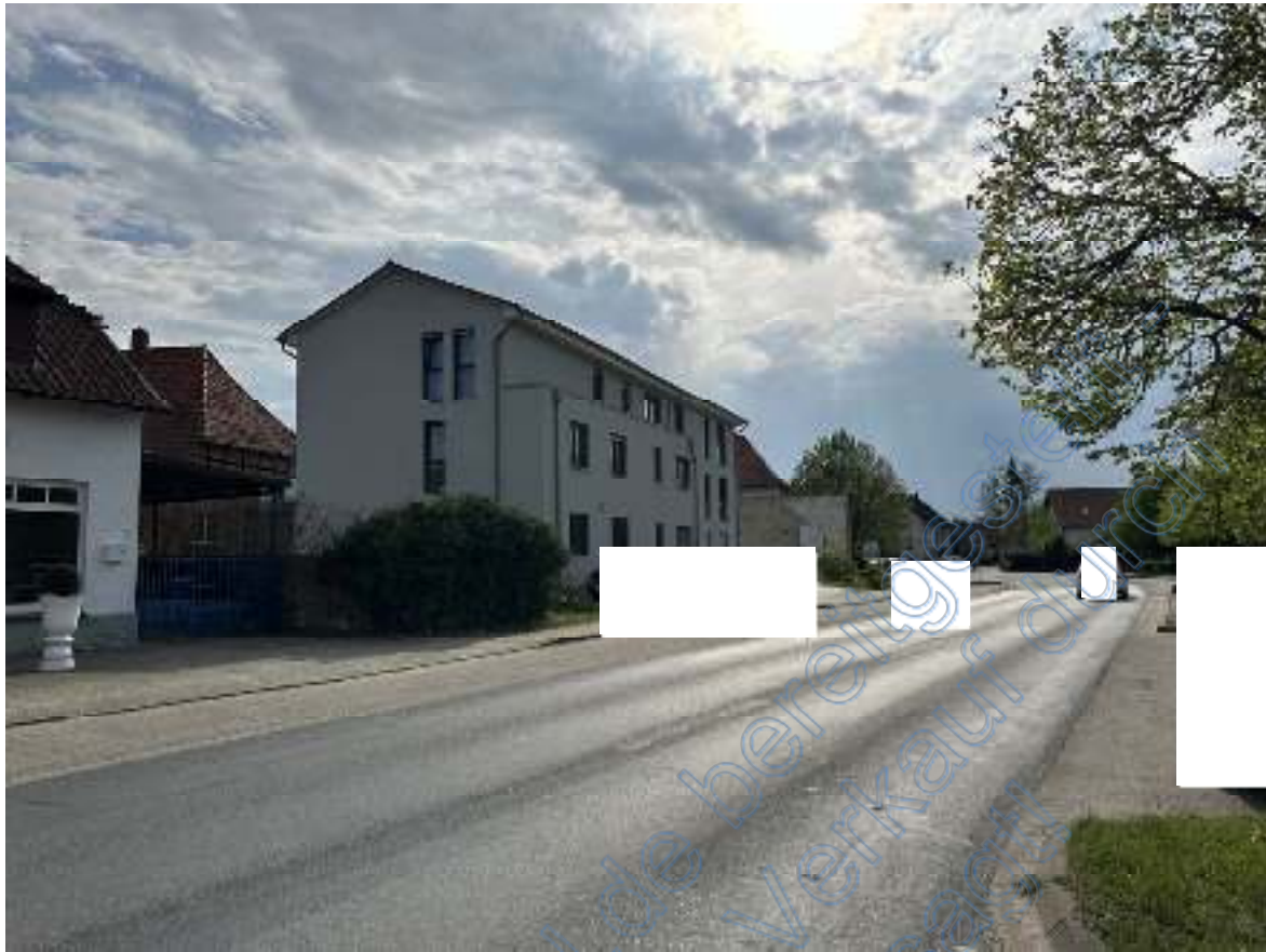
Bild 01: Blick entlang der Hauptstraße in Richtung Westen. Mittig, auf der südlichen Straßenseite, ist das Mehrfamilienhaus mit sechs Wohneinheiten des Bewertungsobjektes zu sehen.
