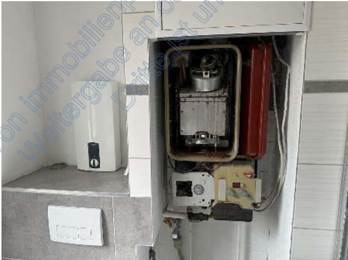
Bild 87: Ausschnitt – „abgängige“ Therme im Bad
