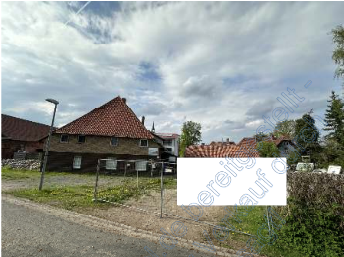
Bild 90: Blick von der Straße „Twetge“ auf und über die unbebaute südöstliche Grundstücksfläche in Richtung des massiven Lagerschuppens. Links ist die südliche Giebelseite des Wohn- & Bürogebäudes zu sehen.
