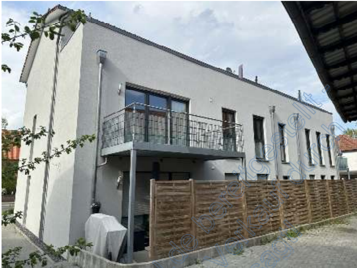
Bild 05: Blick auf die Südseite und die sich links anschließende Westseite des Mehrfamilienhauses mit sechs Wohneinheiten.
