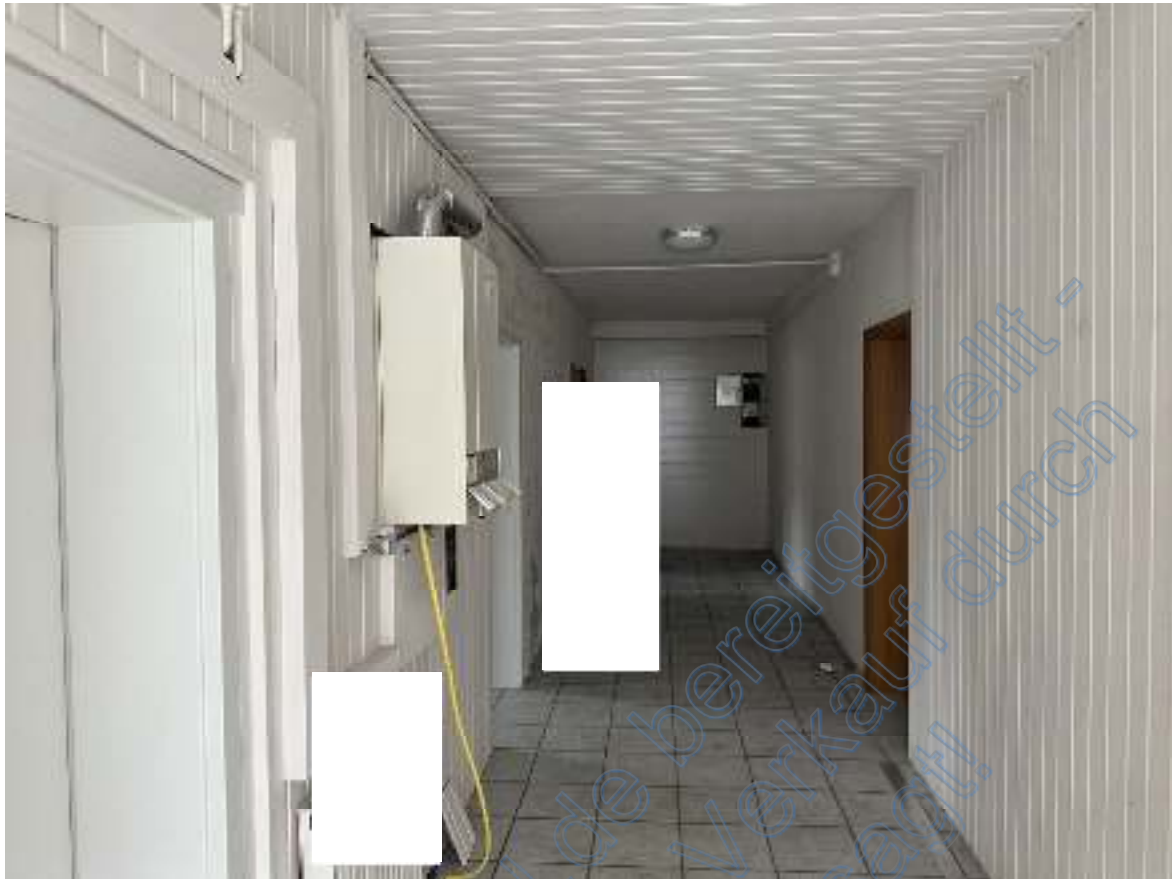
Bild 70: Ausschnitt – Flur mit Therme (Wohn- & Bürogebäude Erdgeschosswohnung EG).
