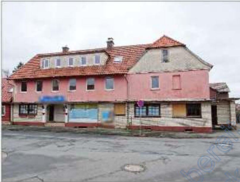
Foto 1 - gemischt genutztes Gebäude - Westansicht
