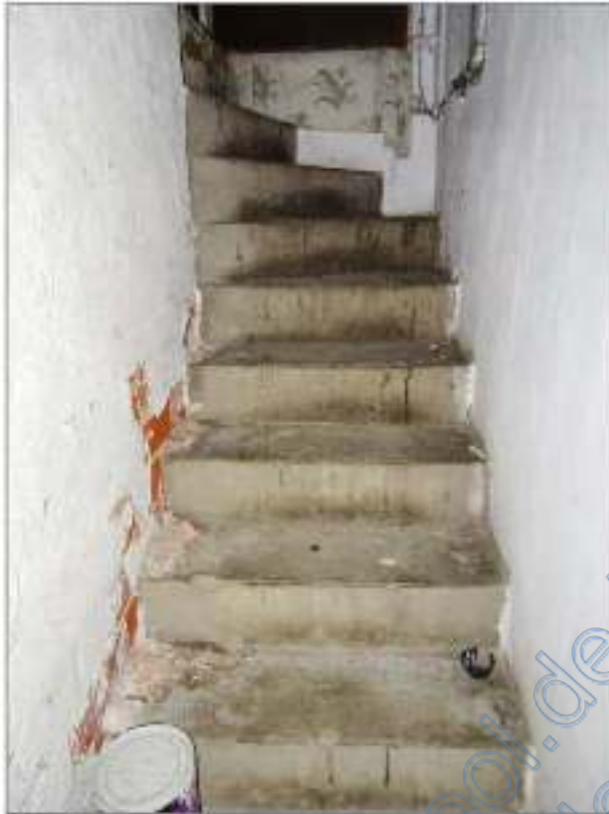
Foto 5 - gemischt genutztes Gebäude - Kellertreppe
