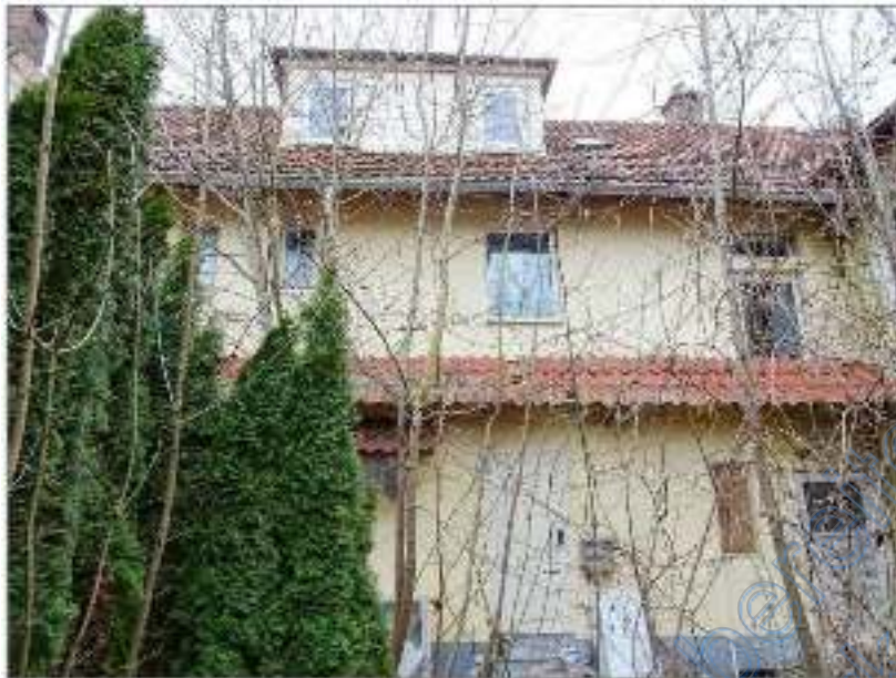
Foto 3 - gemischt genutztes Gebäude - Ostansicht
