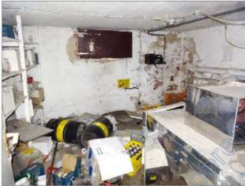
Foto 13 - gemischt genutztes Gebäude - Kellerraum (nördlicher Teil)
