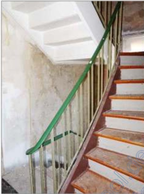
Foto 17 - gemischt genutztes Gebäude - Treppe EG-OG
