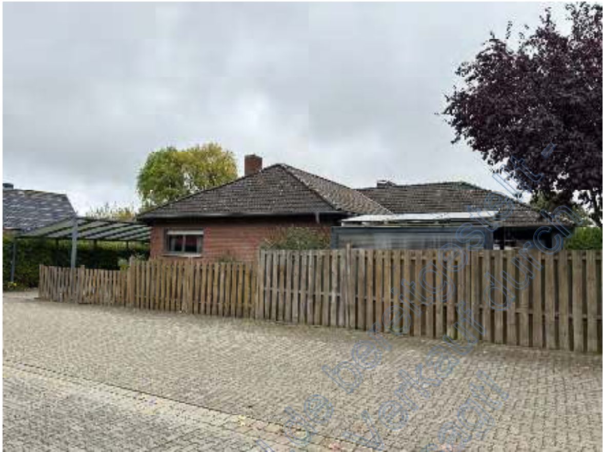
Bild 05: Blick über den Lehmrings auf die westliche Grundstückseinfriedung und das dahinter liegende Einfamilienhaus des Bewertungsobjektes.
