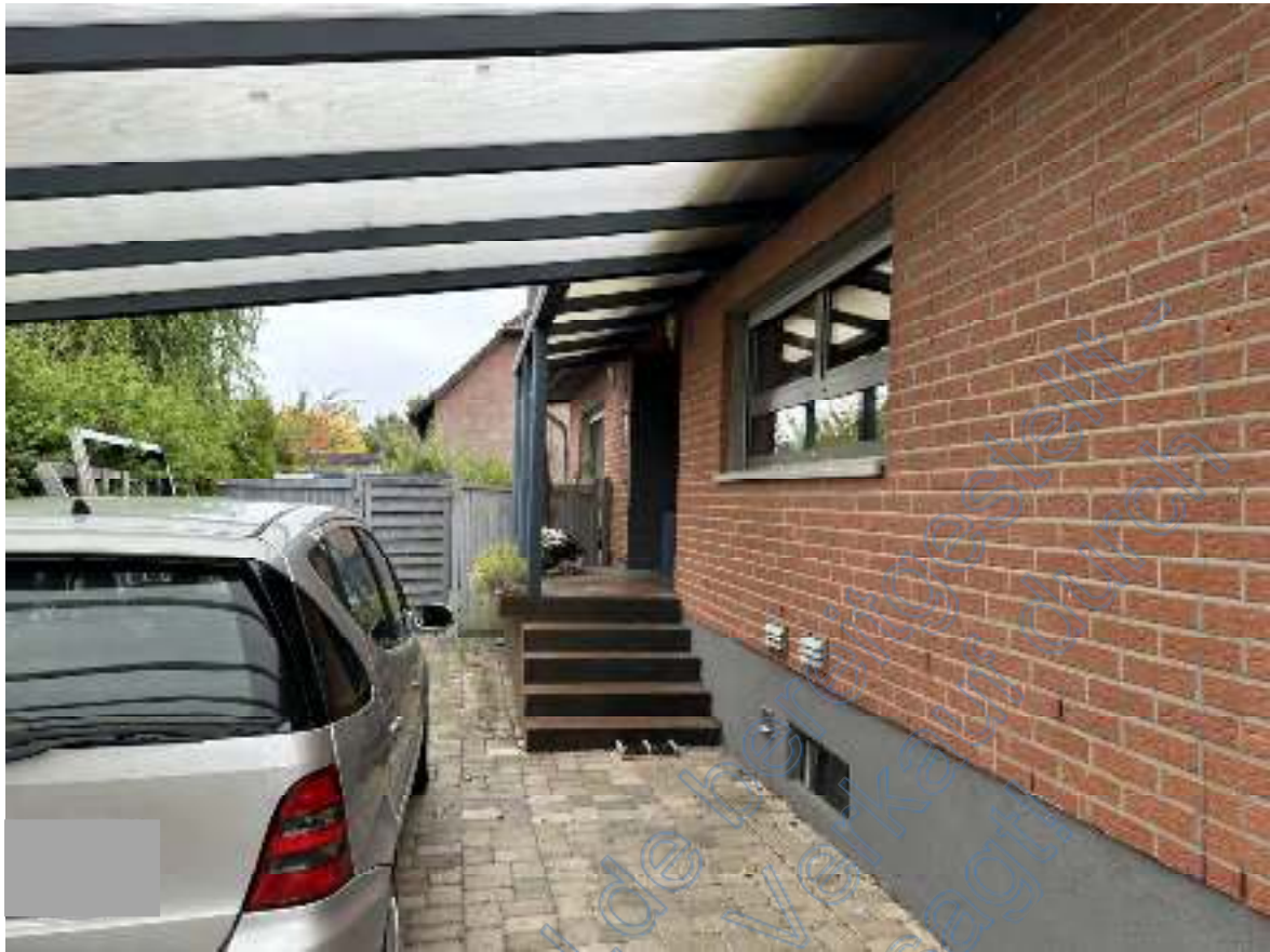
Bild 07: Blick von der Zufahrt / aus dem Carport auf die Zugangstreppe zum Hauseingang des Einfamilienhauses .
