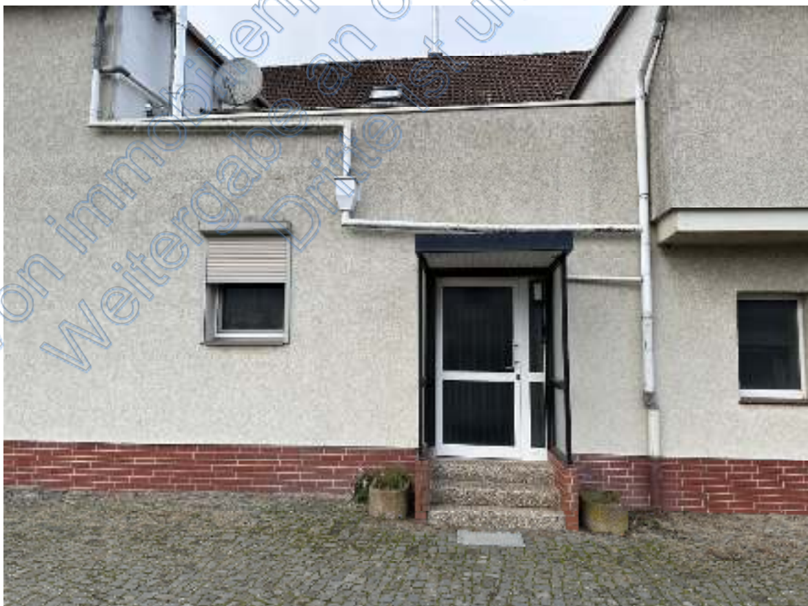
Bild 06: Blick auf die geschlossene Hauseingangstür zum westlichen Mehrfamilienhaus / zur im Dachgeschoss
