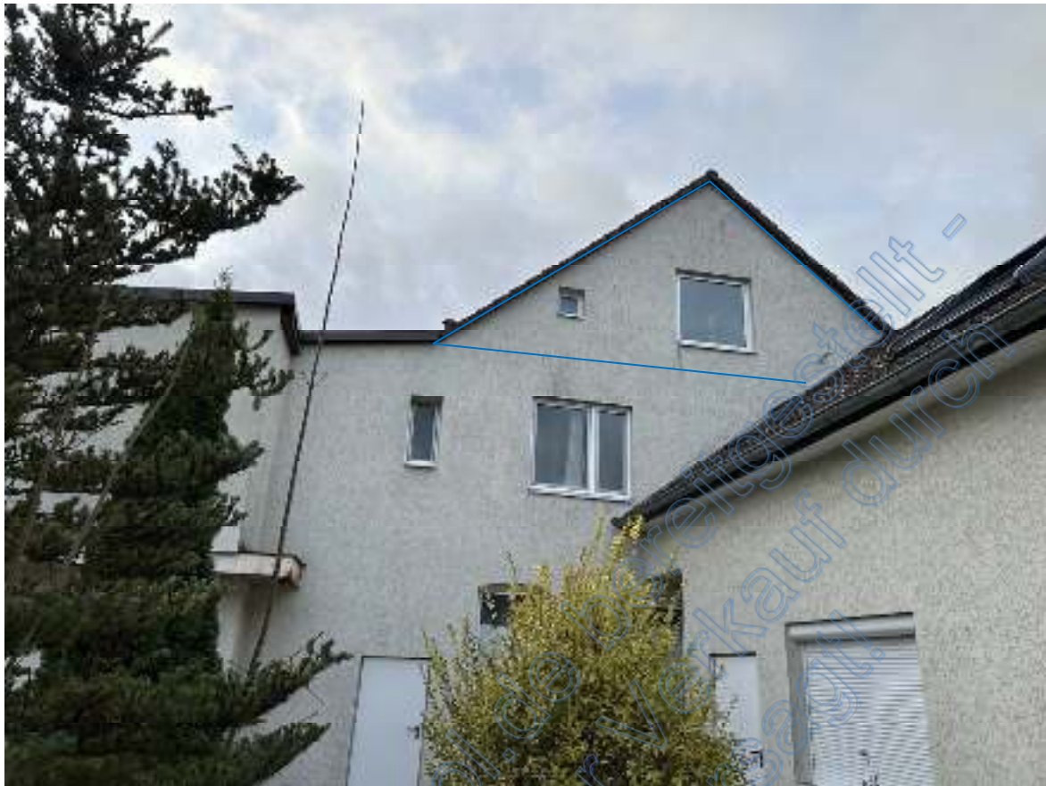
Bild 05: Blick die Ostseite des westlichen Mehrfamilienhauses der Mehrfamilienwohnanlage . Im Giebel sind das kleine Badfenster und das Wohnzimmerfenster der Wohnung Nr. 11 zu sehen.
