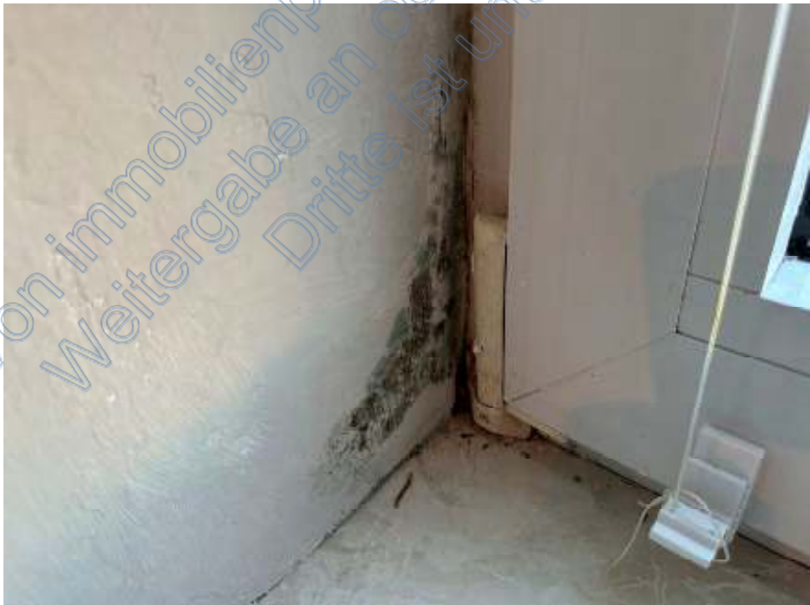
Bild 22: Ausschnitt – Feuchtigkeitsschaden mit Schimmelbildung am Küchenfenster (Mehrfamilienhaus mit sechs Wohnungen Wohnung Nr. 2 EG ).
