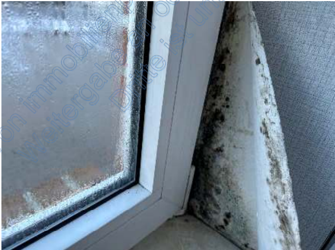
Bild 26: Ausschnitt – „erheblicher“ Feuchtigkeitsschaden mit Schimmelbildung am Nordfenster (Mehrfamilienhaus mit sechs Wohnungen Wohnung Nr. 2 EG).
