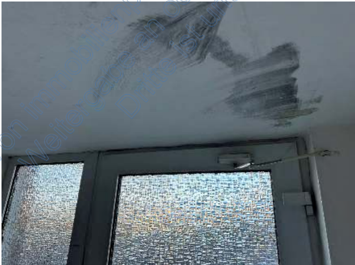
Bild 75: Ausschnitt – „Schleifspuren“ an der Hausflurdecke durch defekte Hauseingangstür (Mehrfamilienhaus mit sechs Wohnungen KG).
