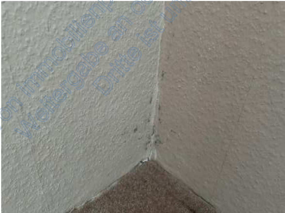
Bild 32: Ausschnitt – Durchfeuchtung in der Südwestecke von Zimmer 3 (Mehrfamilienhaus mit sechs Wohnungen Wohnung Nr. 2 EG ).
