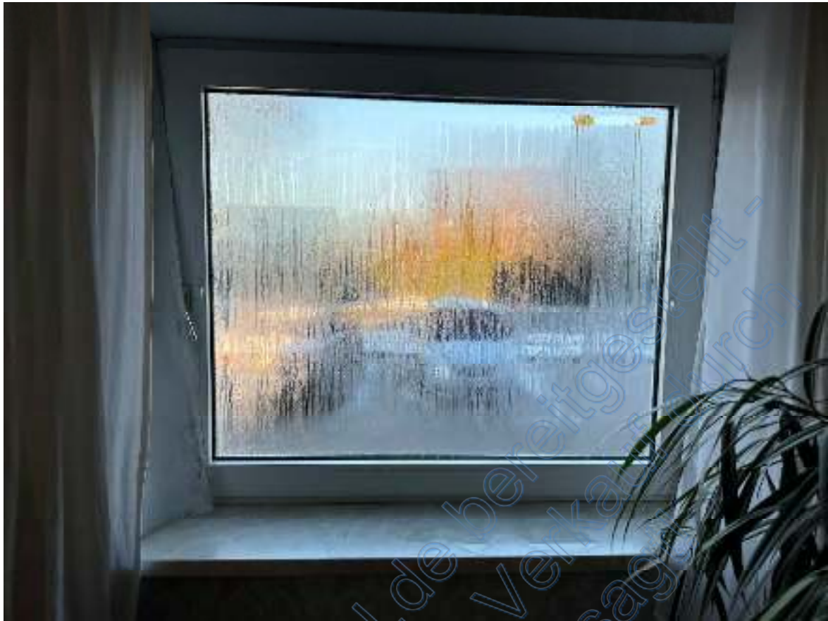
Bild 25: Ausschnitt – „sehr starke“ Kondenswasserbildung am Nordfenster des Wohnzimmers (Mehrfamilienhaus mit sechs Wohnungen Wohnung Nr. 2 EG).
