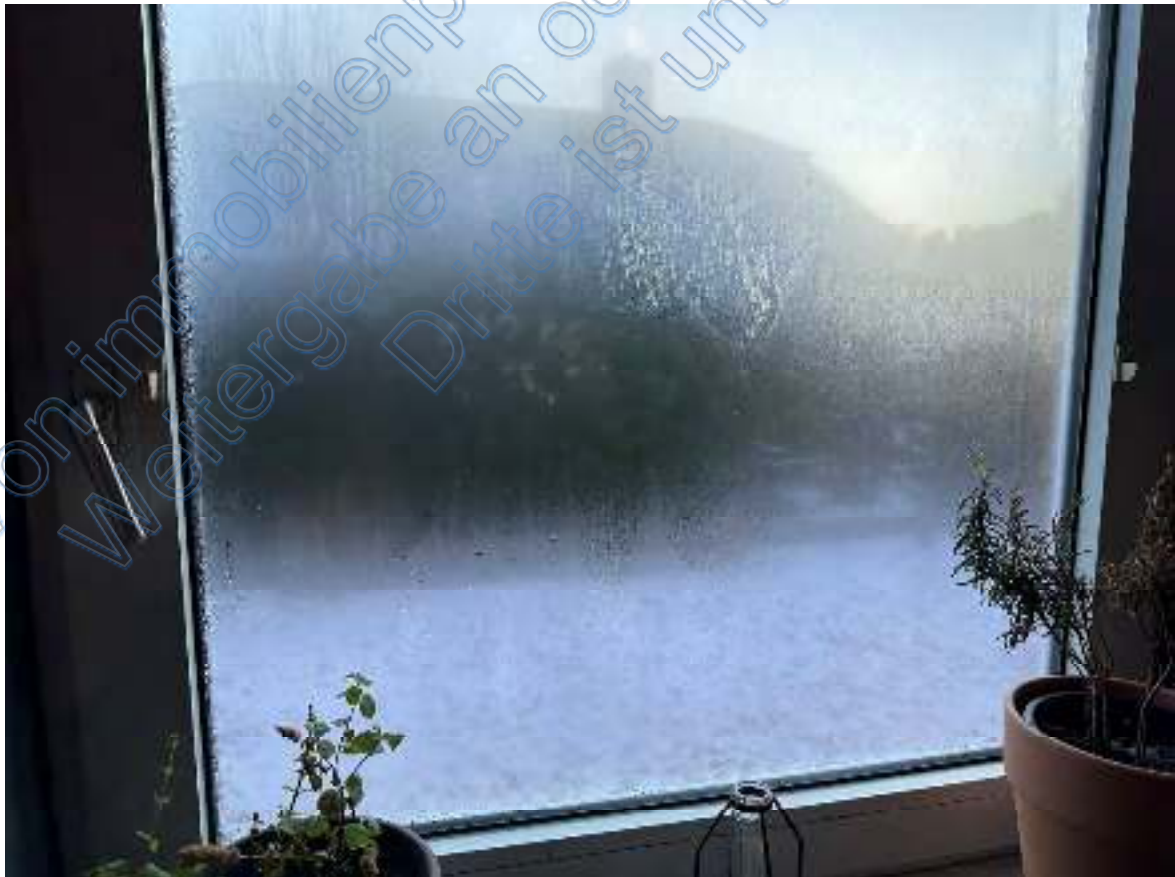
Bild 30: Ausschnitt – Kondenswasserbildung am Fenster von Zimmer 2 (Mehrfamilienhaus mit sechs Wohnungen Wohnung Nr. 2 EG ).
