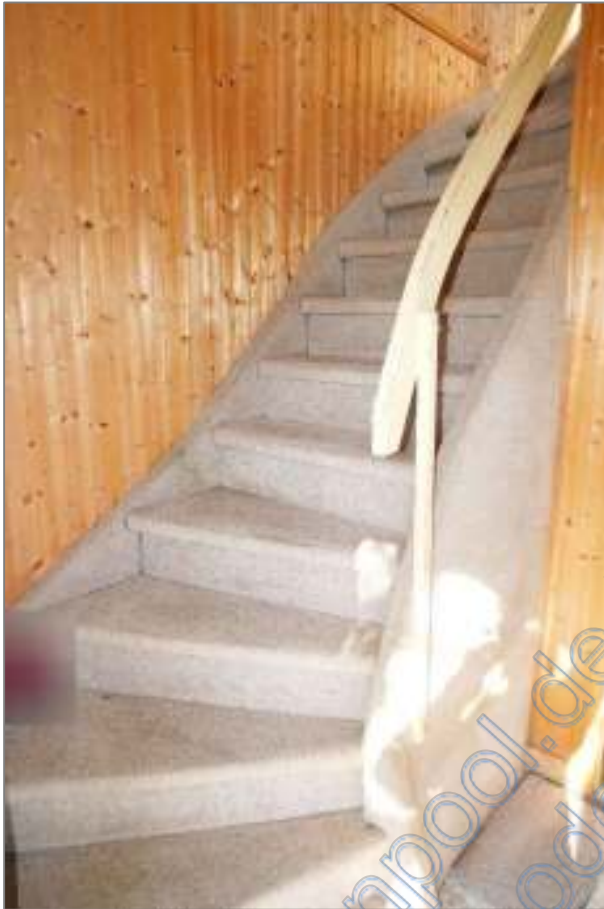
Foto 8 - Wohnhaus - Treppe vom EG zum DG
