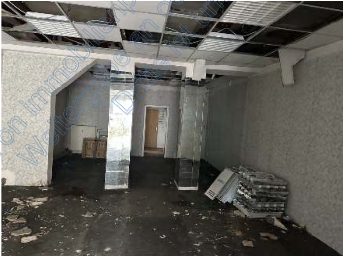
Bild 12: Ausschnitt – Ladenbereich Richtung offener Tür zum Flur ( Wohn- & Geschäftshaus Gewerbeinheit 1 EG).
