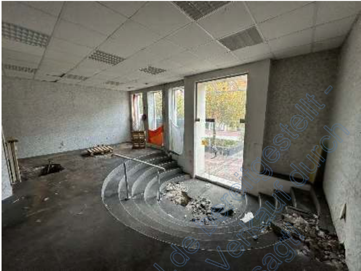
Bild 11: Ausschnitt – Eingangssituation / vorderer Ladenbereich ( Wohn- & Geschäftshaus Gewerbeinheit 1 EG).
