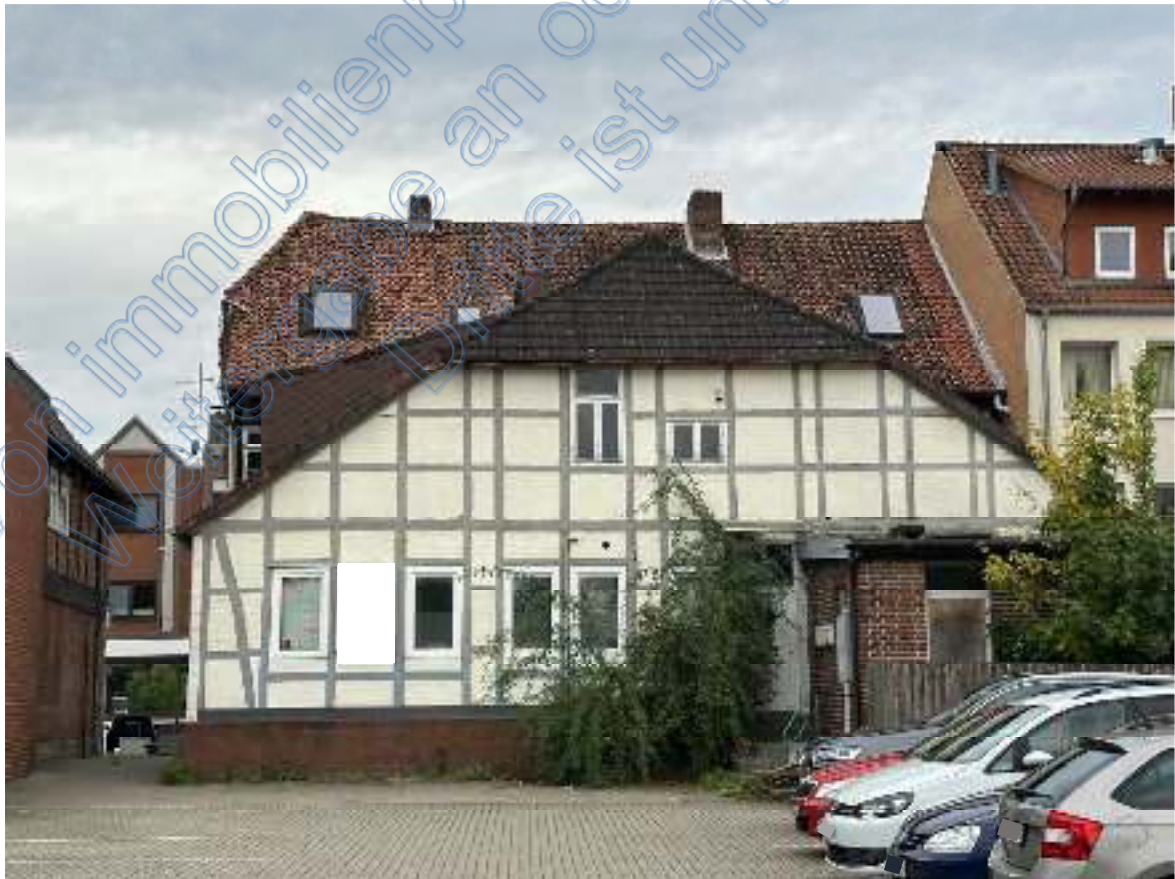
Bild 02: Blick vom nachbarlichen Parkplatzgrundstück 8/8 auf die östliche Giebelseite des Wohn- & Geschäftshauses des Bewertungsobjektes. Rechts unten ist der Flachdachanbau
