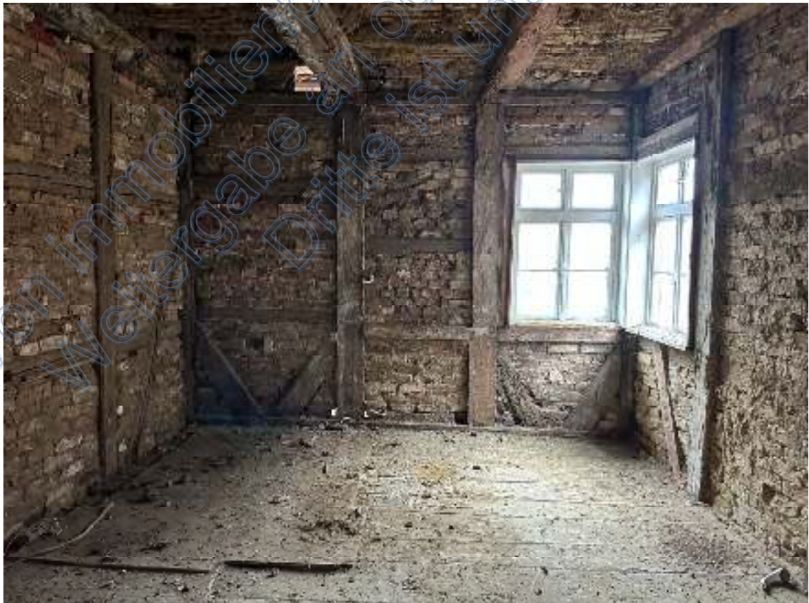
Bild 42: Ausschnitt – Raum 4 ( Wohn- & Geschäftshaus im „Rohbau“ befindliche Wohnebene OG).
