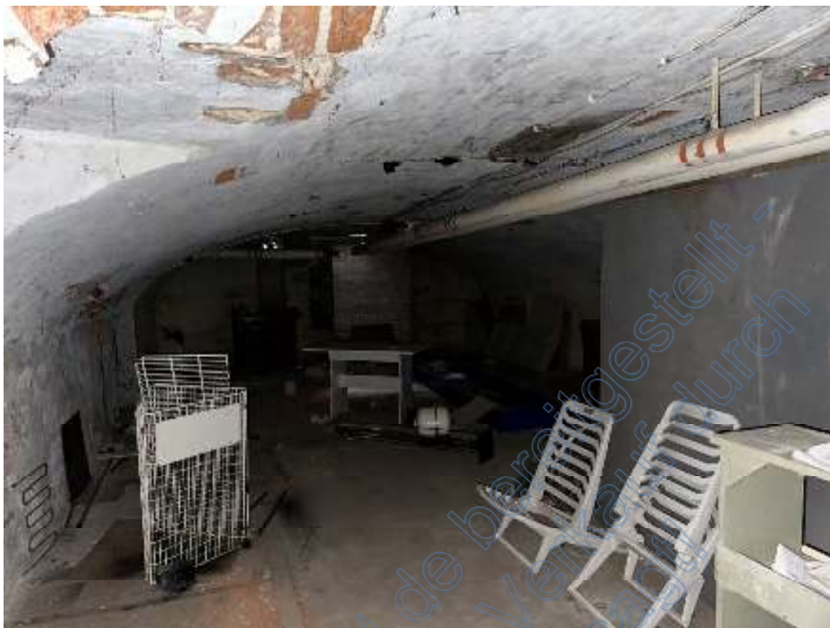
Bild 31: Ausschnitt – dritter Gewölbekellerraum ( Wohn- & Geschäftshaus KG ).
