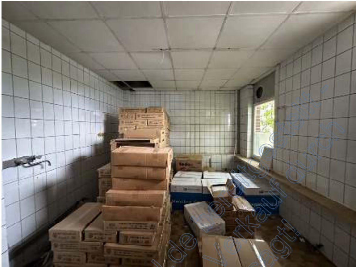
Bild 15: Ausschnitt – hinterer Raum / ehem. genutzt als Küche bzw. Büro ( Wohn- & Geschäftshaus Gewerbeinheit 1 EG).
