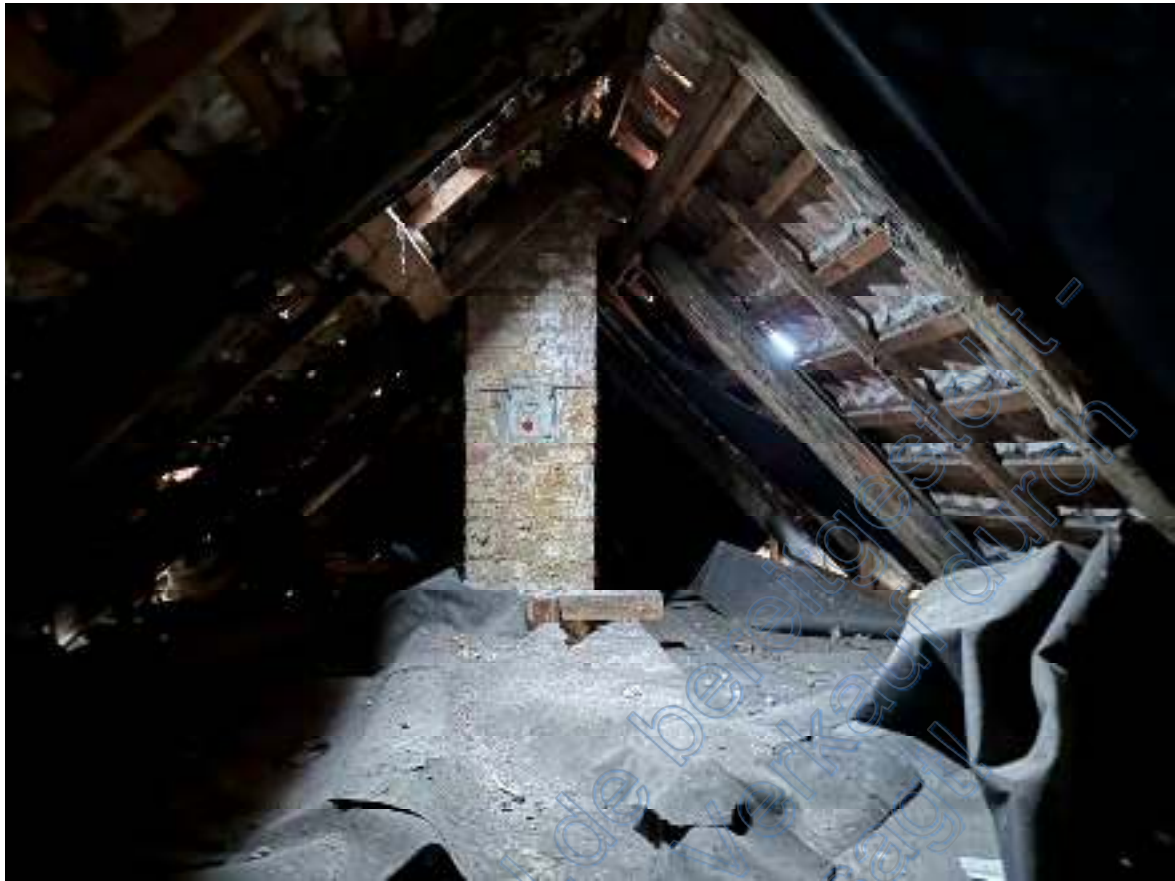
Bild 51: Ausschnitt – Spitzbodenraum ( Wohn- & Geschäftshaus SBG ).
