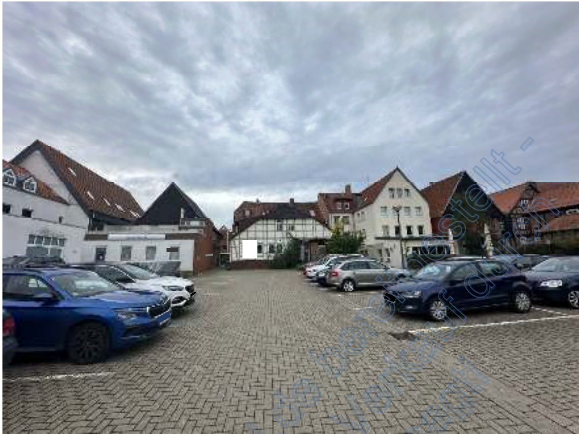
Bild 01: Blick über das nachbarliche Parkplatzgrundstück 8/8 auf die östliche Giebelseite des Wohn- & Geschäftshauses des Bewertungsobjektes.
