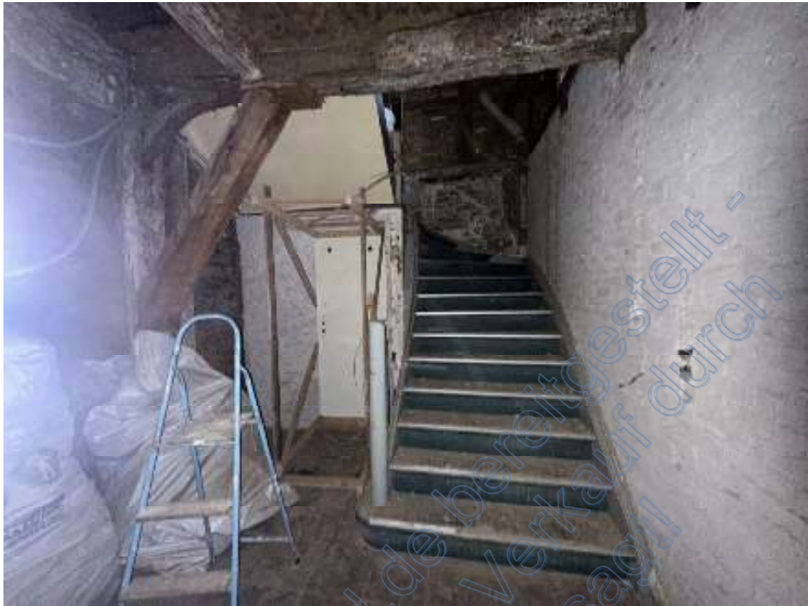
Bild 37: Ausschnitt – Treppe in Richtung der im „Rohbau“ befindlichen Wohnebenen im OG & DG ( Wohn- & Geschäftshaus EG Richtung OG).
