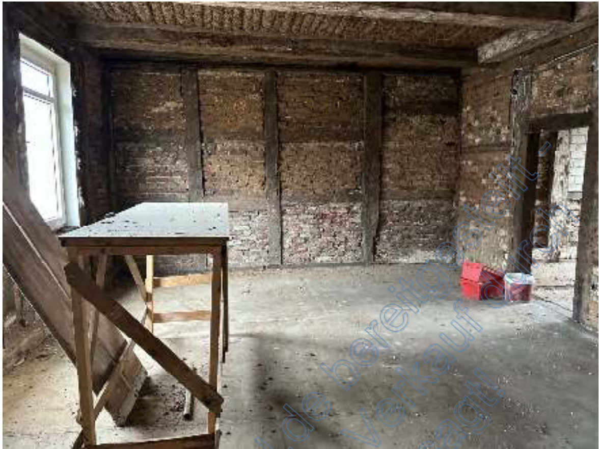
Bild 41: Ausschnitt – Raum 3 ( Wohn- & Geschäftshaus im „Rohbau“ befindliche Wohnebene OG).
