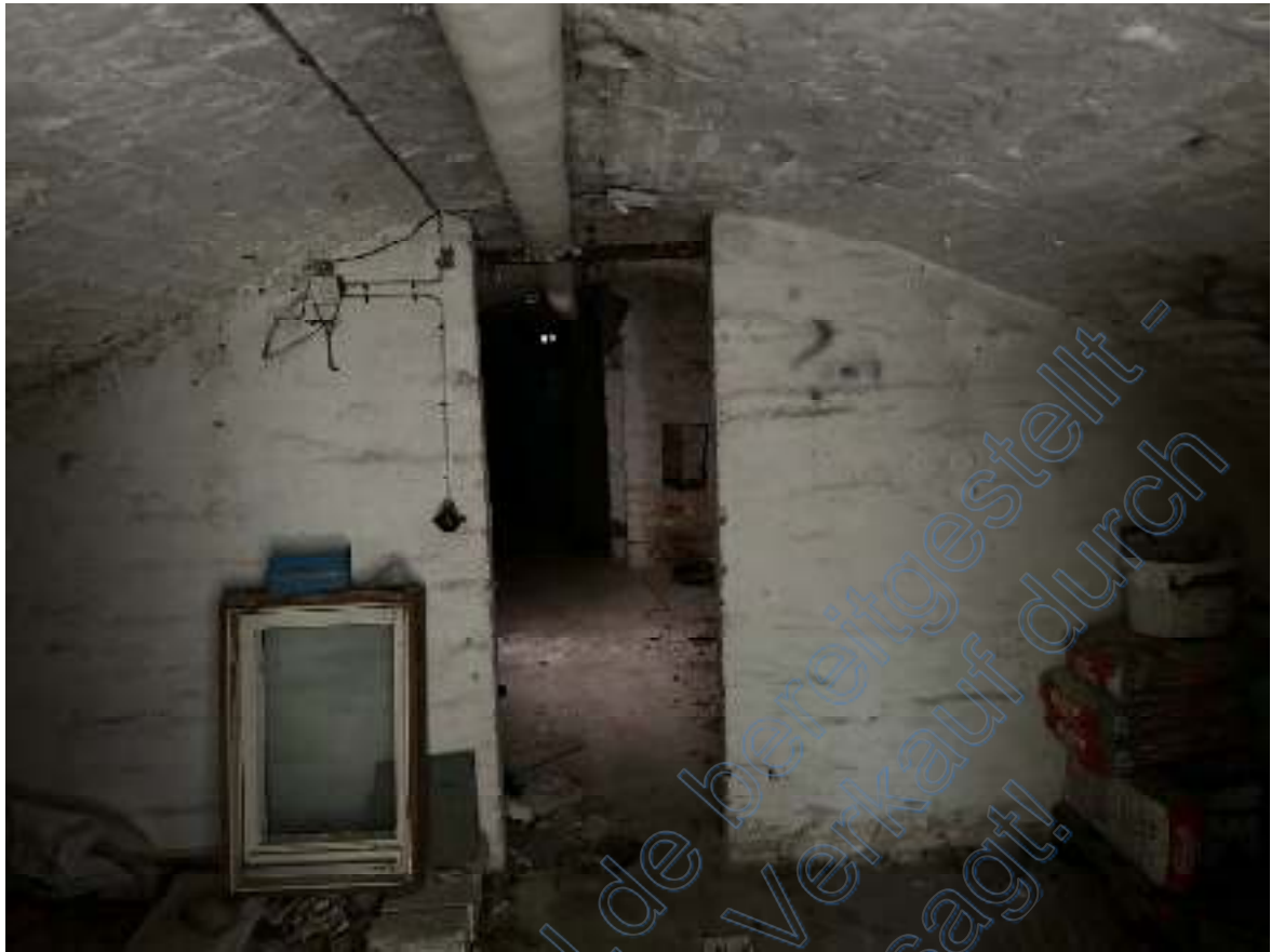
Bild 29: Ausschnitt – erster Gewölbekellerraum Richtung Durchgang zum zweiten Gewölbekellerraum ( Wohn- & Geschäftshaus KG ).
