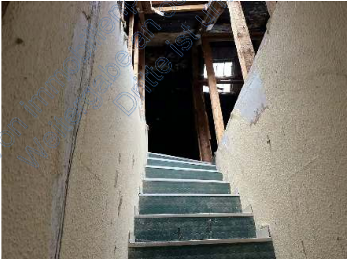
Bild 48: Ausschnitt – Treppe Richtung der im „Rohbau“ befindlichen Wohnebene im Dachgeschoss ( Wohn- & Geschäftshaus OG Richtung DG).
