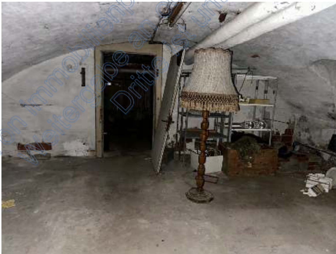
Bild 32: Ausschnitt – vierter Gewölbekellerraum Richtung Durchgang zum fünften Gewölbekellerraum ( Wohn- & Geschäftshaus KG ).
