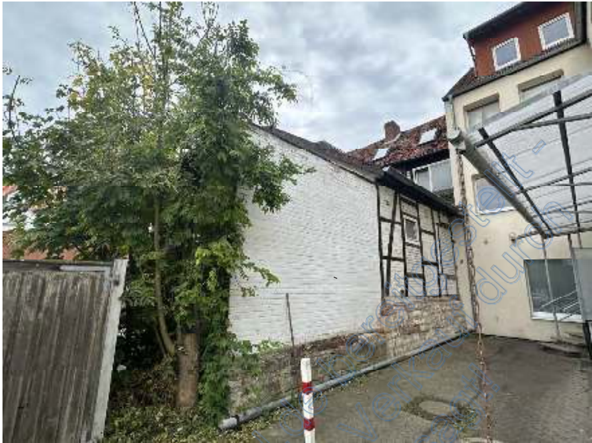
Bild 03: Blick vom nachbarlichen Grundstück 5/11 auf die nördliche Traufseite („Fachwerkwand“) des Wohn- & Geschäftshauses . Mittig ist die Nordseite des Flachdachanbaus zu sehen.
