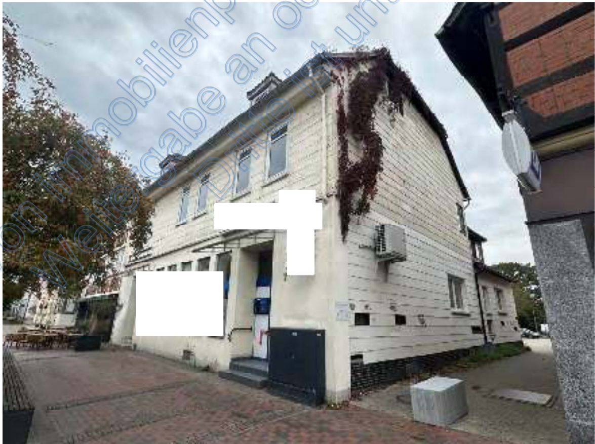
Bild 06: Blick vom Steinweg (Fußgängerzone) auf die westliche Traufseite (Eingangsseite der Gewerbeeinheiten) des Wohn- & Geschäftshauses . Rechts schließt sich (entlang der Gasse Richtung Osten) die
