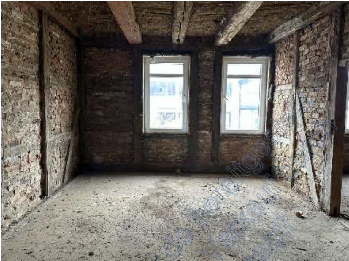
Bild 39: Ausschnitt – Raum 1 ( Wohn- & Geschäftshaus im „Rohbau“ befindliche Wohnebene OG).
