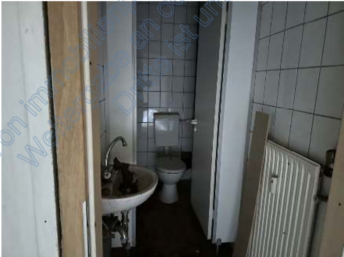
Bild 14: Ausschnitt – Damentoilette ( Wohn- & Geschäftshaus Gewerbeinheit 1 EG).
