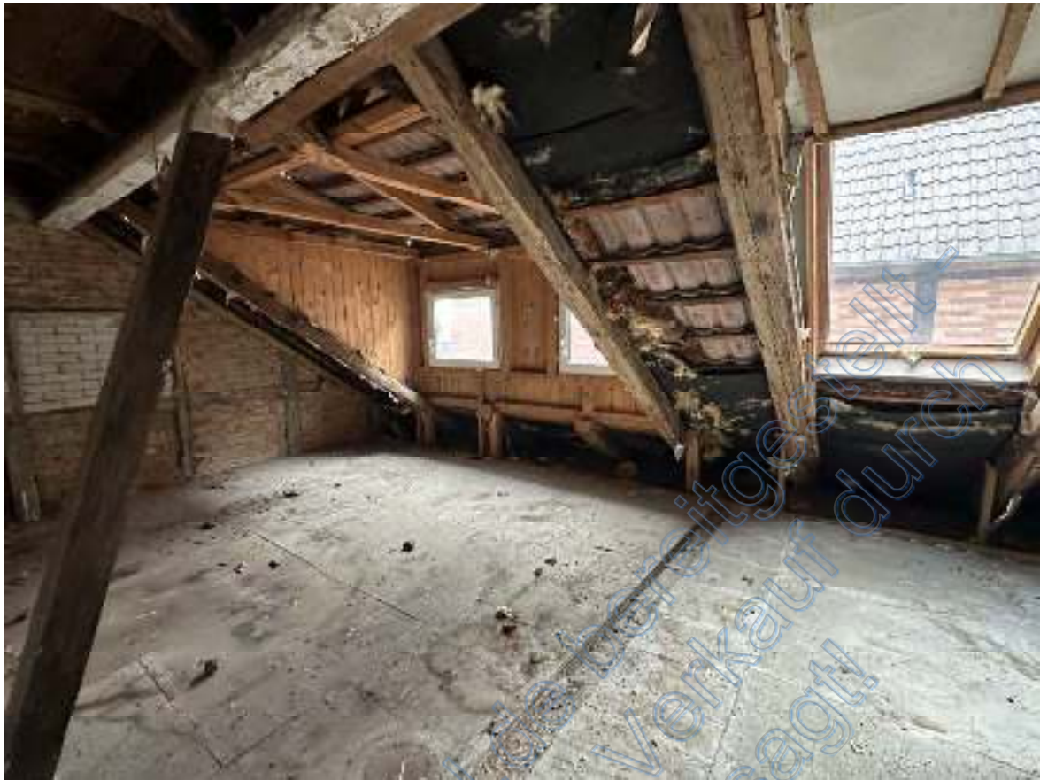
Bild 47: Ausschnitt – Raum 9 ( Wohn- & Geschäftshaus im „Rohbau“ befindliche Wohnebene OG).
