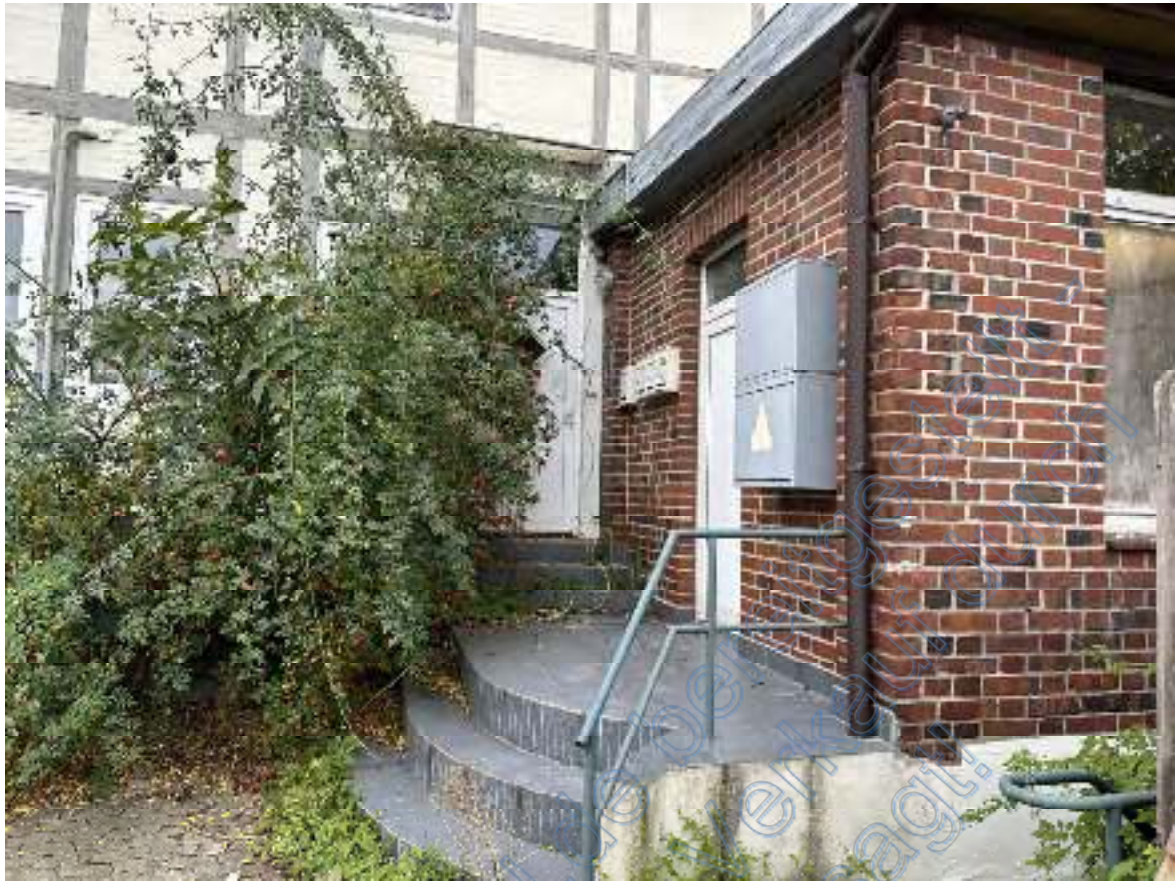
Bild 35: Blick Richtung geschlossener Hauseingangstür (mittig) zum Hausflur und zu den im „Rohbau“ befindlichen Wohnebenen im Ober- & Dachgeschoss des Wohn- & Geschäftshauses .
