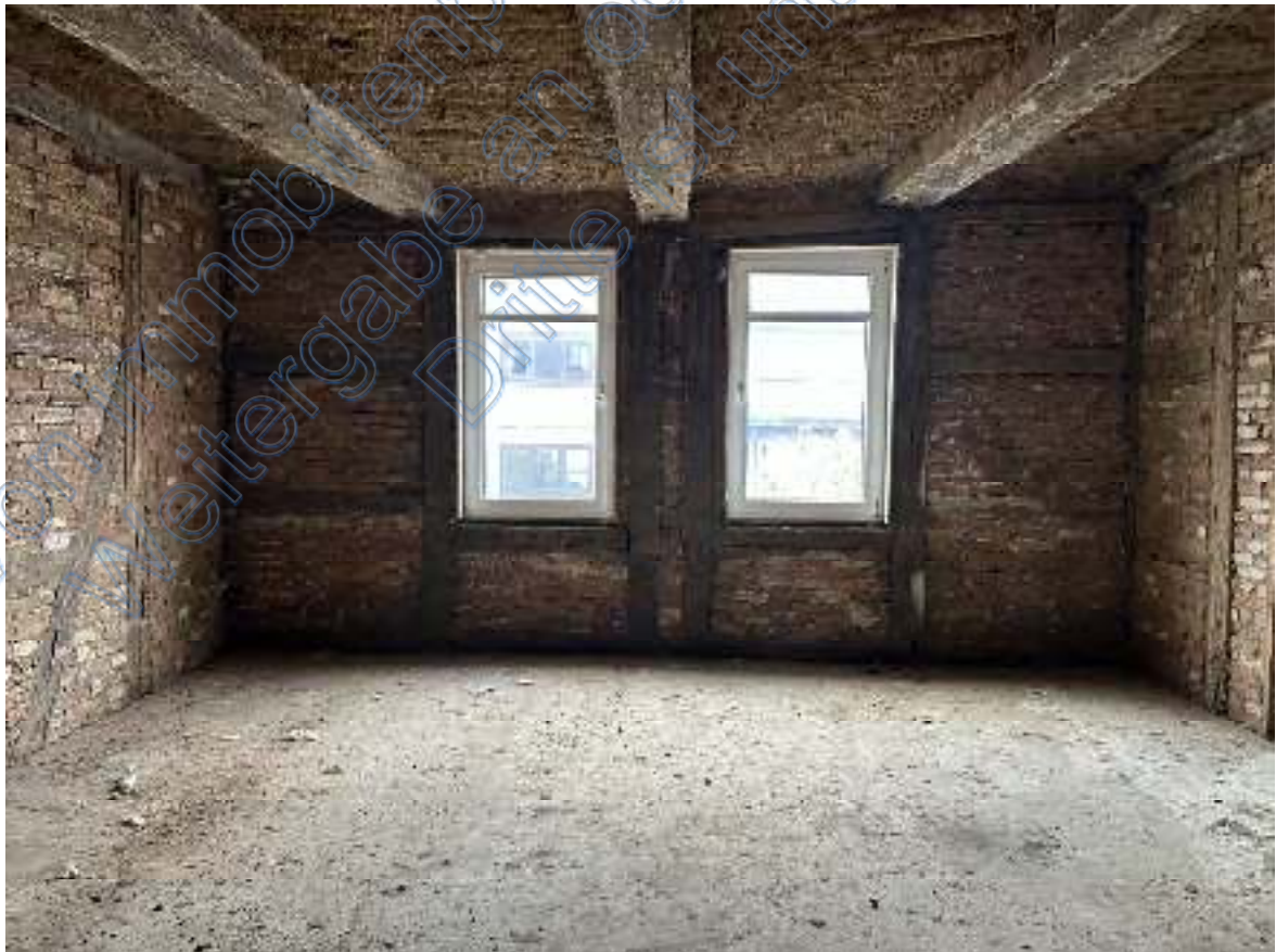
Bild 40: Ausschnitt – Raum 2 ( Wohn- & Geschäftshaus im „Rohbau“ befindliche Wohnebene OG).
