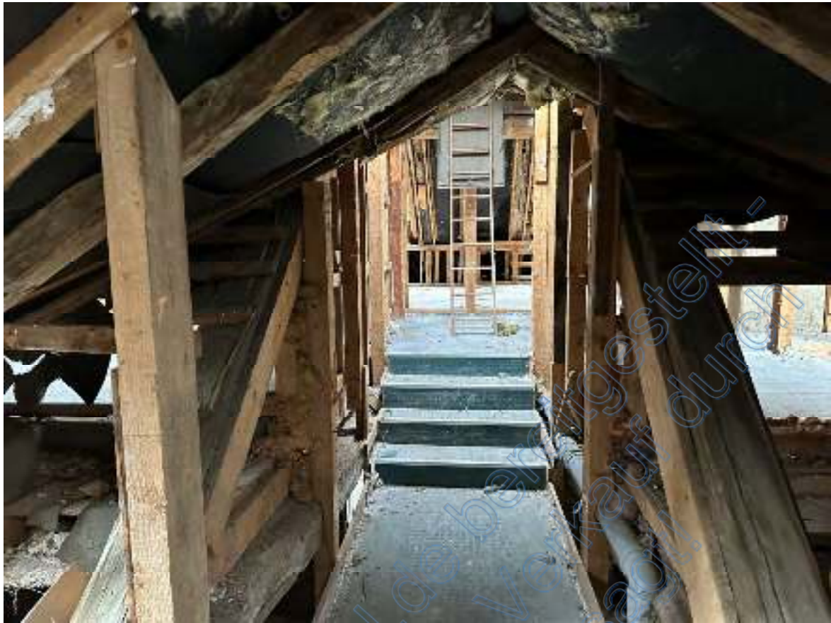
Bild 49: Ausschnitt – Zwischenstufen zu der im „Rohbau“ befindlichen Wohnebene im Dachgeschoss ( Wohn- & Geschäftshaus DG ).
