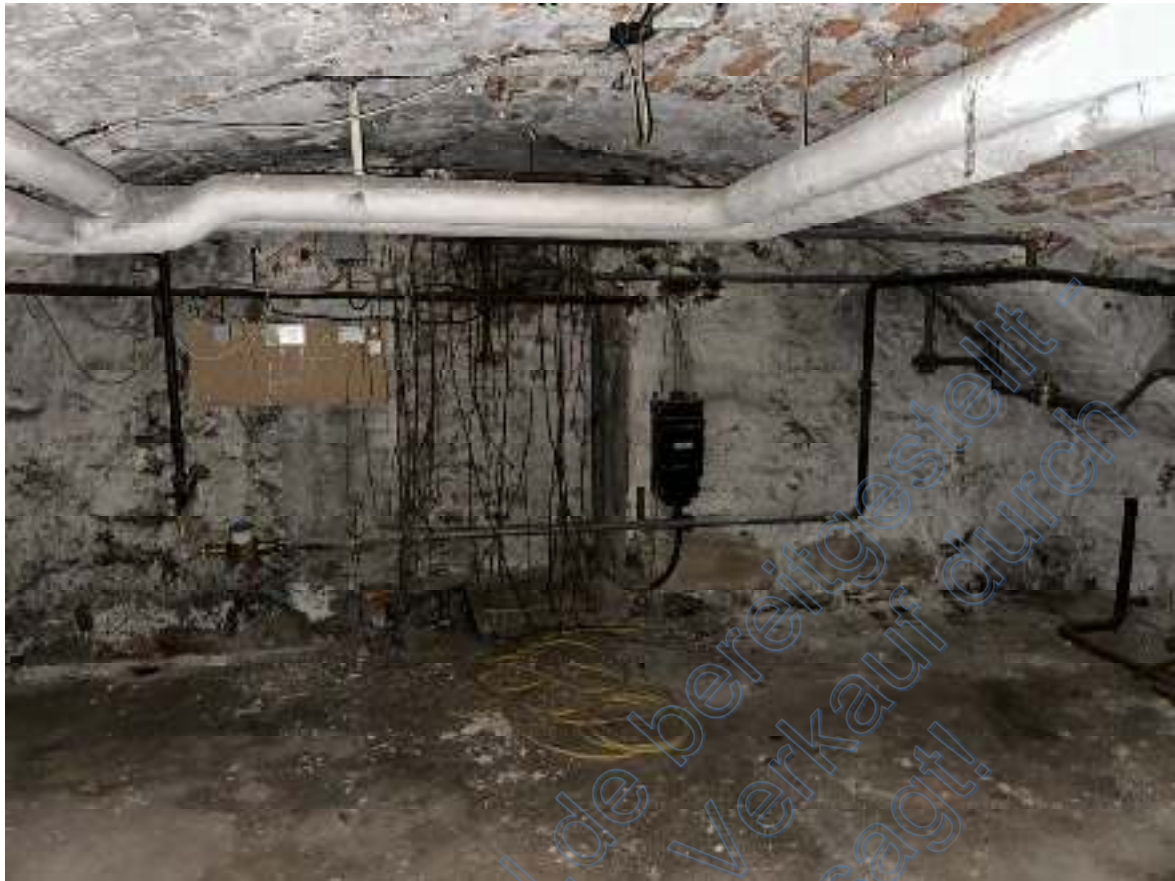
Bild 33: Ausschnitt – fünfter Gewölbekellerraum (Wohn- & Geschäftshaus KG).
