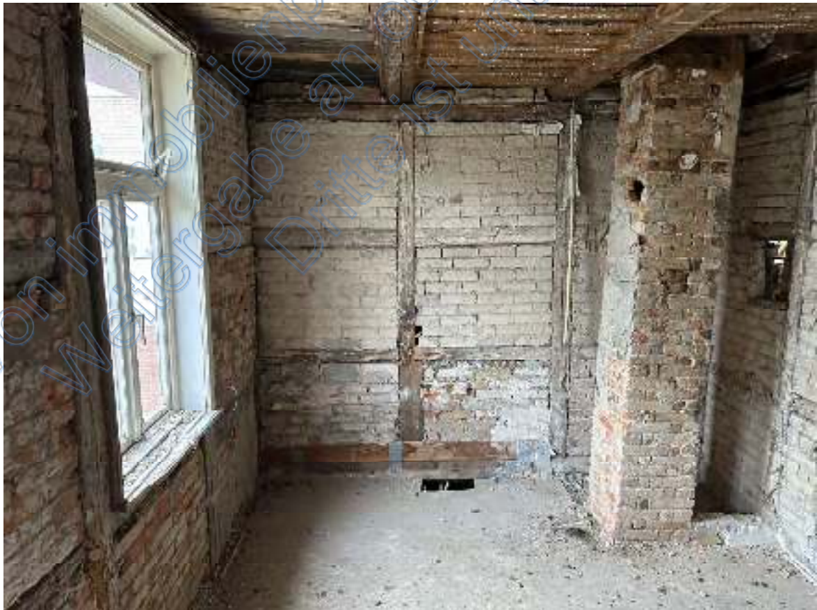
Bild 46: Ausschnitt – Raum 8 ( Wohn- & Geschäftshaus im „Rohbau“ befindliche Wohnebene OG).
