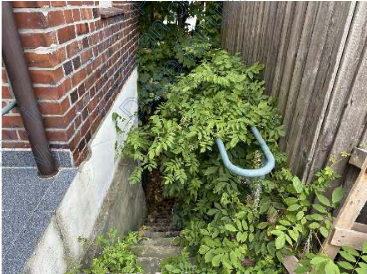
Bild 28: Blick auf / über die Treppe zum Kellergeschoß des Wohn- & Geschäftshauses .
