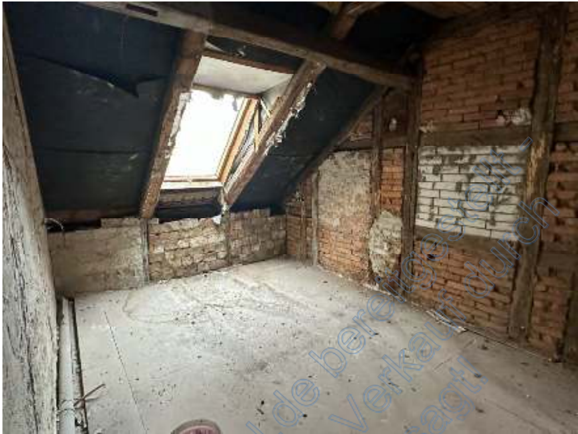
Bild 45: Ausschnitt – Raum 7 ( Wohn- & Geschäftshaus im „Rohbau“ befindliche Wohnebene OG).
