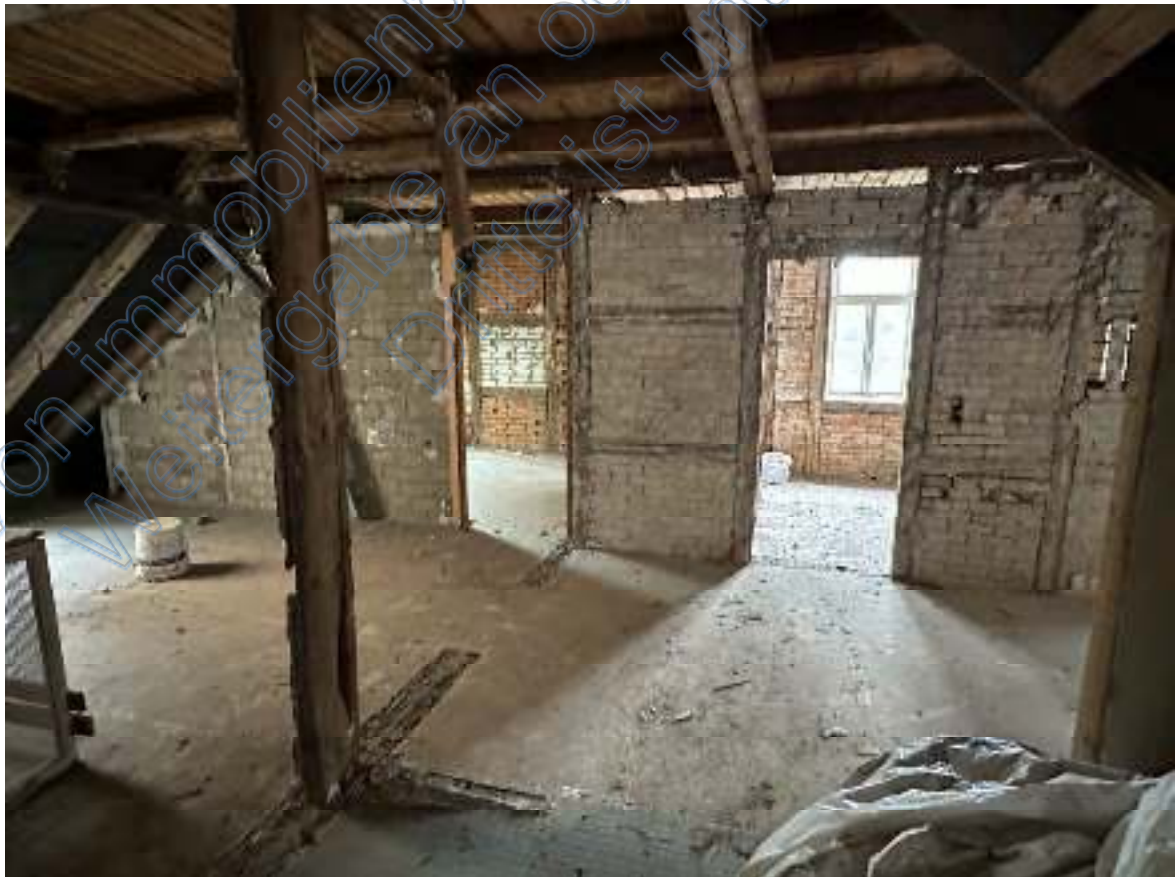
Bild 44: Ausschnitt – südlicher Flurbereich mit offenen Durchgängen zu den Räumen 7 & 8
