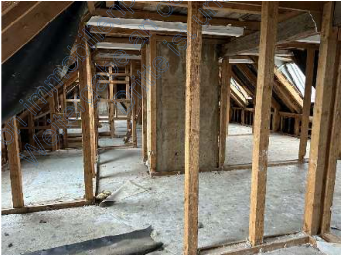
Bild 50: Ausschnitt – im „Rohbau“ befindliche Wohnebene im Dachgeschoss ( Wohn- & Geschäftshaus DG ).
