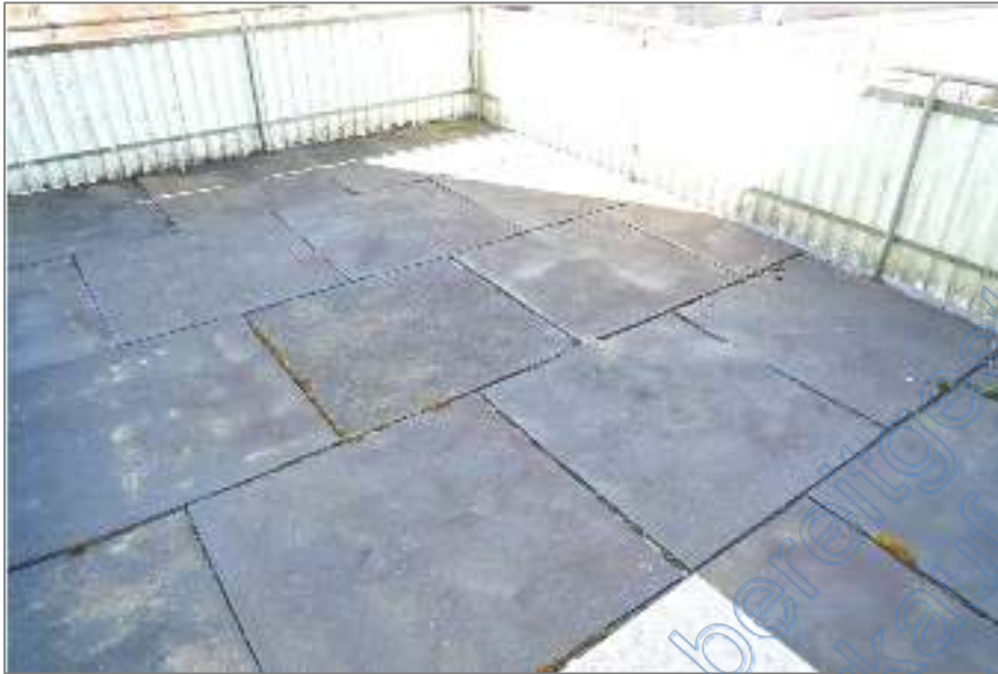
Foto 17 - Wohnhaus - Dachterrasse auf dem Garagenanbau
