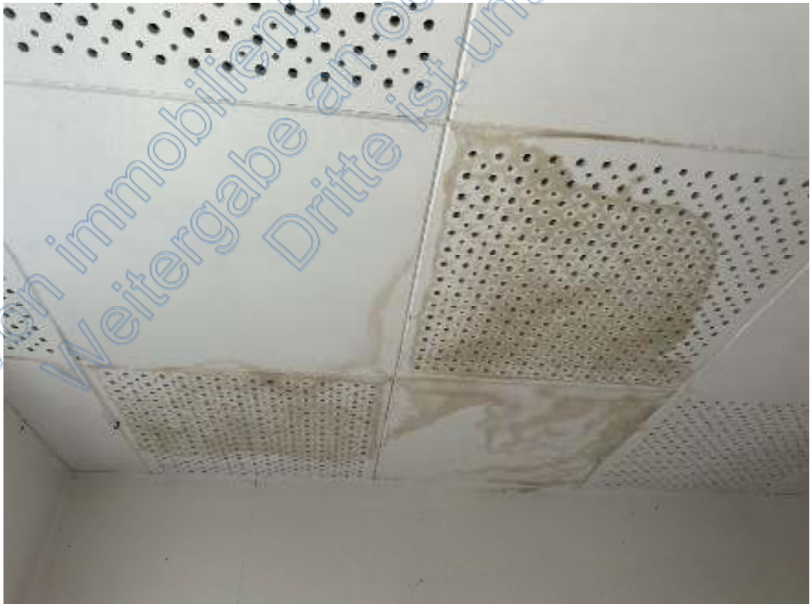
Bild 34: Ausschnitt – „ältere“ Feuchtigkeitsbereiche in der Küchendecke (Wohnhaus mit zwei Wohneinheiten Wohnung 2 DG ).
