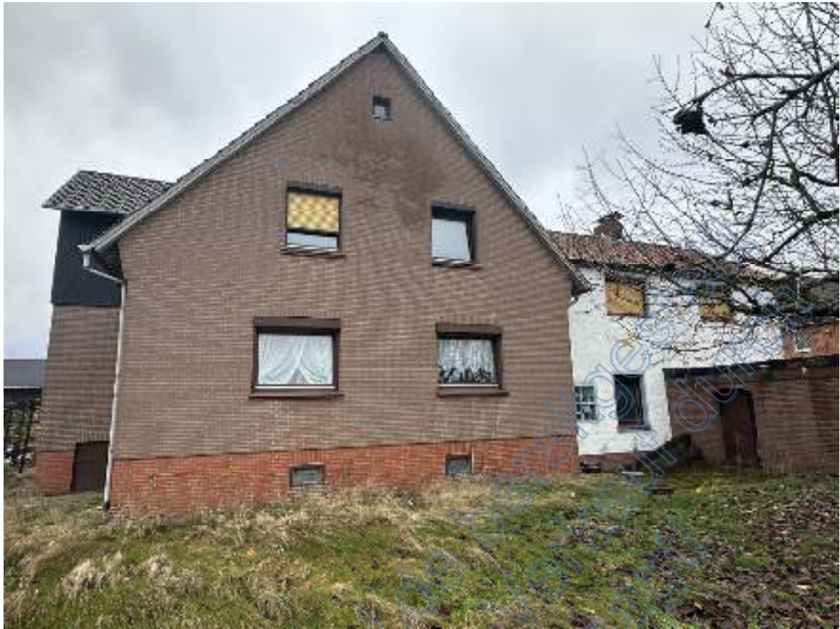
Bild 09: Blick vom südlichen Grundstücksbereich auf die südliche Giebelseite des Wohnhauses und die ("weiße") südliche Traufseite des Wohnhausanbaus . Ganz rechts schließt sich die Rückseite der Zwischenüberdachung an.
