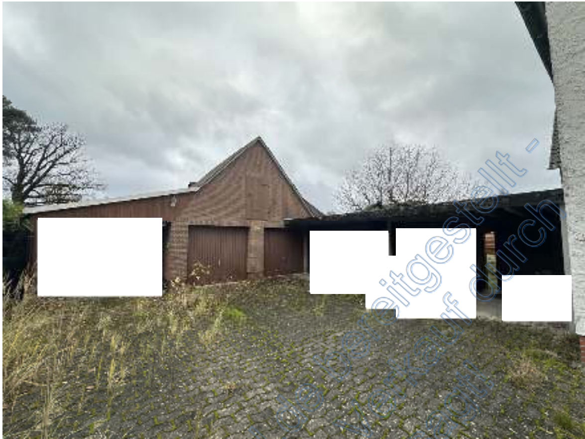
Bild 11: Blick von und über die östliche Hoffläche auf die Nordseite der Doppelgarage. Links schließt sich der Carport, rechts die Zwischenüberdachung an.
