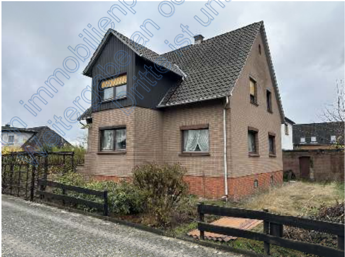
Bild 06: Blick vom „Wegerecht“ auf die westliche Traufseite (mit Giebelvorbau) sowie die sich rechts anschließende südliche Giebelseite des Wohnhauses des Bewertungsflurstücks 55/35.
