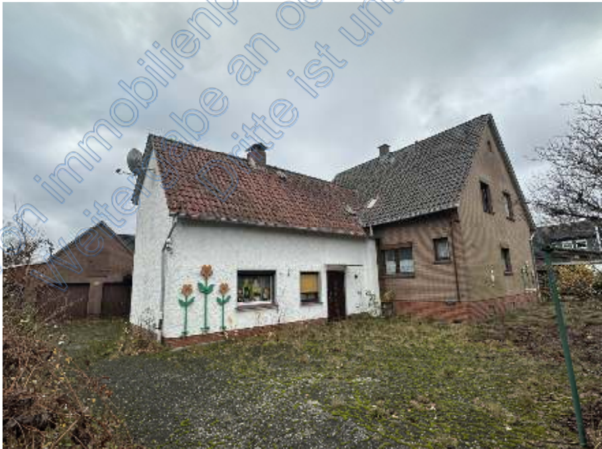
Bild 16: Blick von der Hoffläche auf die östliche Giebel- und die nördliche Traufseite ( Eingangsseite ) des Wohnhausanbaus . Rechts ist die kurze östliche Traufseite und die nördliche Giebelseite des
