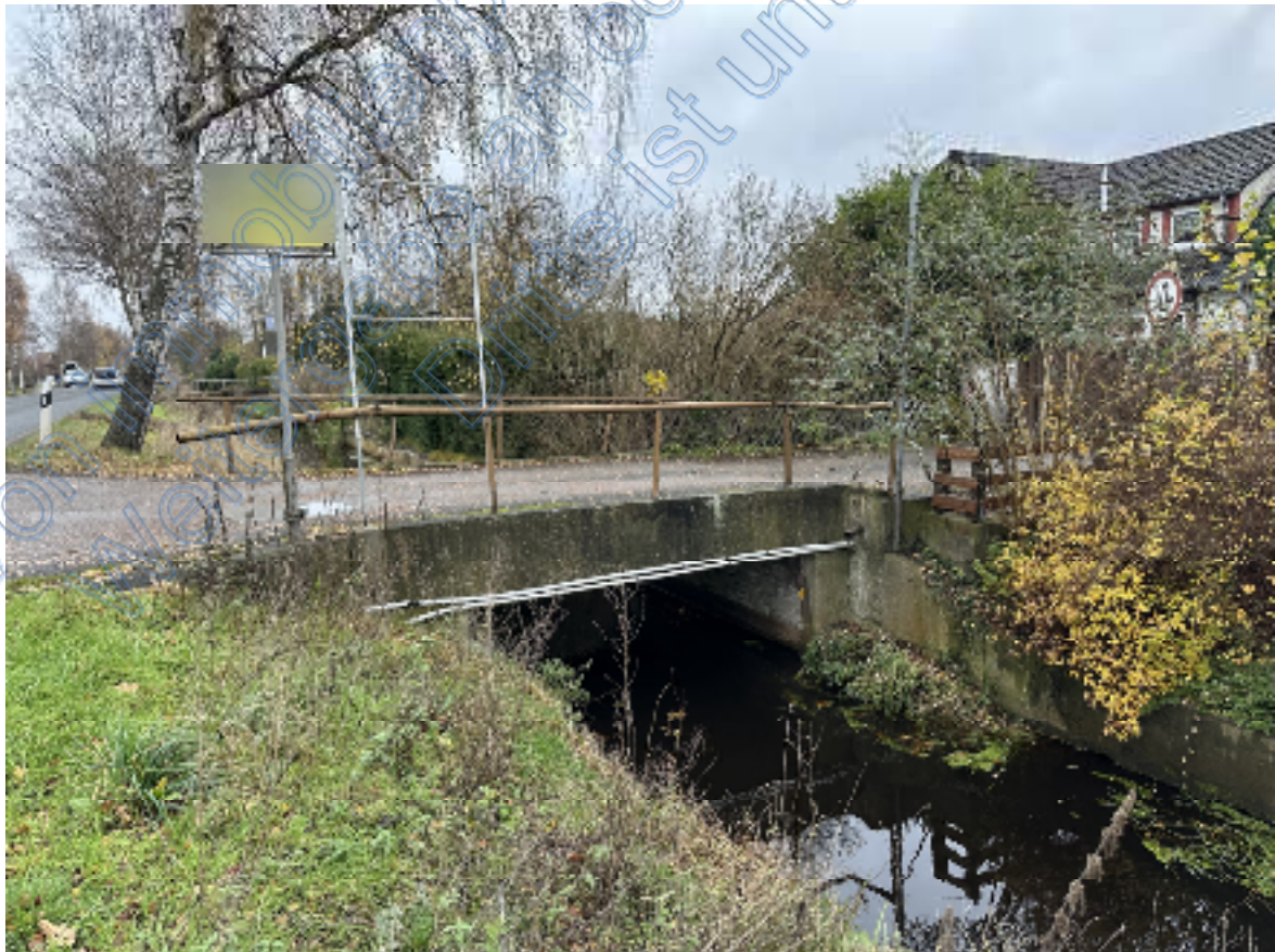
Bild 02: Blick auf das „Grabenflurstück“ bzw. Bewertungsflurstück 66/22. Darüber ist die Brücke bzw. die Zufahrt zum Bewertungsflurstück 55/35 führenden Stichweg zu sehen.
