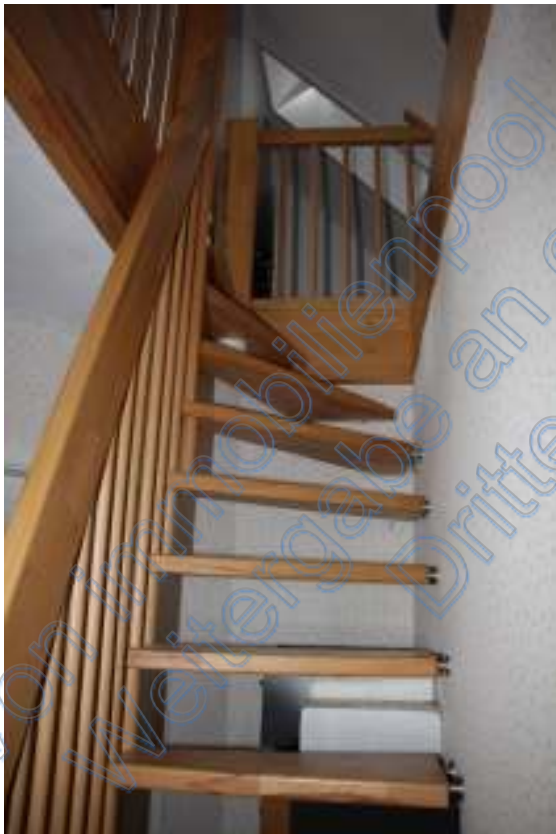
11 Treppe zum Spitzboden
