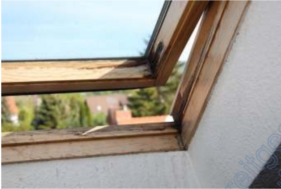
14 Detail Dachflächenfenster schadhaft
