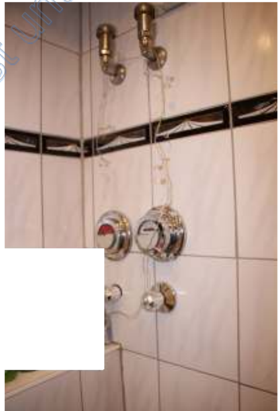
10 Kalt- und Warmwasserzähler
