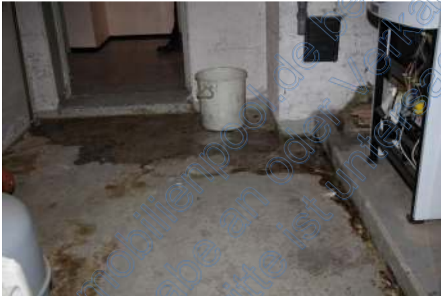
18 Wasseraustritt im Bereich der Heizungsanlagen
