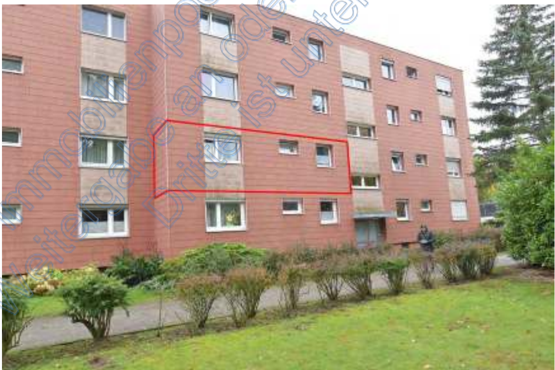
Ostfassade mit Hauseingang, die Lage der Eigentumswohnung ist farbige gekennzeichnet
