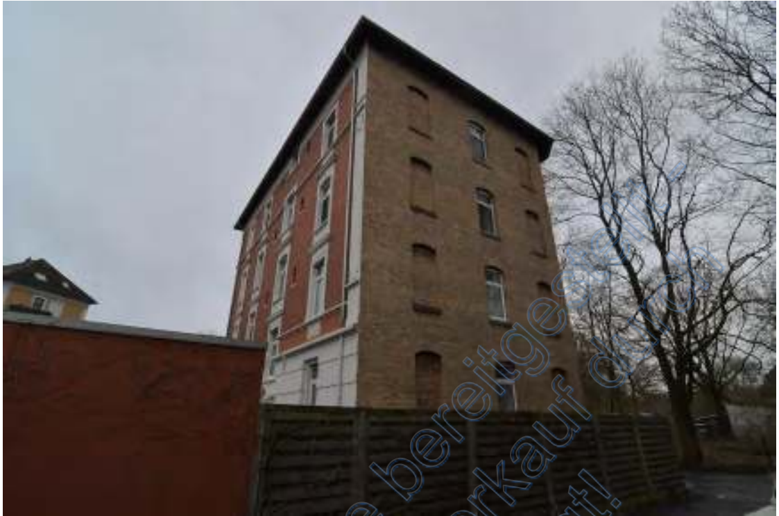
Ostfassade und Südfassade
