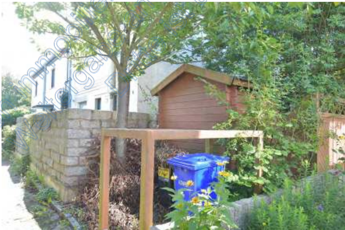
Ansicht von Nordwest
