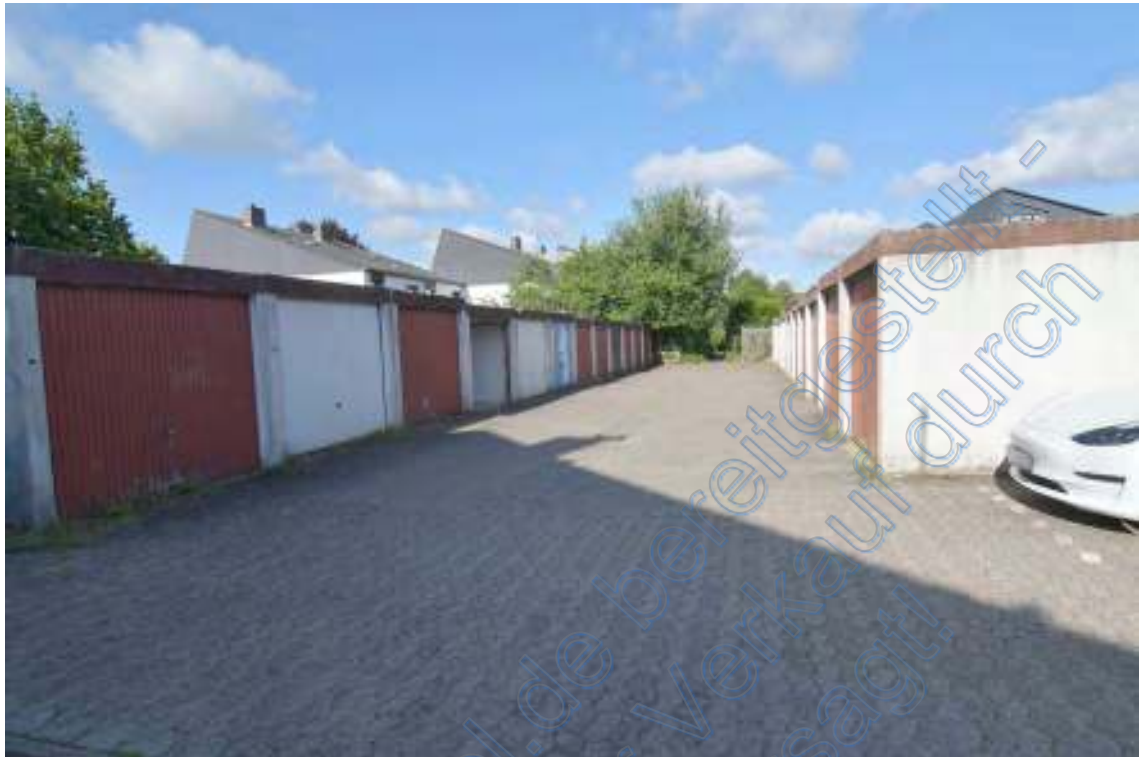
Zufahrt zum Garagenhof
