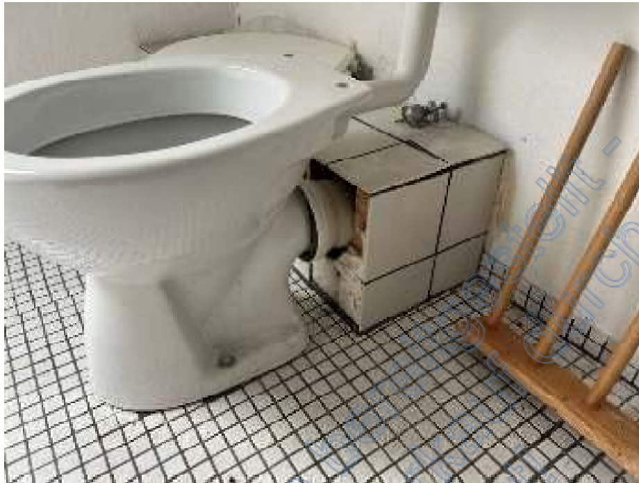
Foto 20: Wohn- und Wirtschaftsgebäude, Sanitärinstallationen im Dachgeschoss aufgenommen am 06.12.2024
