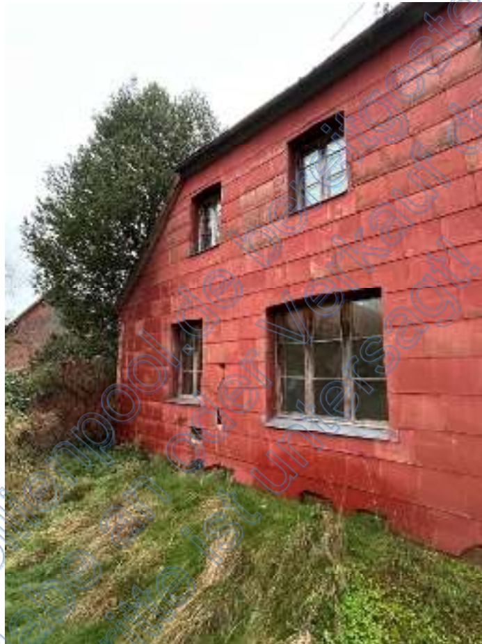
Foto 5: Wohn- und Wirtschaftsgebäude, Westseite, Südwestansicht aufgenommen am 06.12.2024
