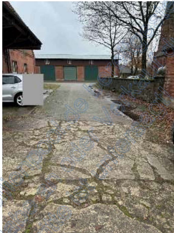
Foto 27: Zuwegung (Flurstück 63/3), Ostansicht aufgenommen am 06.12.2024
