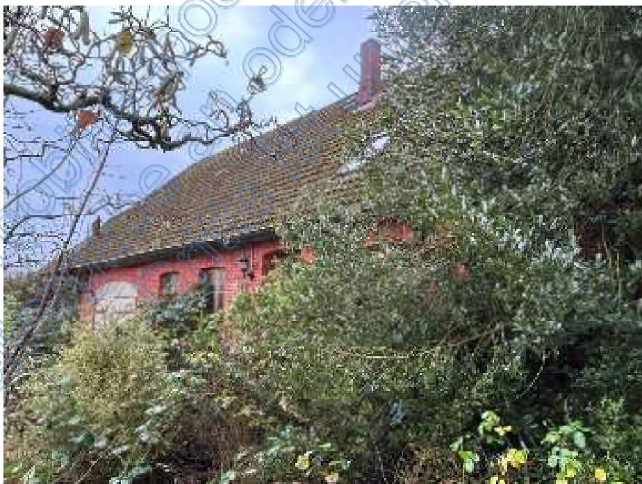
Foto 4: Wohn- und Wirtschaftsgebäude, Nordseite, Nordwestansicht aufgenommen am 06.12.2024
