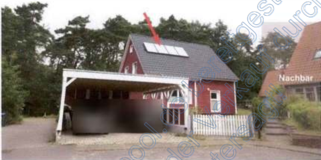
Foto 1, Straßensicht Einfamilienhaus (Geb. 1) und Doppelcarport (Geb. 3), Pfeil weist zu den Solarkollektoren der Solarthermieanlage, Südansicht
