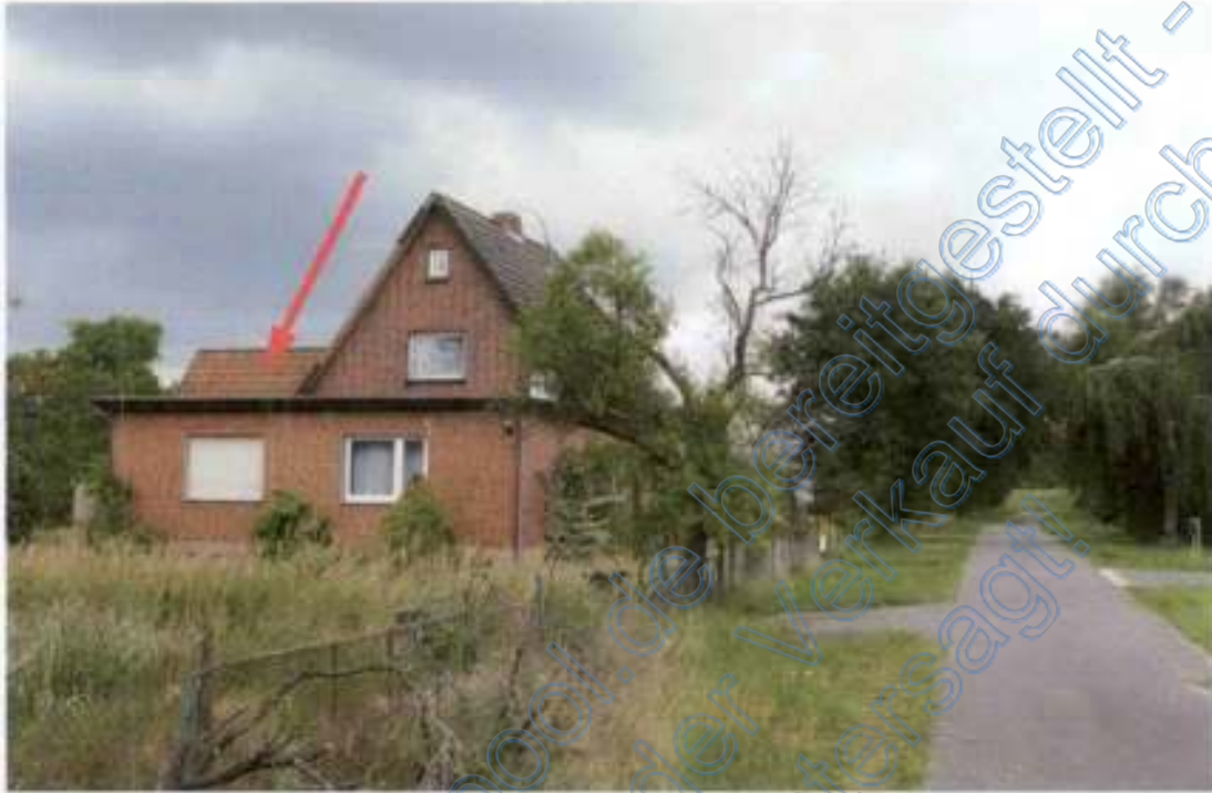
Foto 1, Straße Op'n Barweg, Blick nach Nordosten, links im Bild Grundstück mit Einfamilienhaus mit Erweiterungsbau (Flachdach) im Hintergrund Anbau/Stallanbau (Pfeil), Südansicht
