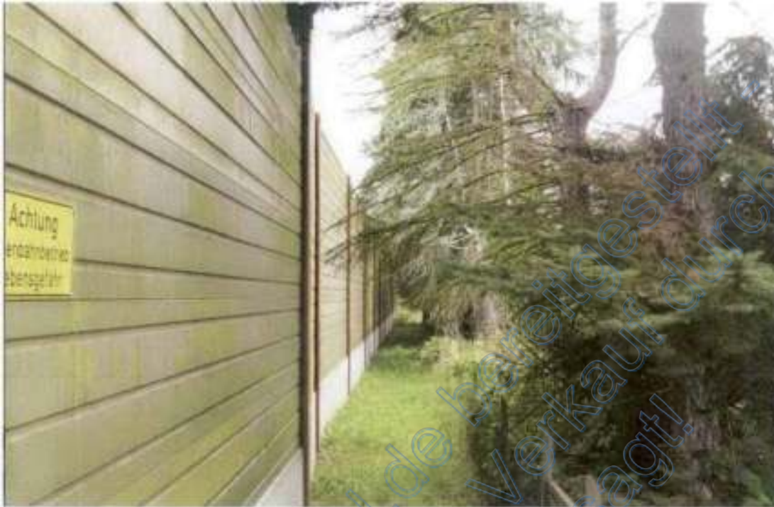
Foto 7, Schallschutzwand längs der Fernbahnstrecke Lüneburg-Hamburg, Südostansicht
