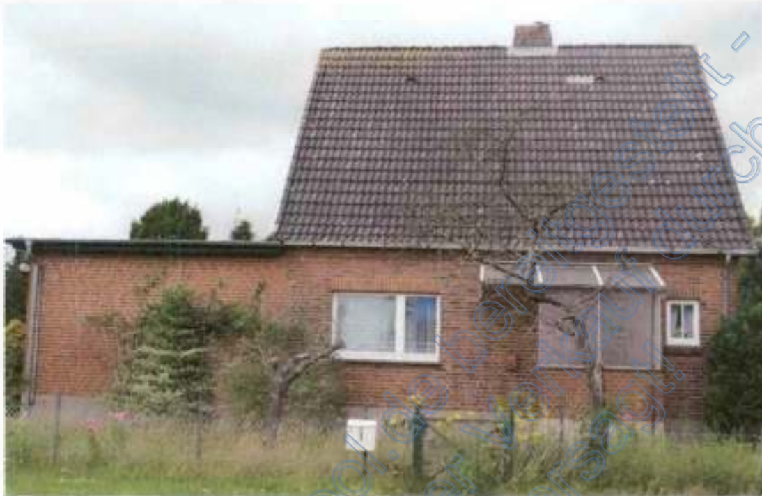
Foto 3, Straßenansicht, Einfamilienhaus mit Erweiterungsbau, Hauseingangstreppe mit Überdachung, Ostansicht
