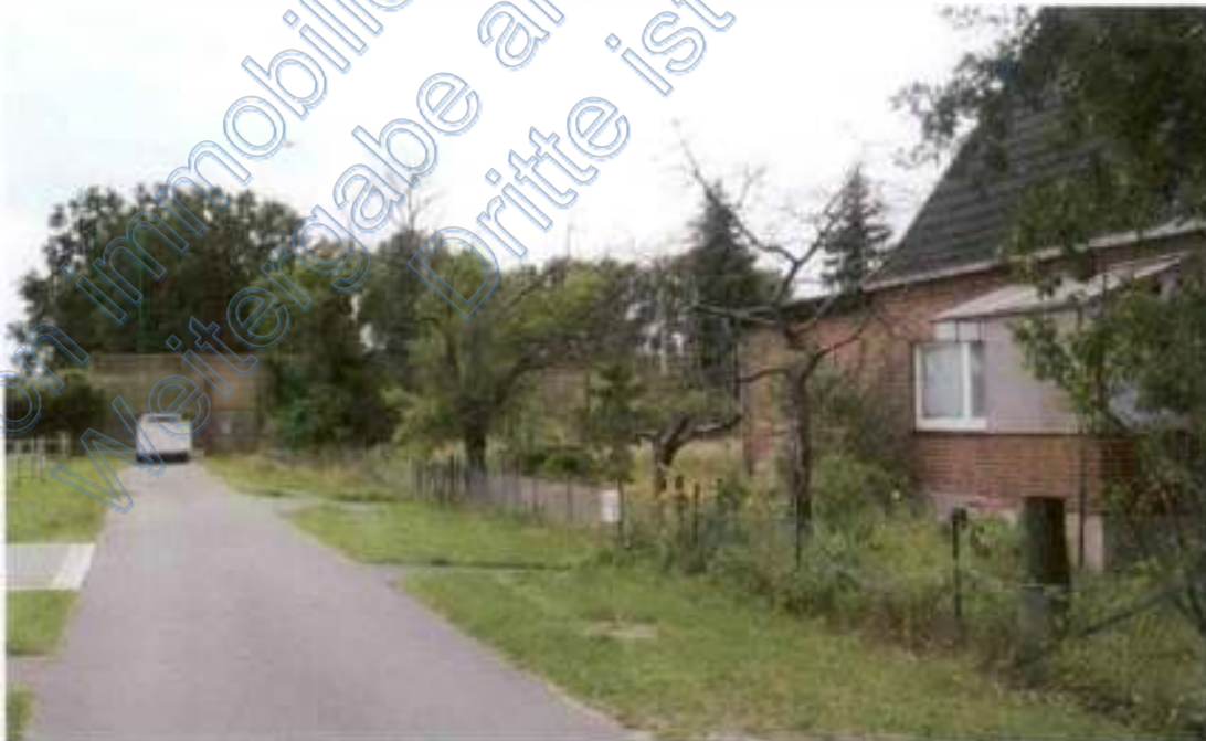
Foto 2, Straße Op'n Barweg, Blick nach Südwesten, rechts im Bild Grundstück mit Einfamilienhaus, Nordansicht
