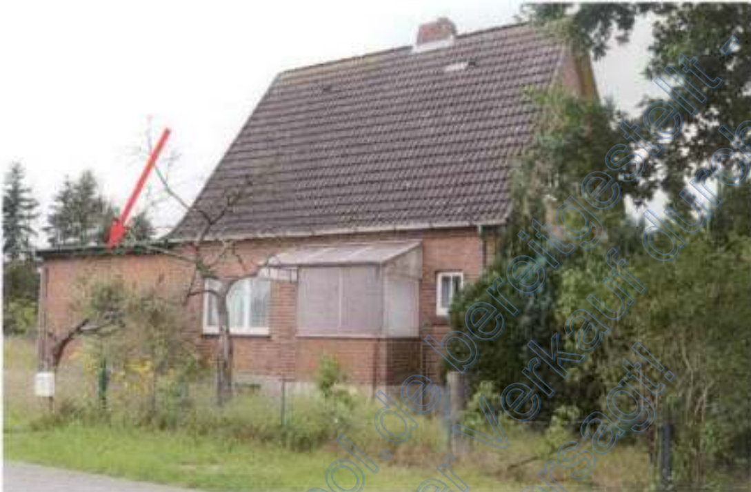
Foto 5, Straßenansicht, Einfamilienhaus mit Erweiterungsbau (Pfeil), Hauseingangstreppe mit Überdachung, Nordostansicht
