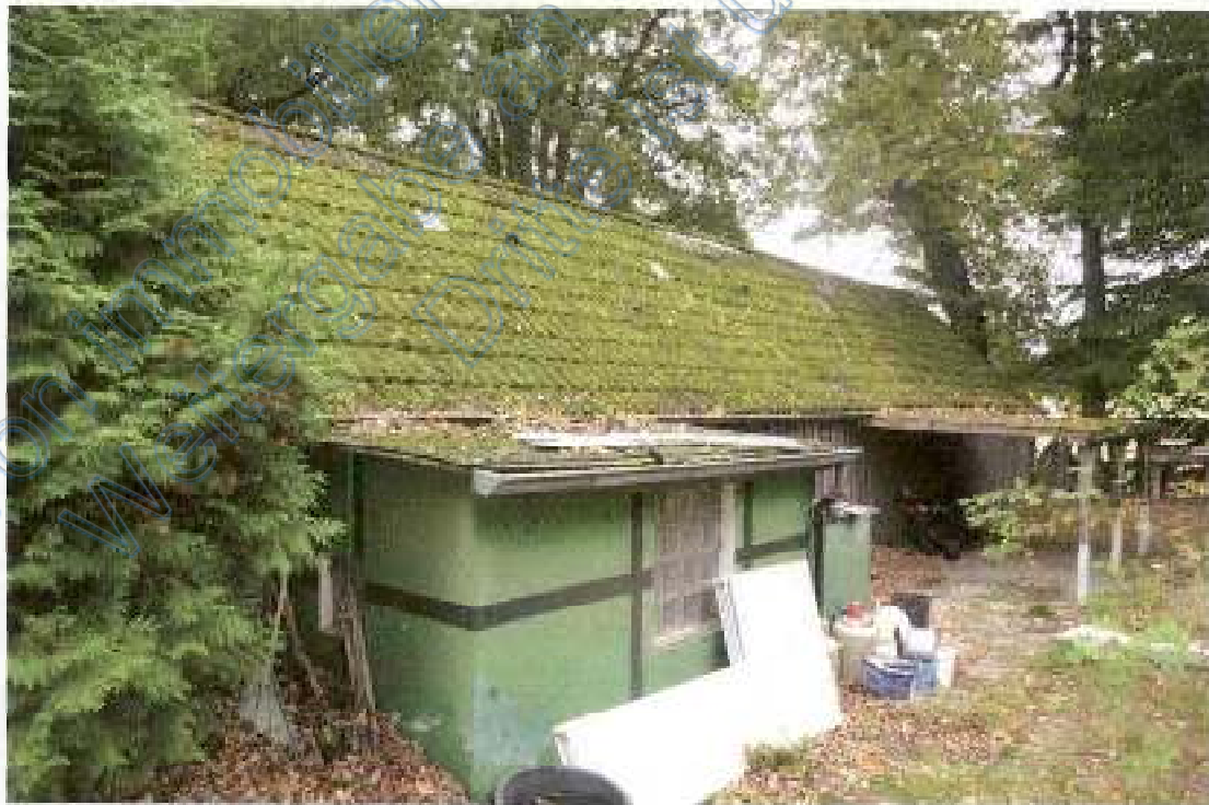
Foto 10, Blick zum Nebengebäude (Geb. 2), Nordostansicht
