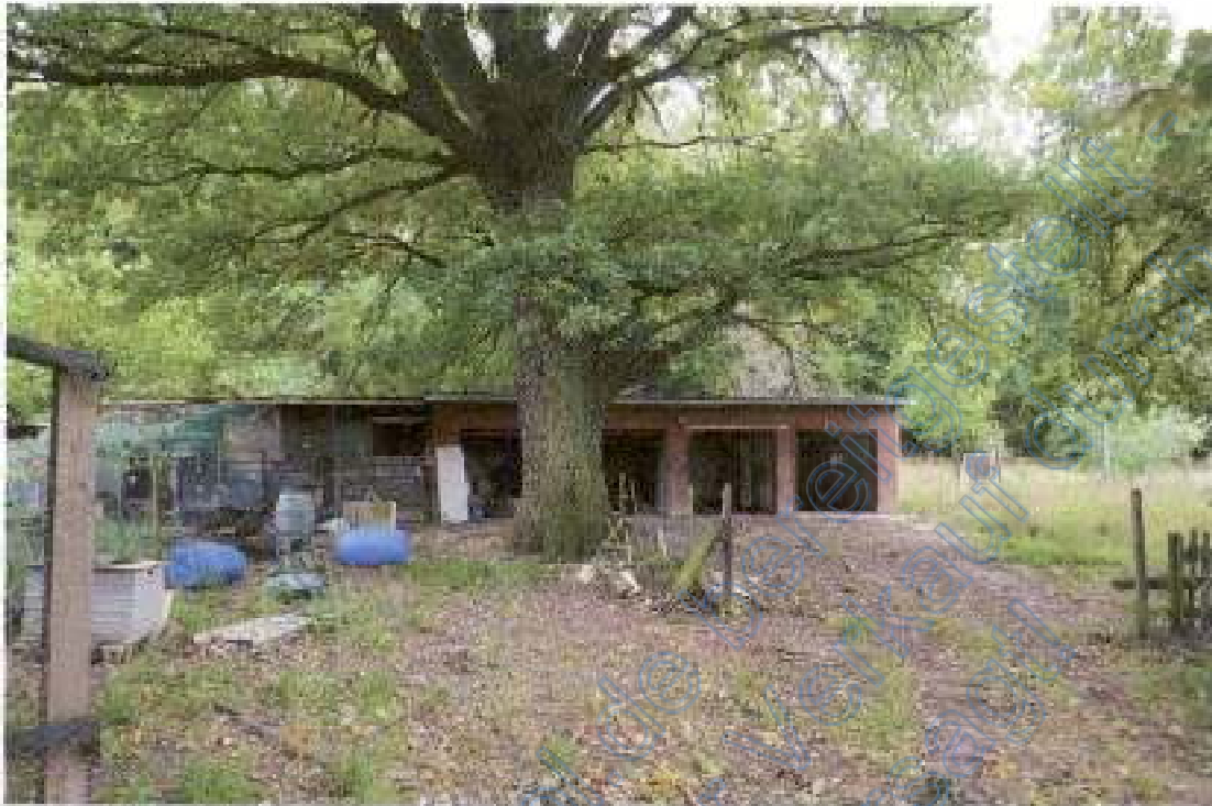
Foto 15, Blick zur Reihengarage (Geb. 3) mit vier Garagen, Nordwestansicht
