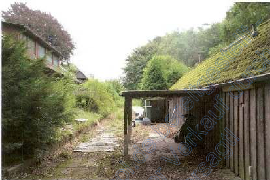
Foto 11, links im Bild Wohnhaus, Dreifamilienhaus (Geb. 1), rechts im Bild Nebengebäude (Geb. 2), Westansicht
