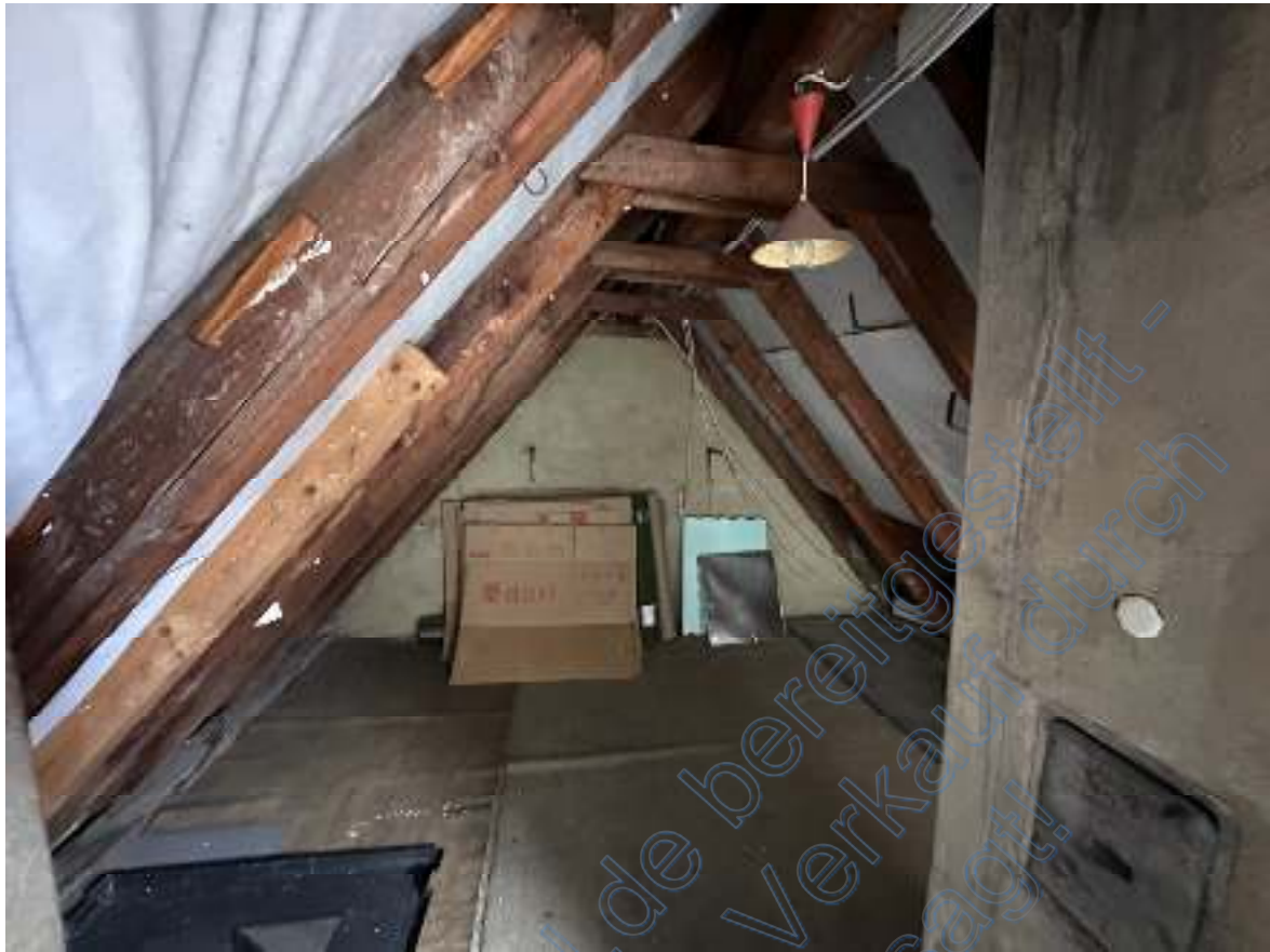
Bild 35: Ausschnitt – Spitzbodenraum Richtung Giebel zur nördlichen Doppelhaushälfte (südliche Doppelhaushälfte Wohnung 2 SBG ).
