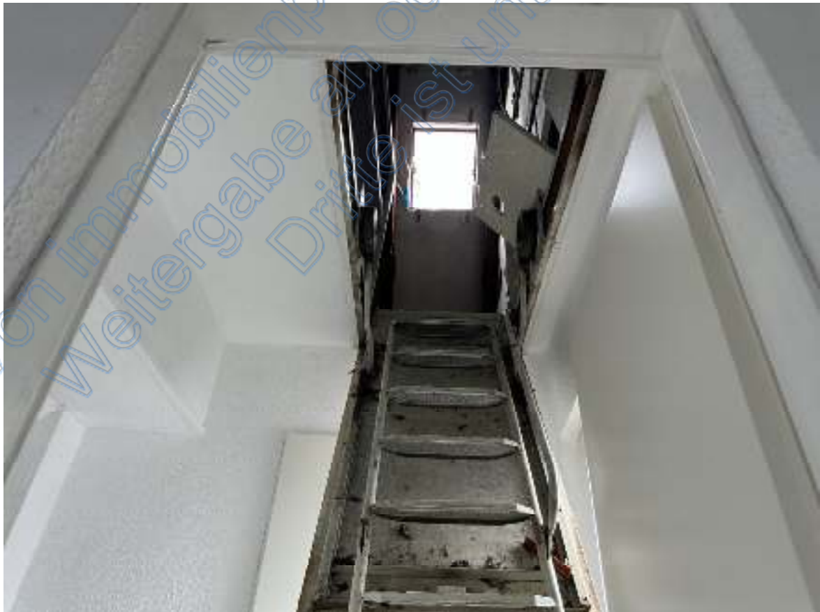
Bild 34: Ausschnitt – Einschubtreppe Richtung Spitzbodenraum (südliche Doppelhaushälfte Wohnung 2 DG Richtung SBG).
