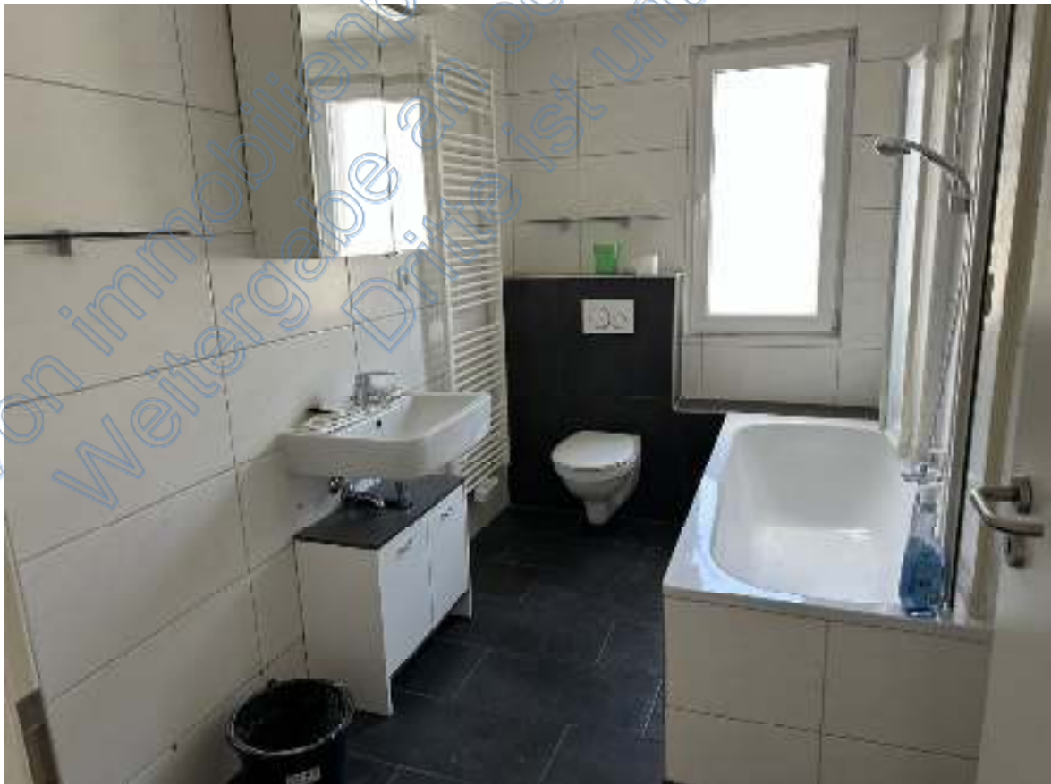
Bild 28: Ausschnitt – Bad (südliche Doppelhaushälfte Wohnung 2 OG).
