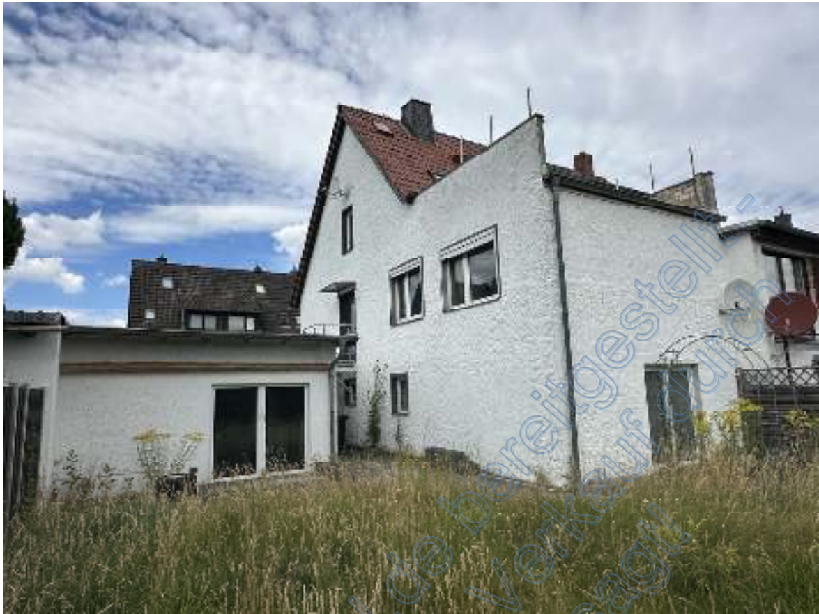
Bild 09: Blick aus der südöstlichen Ecke des Bewertungsflurstücks 76/48 auf die Ostseite des (zu „Wohnzwecken“ ausgebauten) Garagengebäudes (links) sowie die südliche Giebel- & Traufseite (mittig) und die östliche Traufseite (rechts) der südlichen Doppelhaushälfte .
