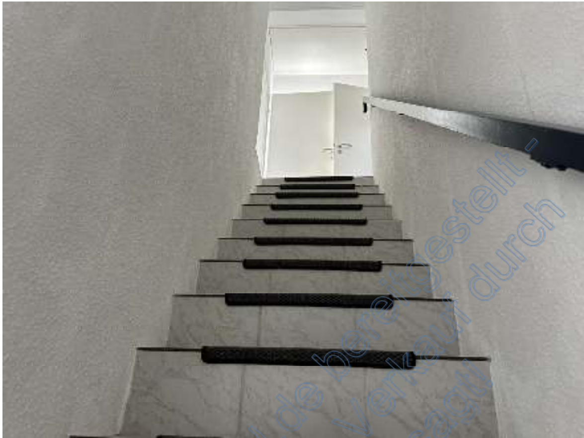
Bild 29: Ausschnitt – Treppe Richtung Flur im Dachgeschoss (südliche Doppelhaushälfte Wohnung 2 OG Richtung DG).
