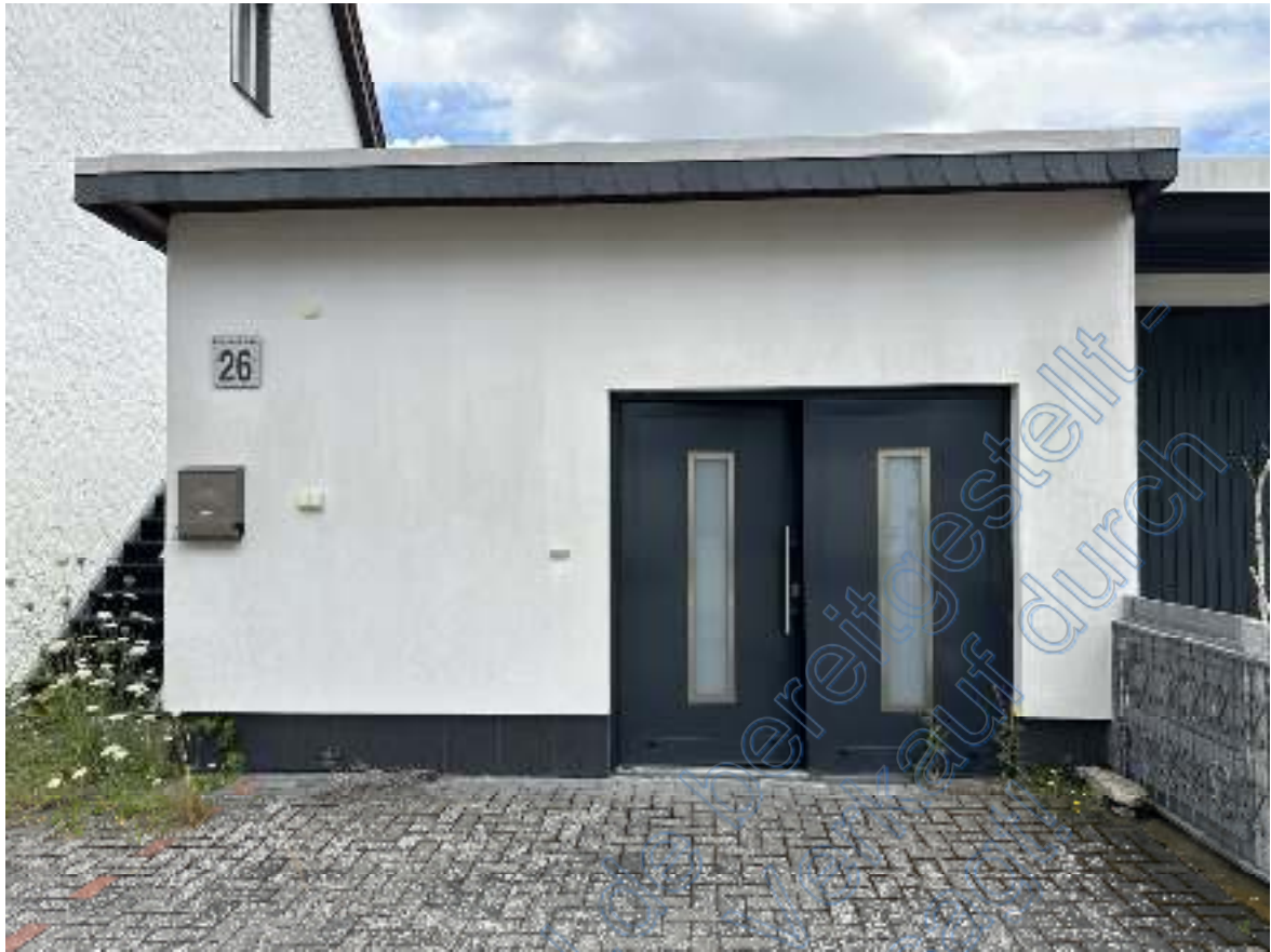
Bild 03: Blick von der südwestlichen Stellplatzfläche des Bewertungsflurstücks 76/48 auf die Westseite (mit leicht geöffneter Eingangstür) des (zu „Wohnzwecken“ ausgebauten) Garagengebäudes.
