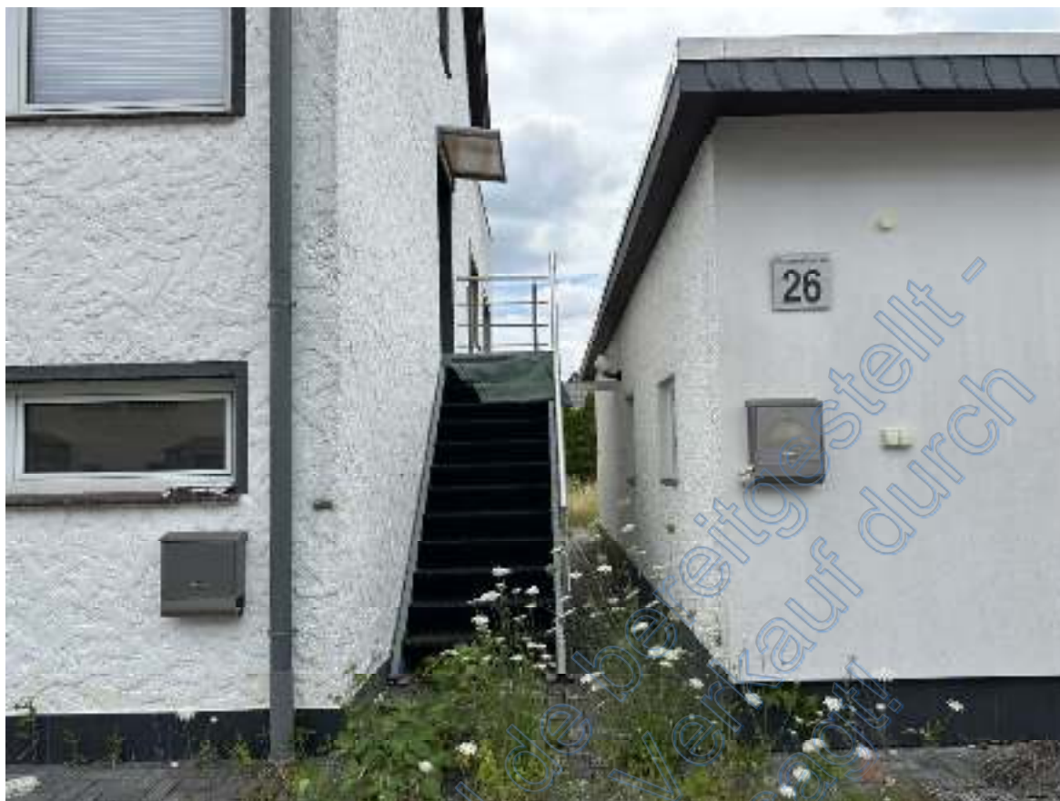
Bild 19: Blick in den Gang mit der Zugangstreppe zur Wohnung 2 im Ober- & Dachgeschoss der südlichen Doppelhaushälfte (links).
