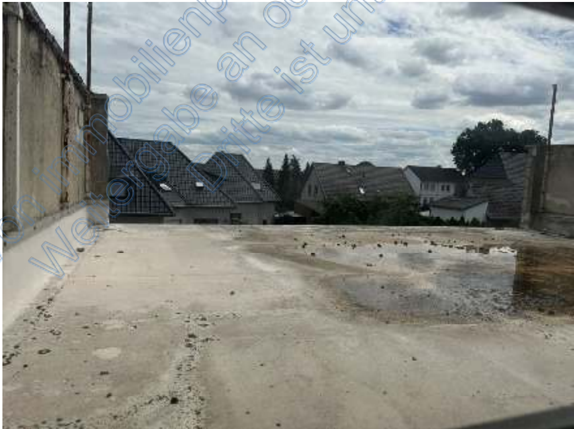
Bild 32: Ausschnitt – „unfertiger“ Balkon (südliche Doppelhaushälfte Wohnung 2 DG).
