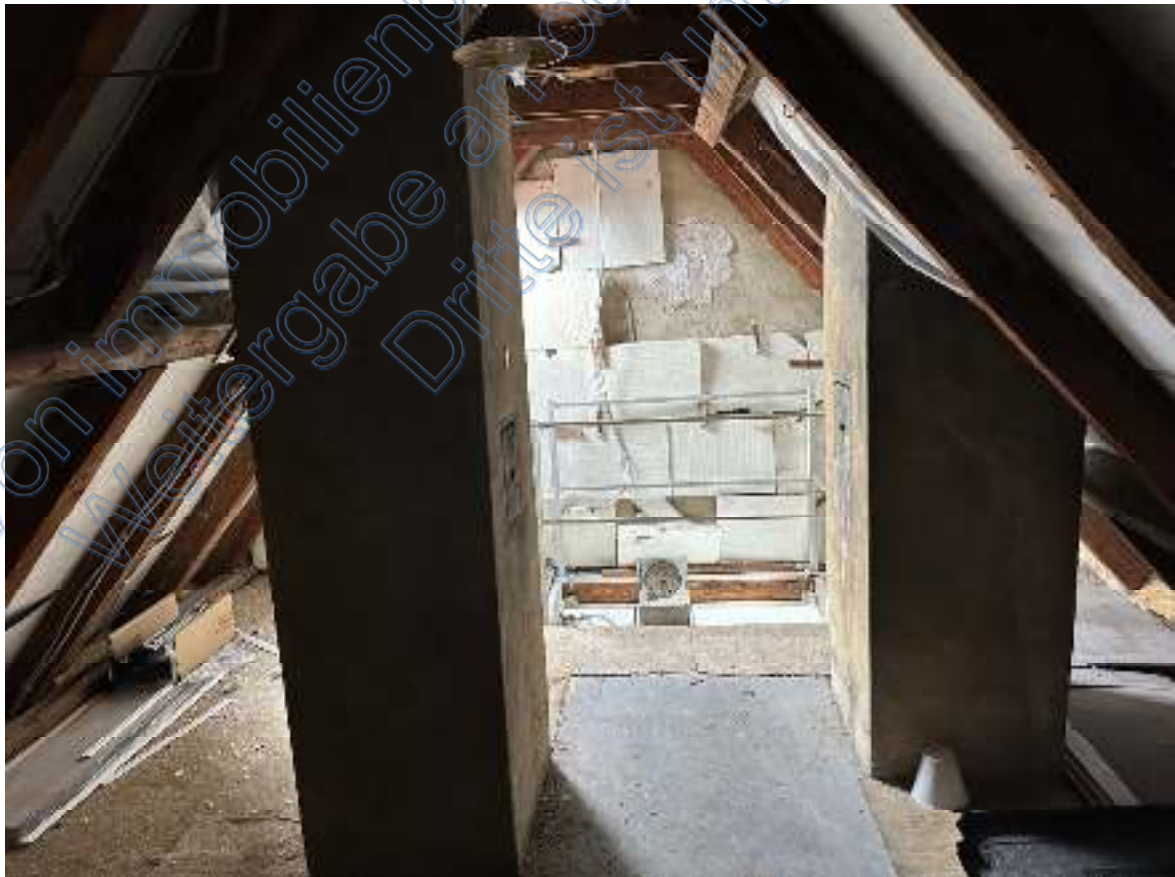
Bild 36: Ausschnitt – Spitzbodenraum Richtung Südgiebel (südliche Doppelhaushälfte Wohnung 2 SBG ).
