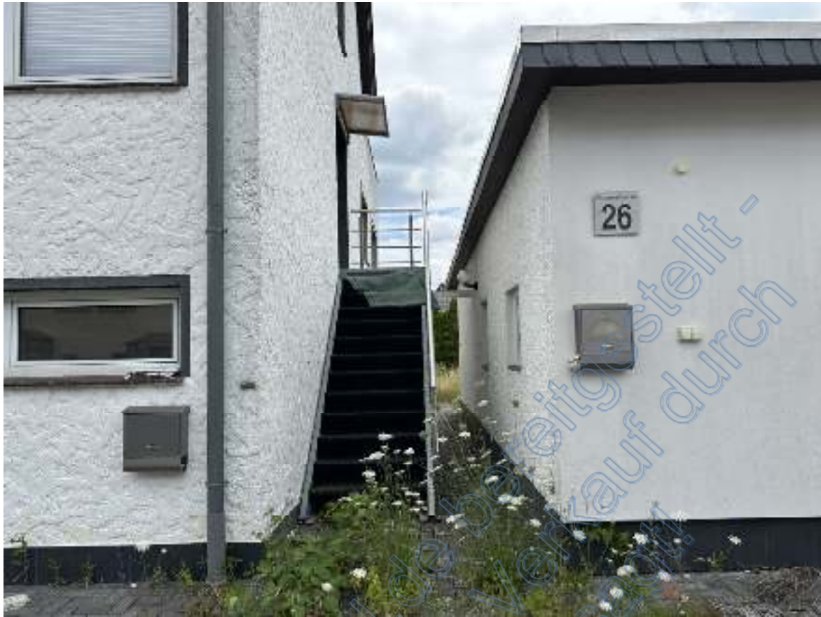
Bild 07: Blick in und durch den Gang zwischen der südlichen Doppelhaushälfte (links) und dem (zu „Wohnzwecken“ ausgebauten) Garagengebäude in Richtung der hinteren, östlichen Grundstücksfläche des Bewertungsflurstücks 76/48.
