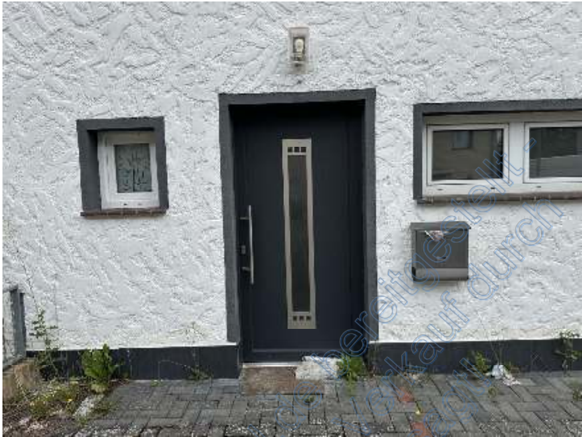
Bild 11: Blick von der nordwestlichen Stellplatzfläche des Bewertungsflurstücks 76/48 auf die geschlossene Wohnungseingangstür zur Wohnung 1 im Erdgeschoss der südlichen Doppelhaushälfte .
