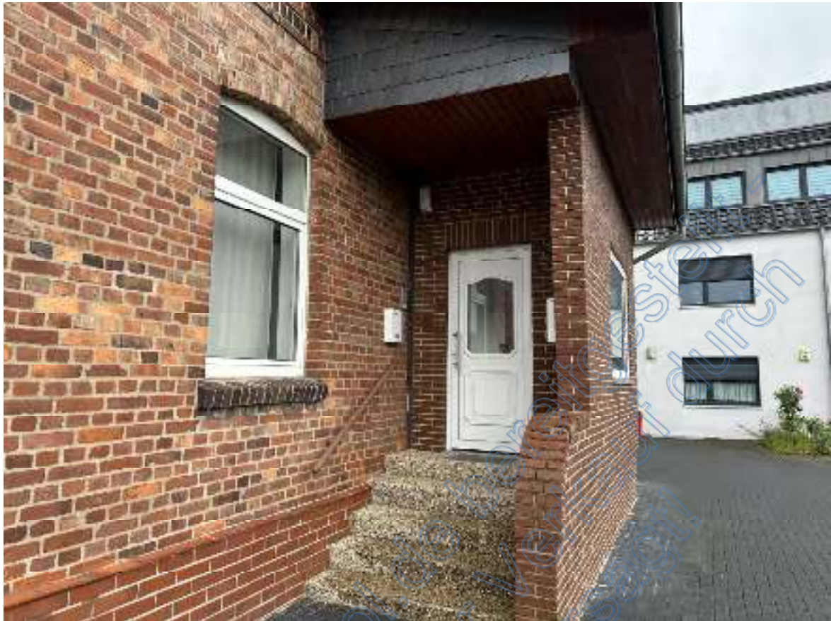
Bild 07: Blick über die Eingangstreppe auf die geschlossene Hauseingangstür zum Windfang im Eingangsvorbau des Wohnhauses mit drei Wohneinheiten.
