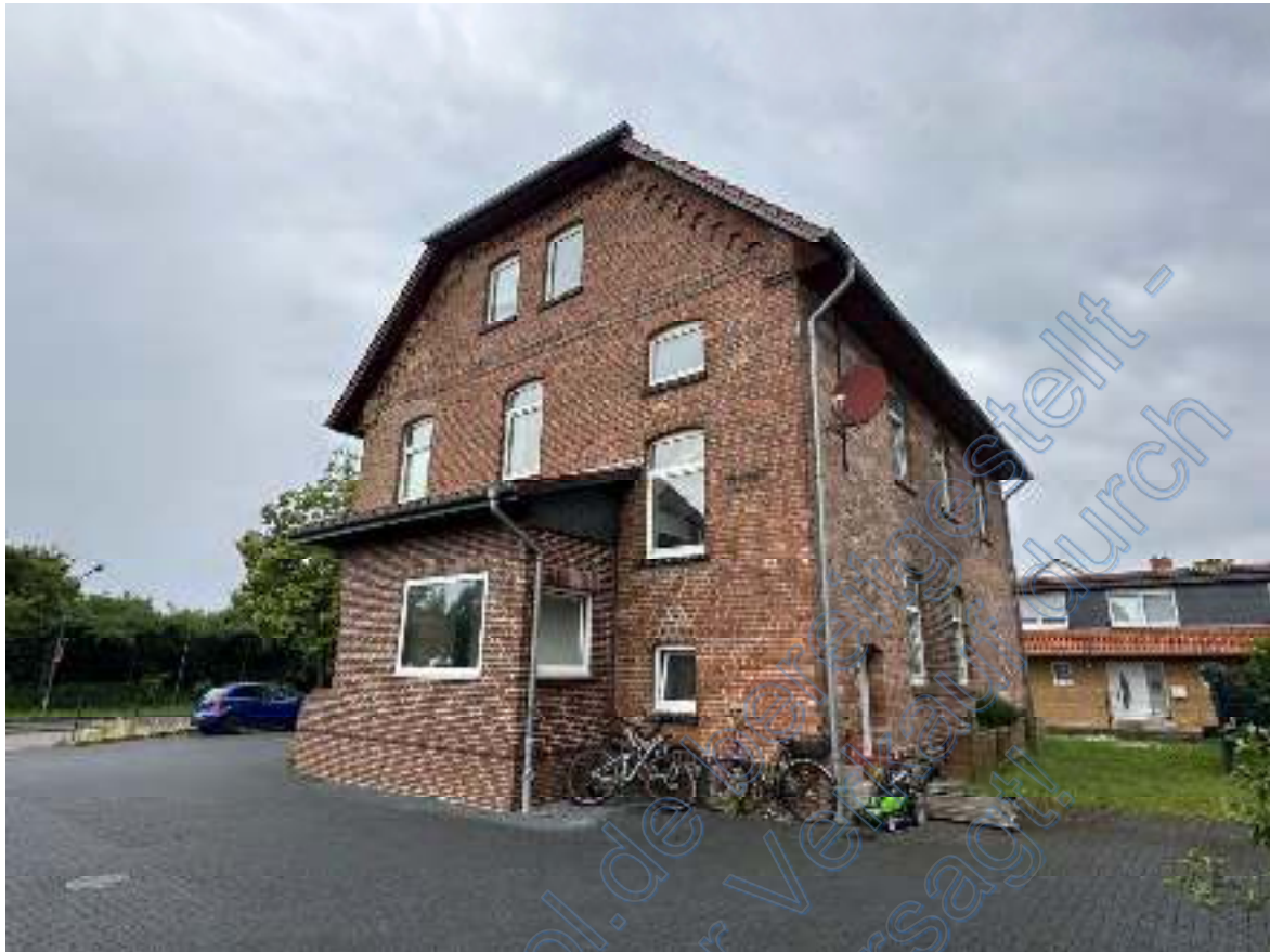
Bild 05: Blick auf die südliche Giebelseite (mit Eingangsvorbau) und die sich rechts anschließende östliche Traufseite des Wohnhauses. Die südliche Grundstücksgrenze des Flurstücks 113/477 verläuft 3 m vor der Giebelseite.
