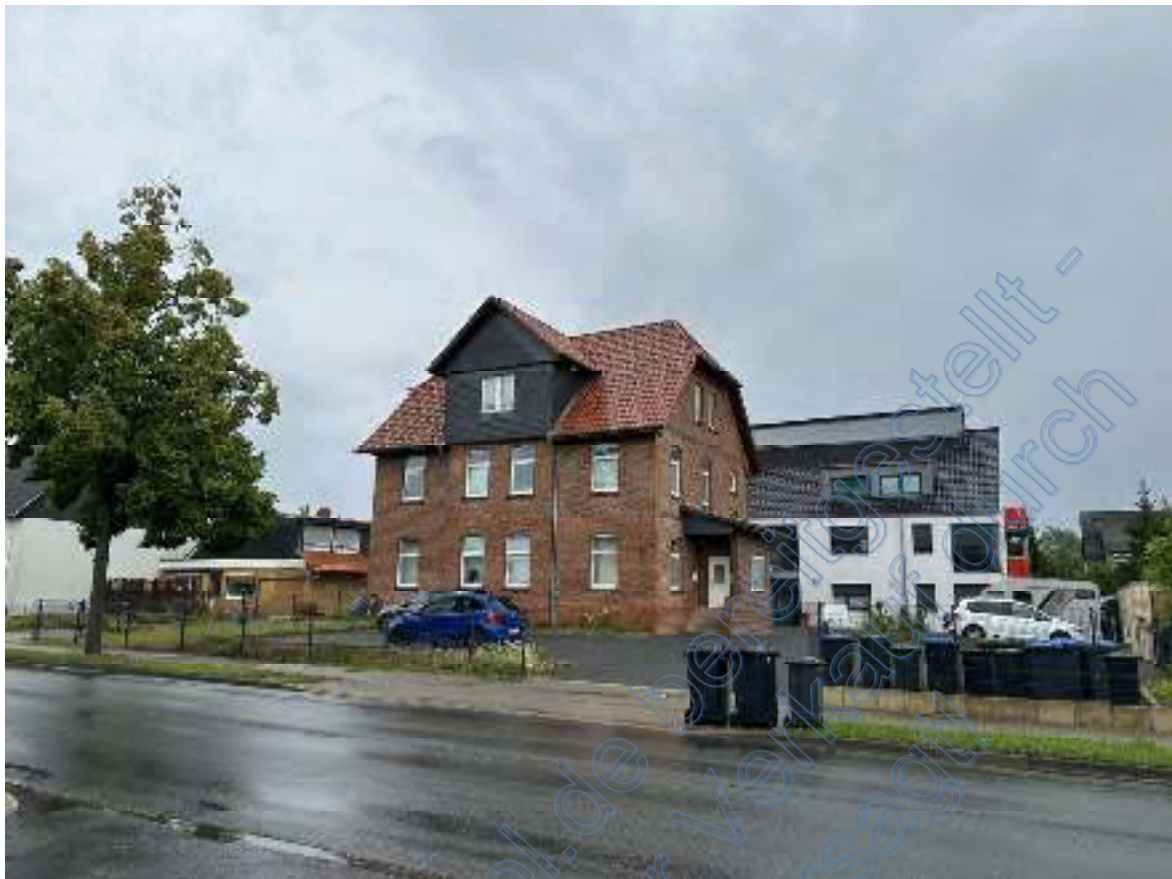
Bild 01: Blick über die Herzogin-Clara-Straße, durch die Zufahrt und über die „Hoffläche“ auf das Wohnhaus mit drei Wohneinheiten . Das Bewertungsobjekt, das Sondereigentum an der Wohnung Nr. 1 befindet sich im Erdgeschoss.
