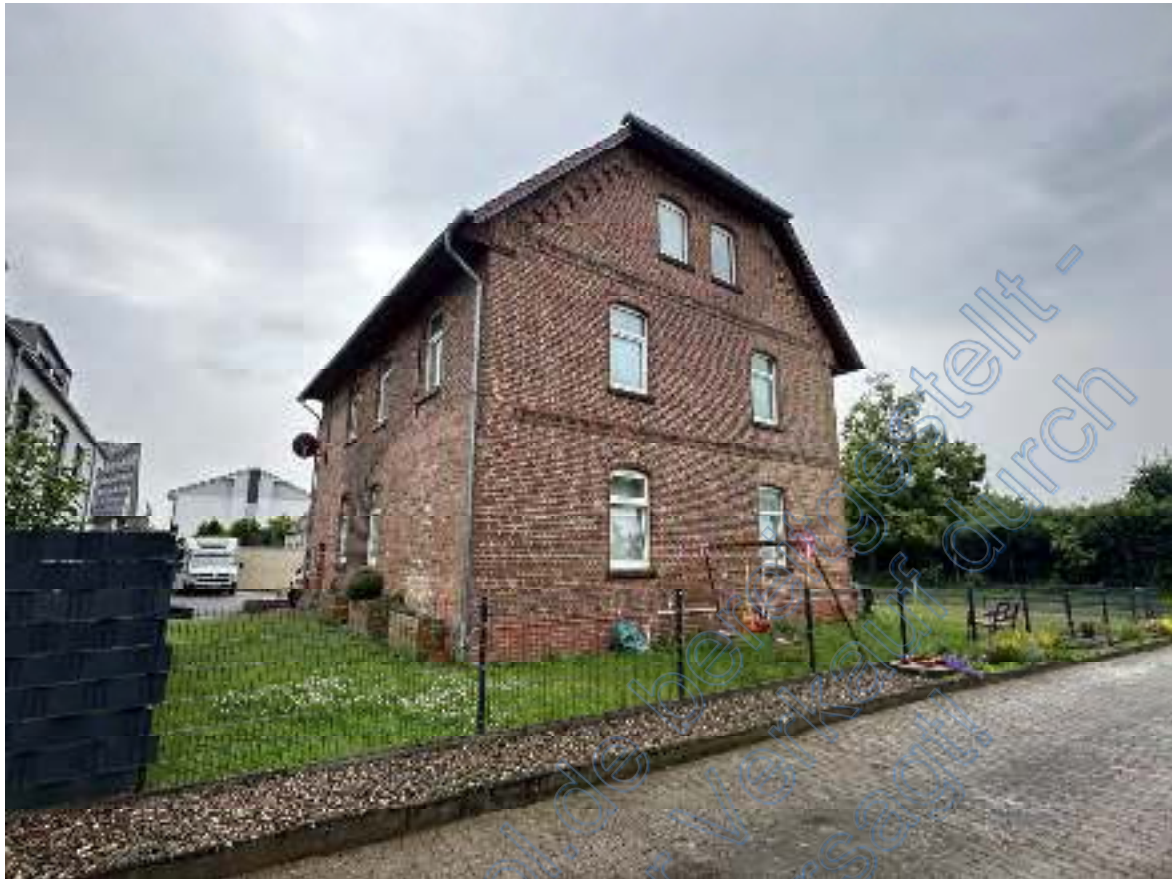
Bild 03: Blick vom Nachbarflurstück 113/436 über die nördliche Grundstücksgrenze (mit Stabmattenzaun) auf die nördliche Giebelseite des Wohnhauses . Im Erdgeschoss sind von rechts ein Wohn- und das Schlafzimmerfenster der Wohnung Nr. 1 zu sehen. Links schließt sich die östliche Traufseite an.
