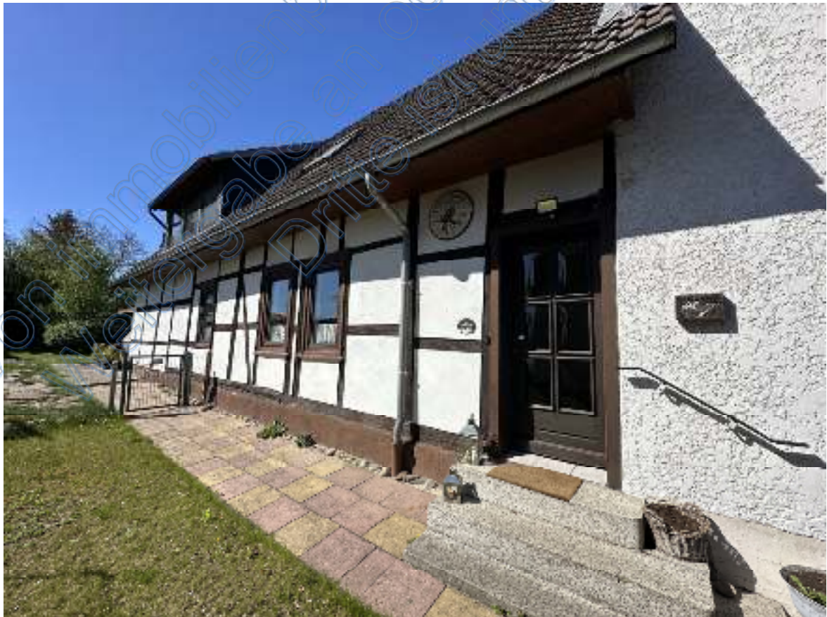
Bild 08: Blick auf die Ostseite des Hinterhauses . Rechts ist die geschlossene Hauseingangstür zu sehen.
