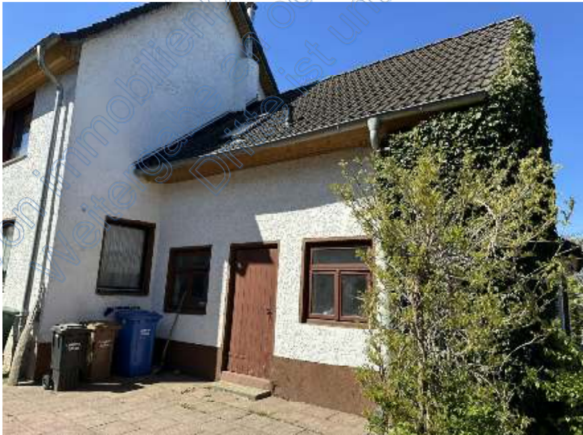
Bild 06: Blick auf die Ostseite des Vorderhauses und die Nordseite des Mittelhauses (links).
