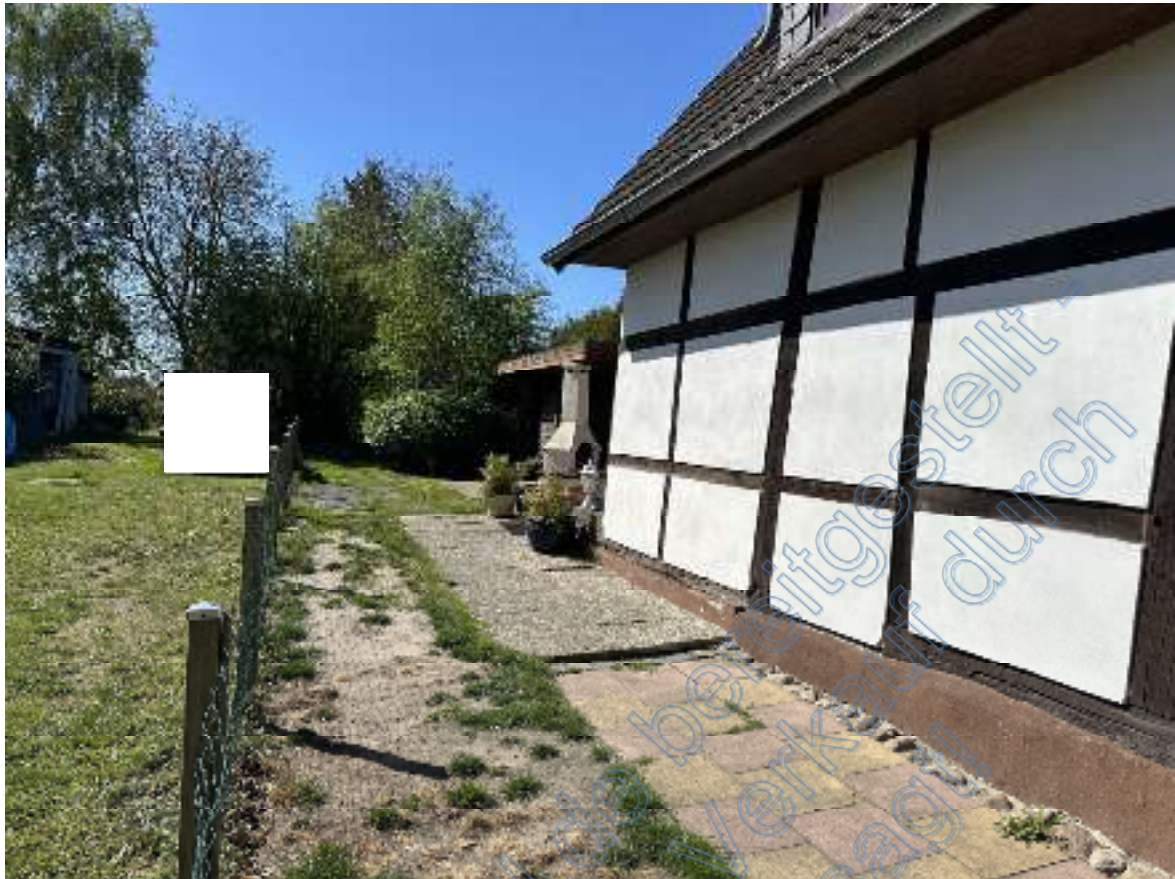
Bild 09: Blick über die Südgrenze des Bewertungsflurstücks 108 „an der“ Südostecke des Hinterhauses in Richtung des Bewertungsflurstücks 109.
