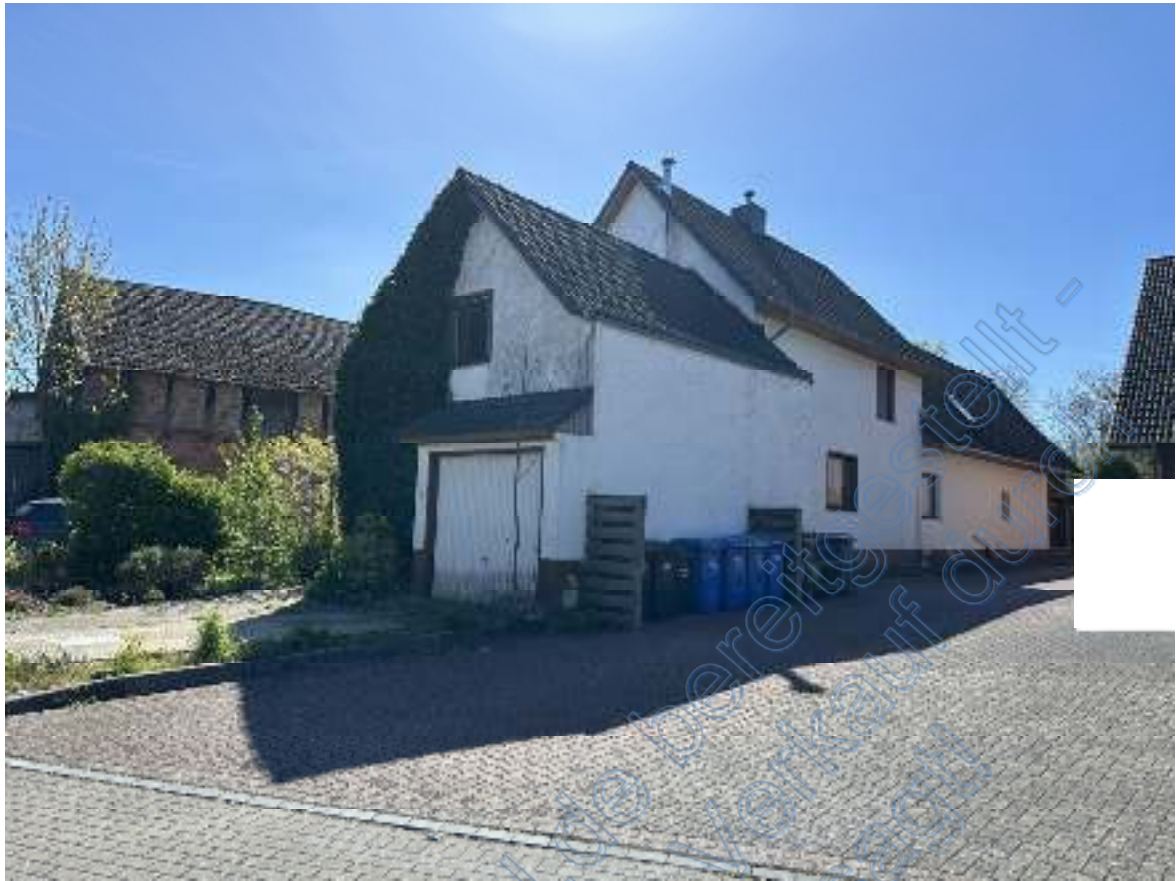
Bild 03: Blick über das nachbarliche Wegefurstück 112/3 auf die Nordseite (mit geschlossenem Garagentor) und die Westseite (mit angestellten Mülltonnen) des Vorderhauses sowie die Westseiten des sich anschließenden Mittelhauses und des Hinterhauses des Bewertungsobjektes.
