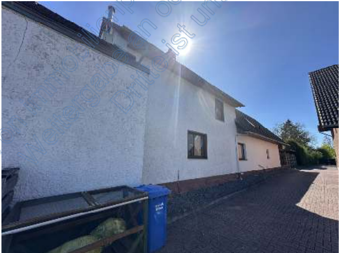
Bild 04: Blick auf die Westseiten des Vorderhauses (links), des Mittelhauses und des Hinterhauses .
