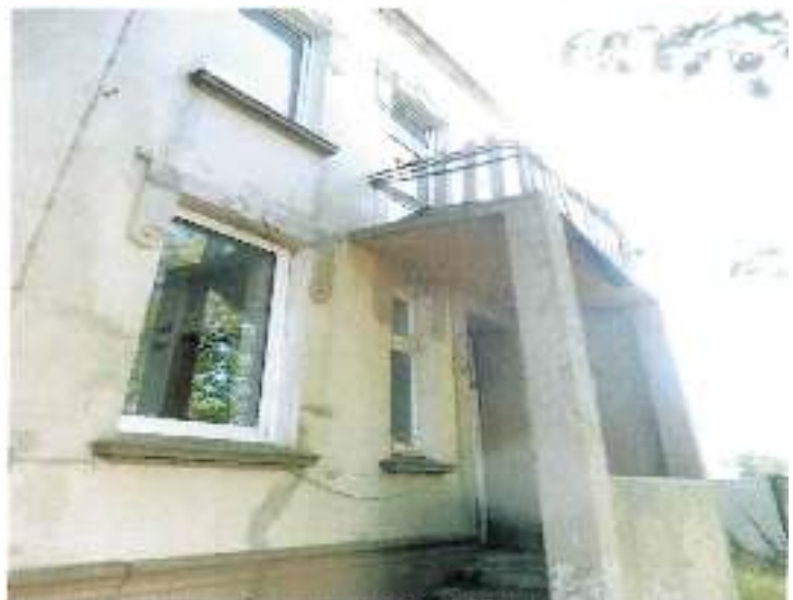
Ansicht Westseite mit dem Hauseingang
