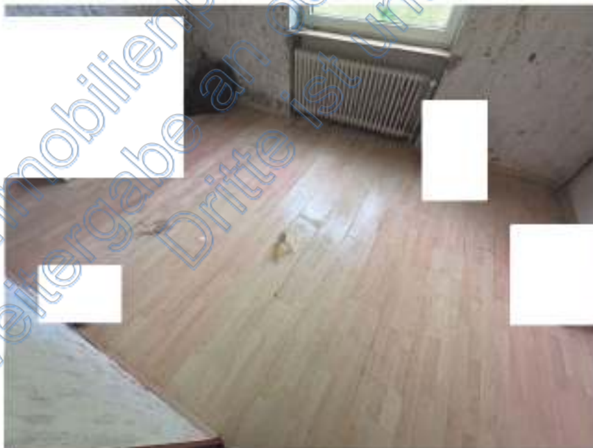
Bild 6: Zimmer EG, aufgeweichtes Laminat
