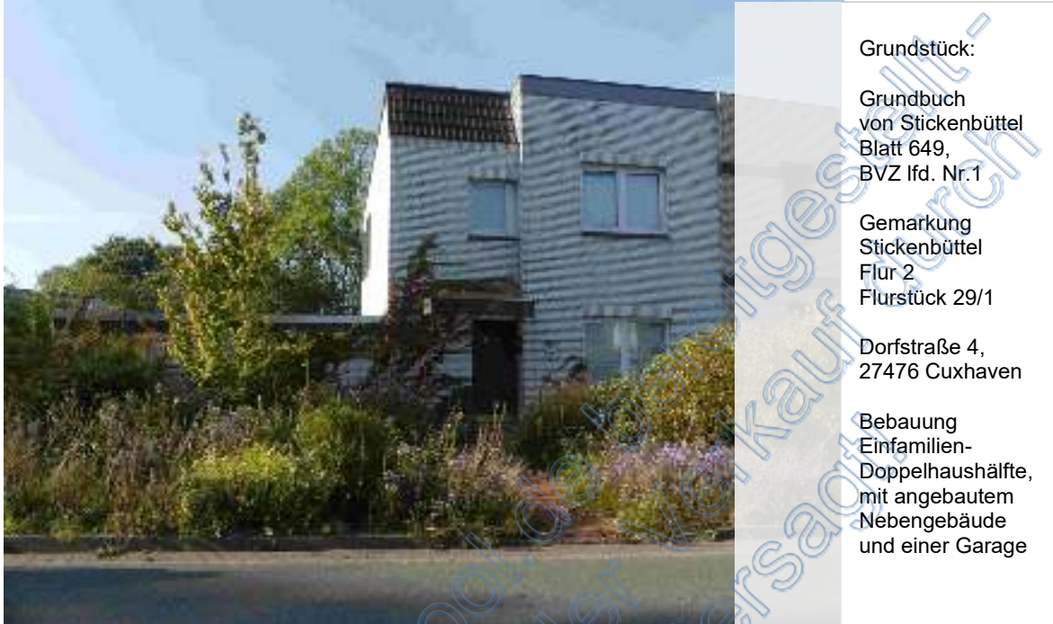
Südostansicht. Blick von der Straße auf das Wohngebäude mit Hauszugang
