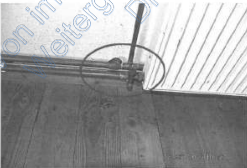
26 Frostschaden Heizungsrohr
