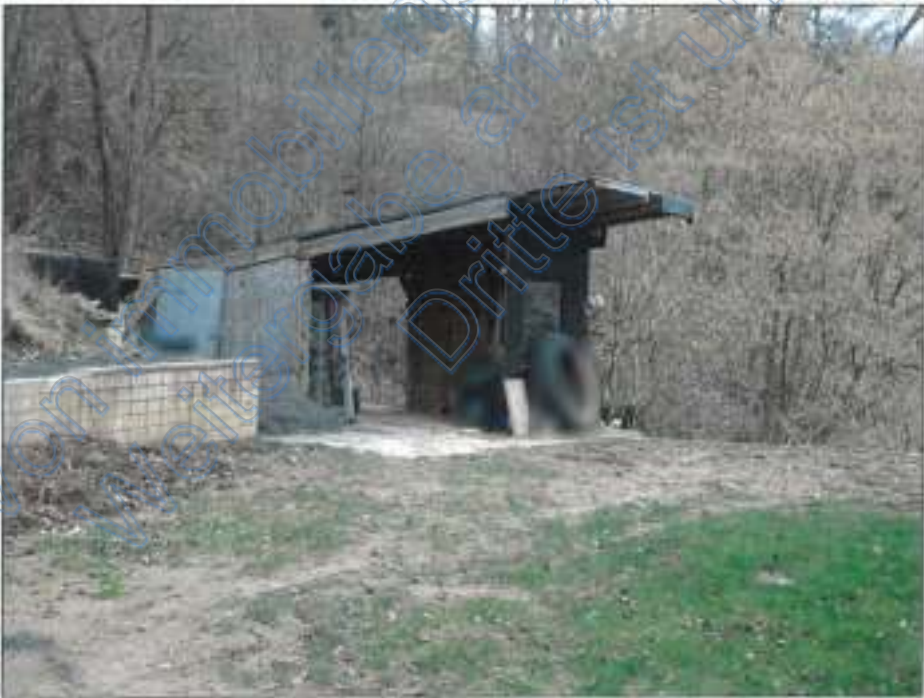
Bild 12 Schuppen für Holzlagerung
