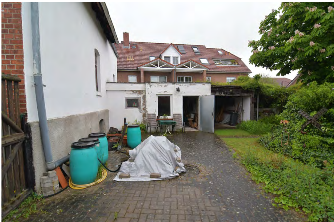
Rückwärtiger Anbau mit Garage
