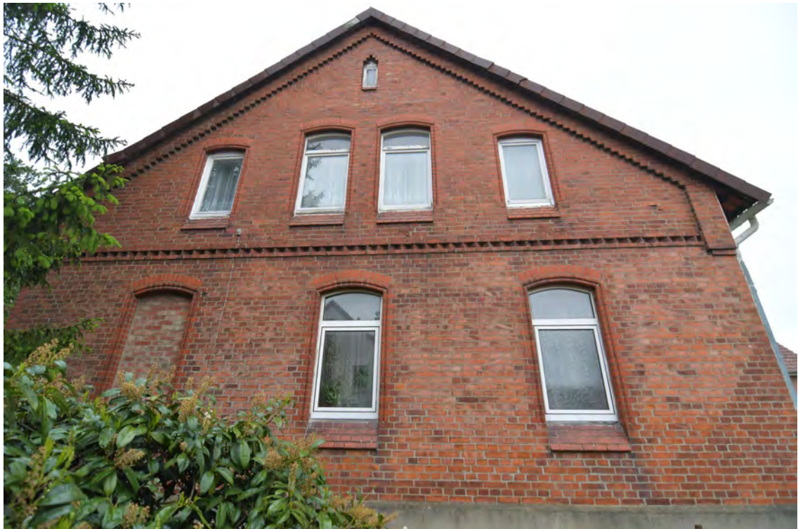
Giebelseite, Ansicht von Süden
