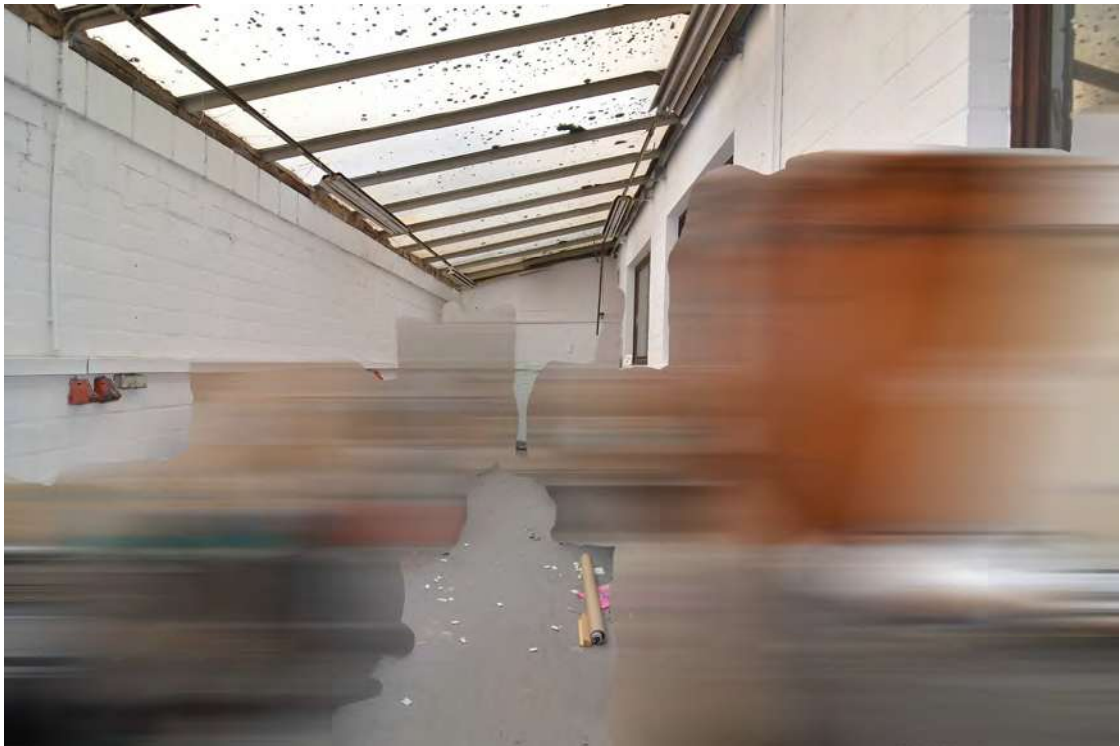
Lagerbereich zwischen östl. Grundstücksgrenze und Halle - das Lagergut wurde optisch unkenntlich gemacht
