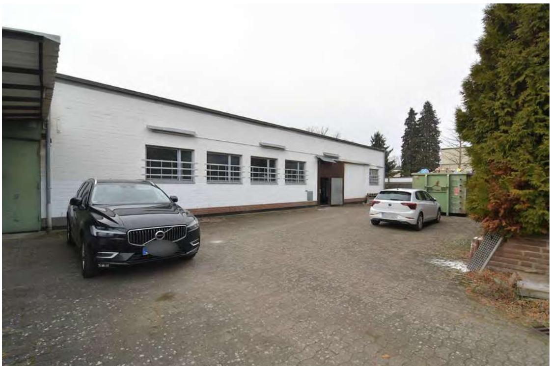
Hofansicht des Werkstattgebäudes
