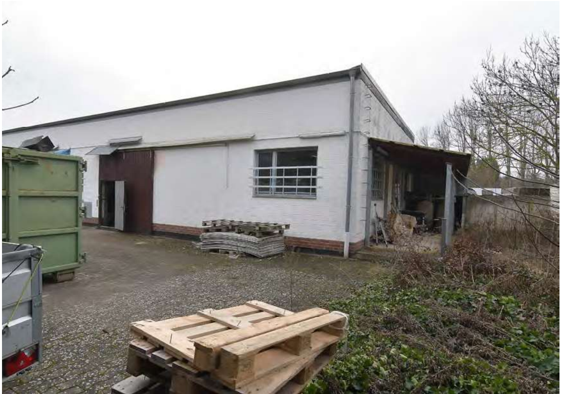
Überdachung an die westl. Giebelwand 2003 angebaut
