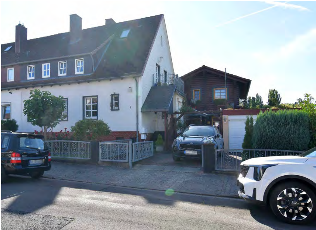
Straßenansicht Straße Deisterblick
