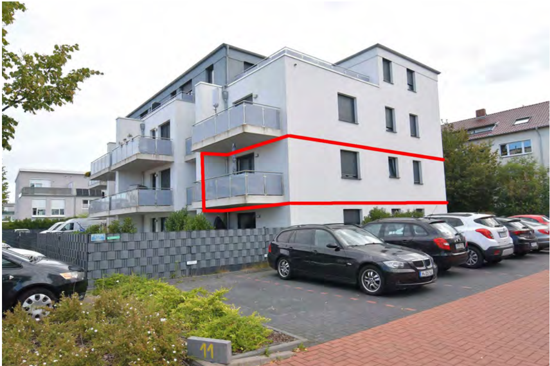
Ansicht von Südosten mit farbiger Kennzeichnung der Wohnung
