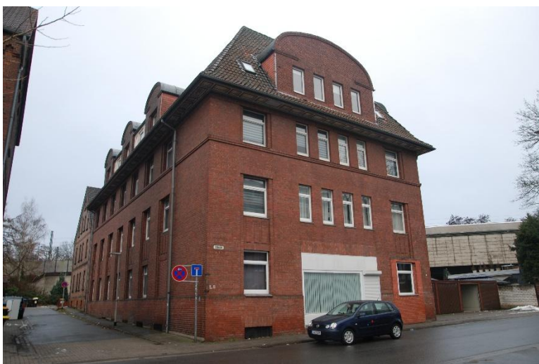
Gesamt-Ansicht von der Straße
